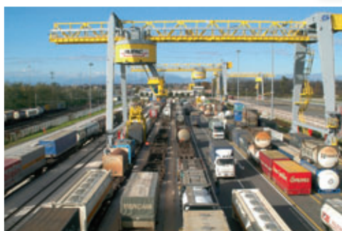
Esempio di binari operativi sotto gru a portale in un terminal intermodale strada-rotaia
