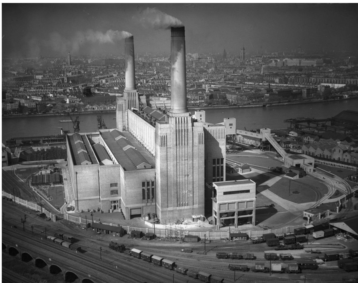
Figura 1. Immagine aerea della centrale in costruzione, completa solo per metà. Anno 1935 circa.
