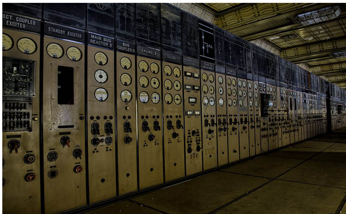
Figura 4. La sala di controllo della centrale, nonostante l'abbandono si è conservata. Sono ancora presenti i soffitti vetrati progettati da Halliday.
