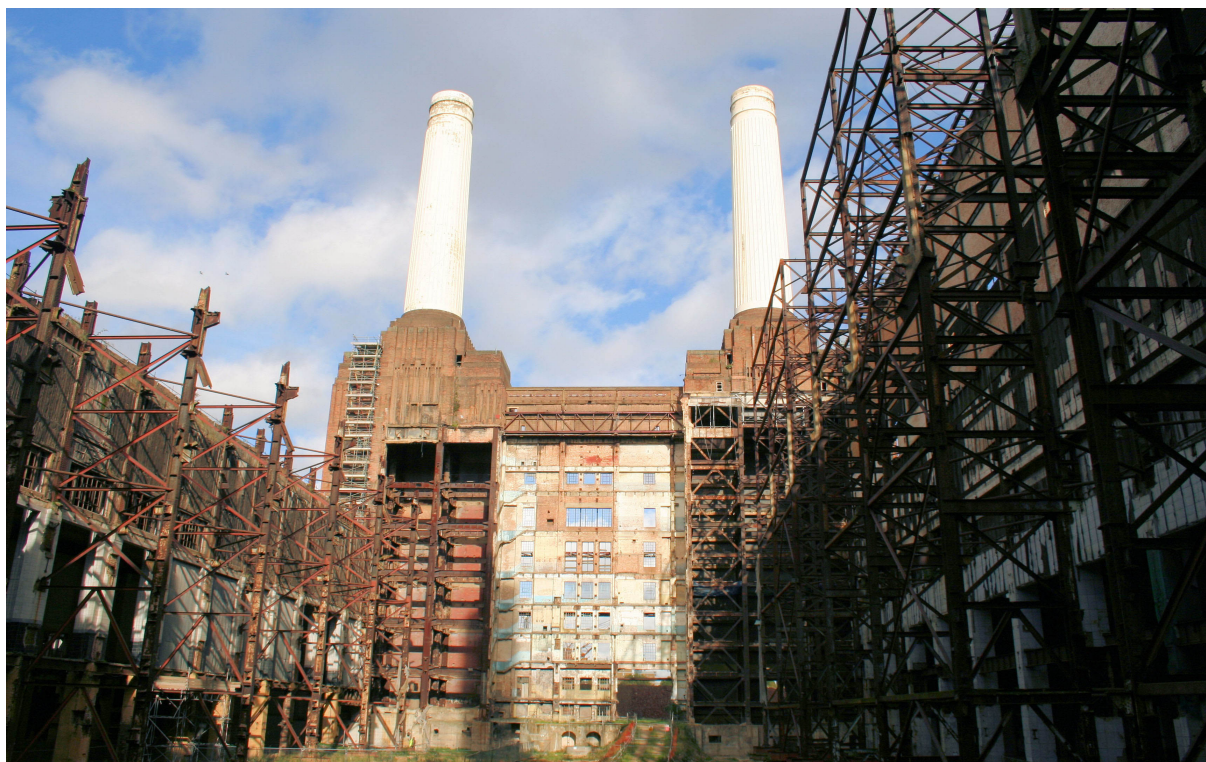
Figura 5. Lo spazio vuoto all'interno della centrale.
