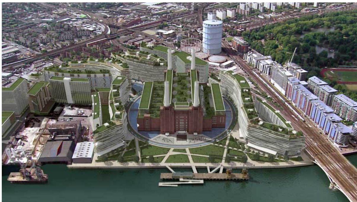
Figura 7. Rendering aereo del progetto in corso di realizzazione. Fonte: http://batterseapowerstation.co.uk/
