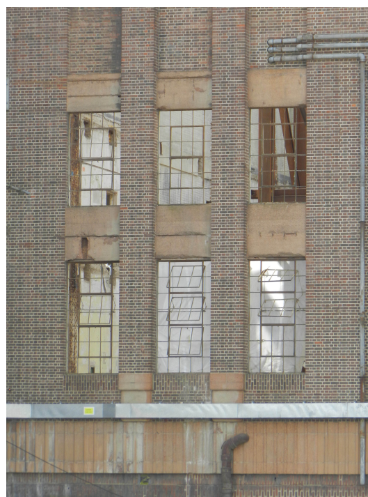
Figura 12. Particolare dei serramenti del prospetto Nord.
