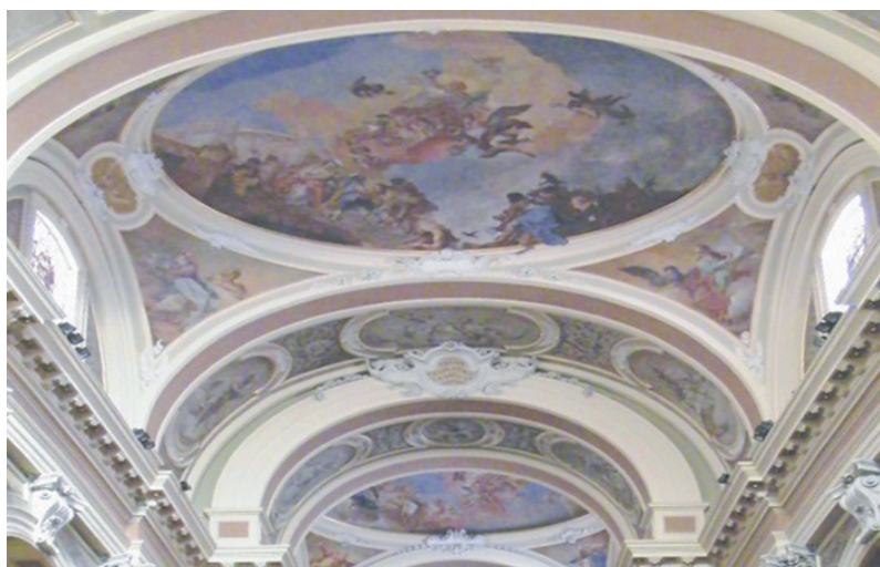
FIG. 2 Borno, Chiesa di San Giovanni Battista: vista della navata Borno, St. John Baptist's Church: view of the nave
