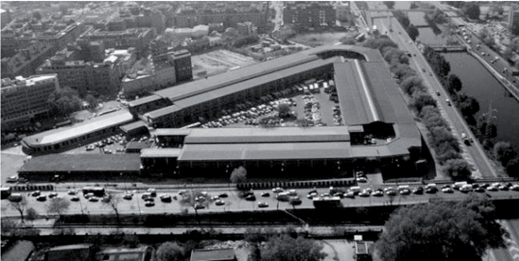
FIG. 1 Madrid, Mercado de Frutas y Verduras: vista aerea Madrid, Mercado de Frutas y Verduras: aerial view
