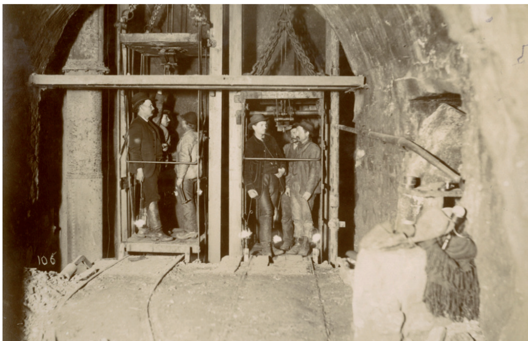
FIG. 2 Monteponi, Pozzo Vittorio Emanuele: le gabbie metalliche per il trasporto dei minatori Monteponi, Vittorio Emanuele shaft: metal cages for transporting miners
