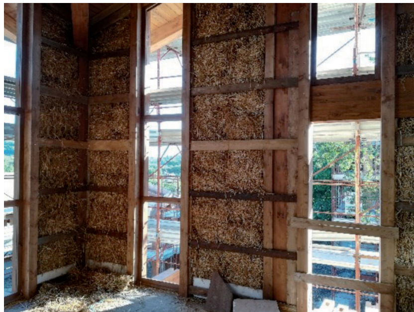
FIG. 1 Assemblaggio delle tamponature in paglia Assembly of straw infill
