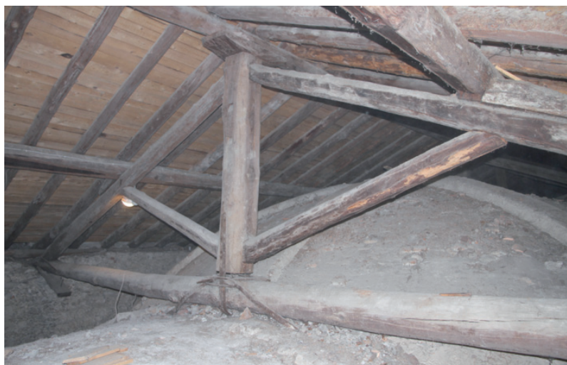
FIG. 3 Borno, Chiesa di San Giovanni Battista: vista di una capriata con il sistema di tiranti metallici inclinati Borno, St. John Baptist's Church: view of a roof truss with the inclined iron tie-rods
