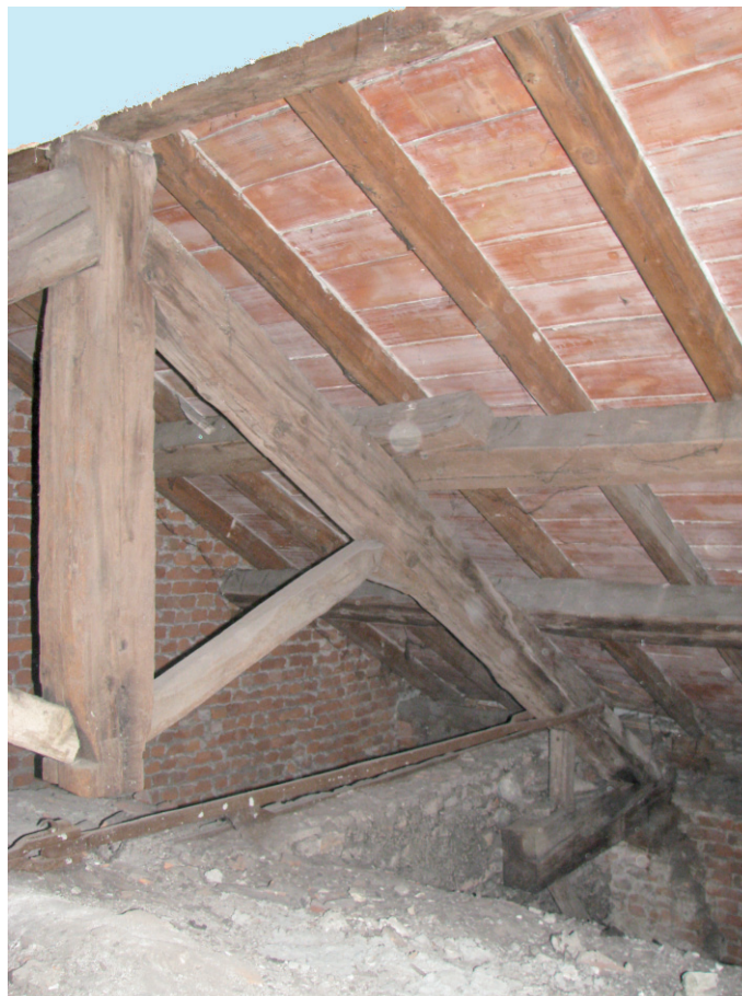
FIG. 2 Pavia, Palazzo dell'Università: vista di una capriata del tetto dello scalone Pavia, University Palace: view of a truss of the grand staircase roof
