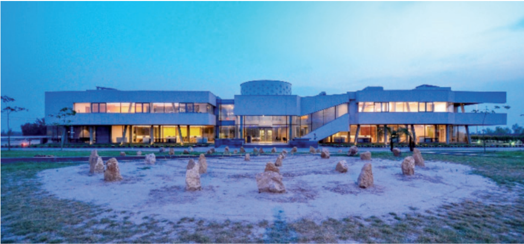
FIG. 1 Faisalabad, edificio per uffici di sviluppo prodotto e marketing: vista dell'entrata principale Faisalabad, Product Development and Marketing Office Building: Main entrance view
