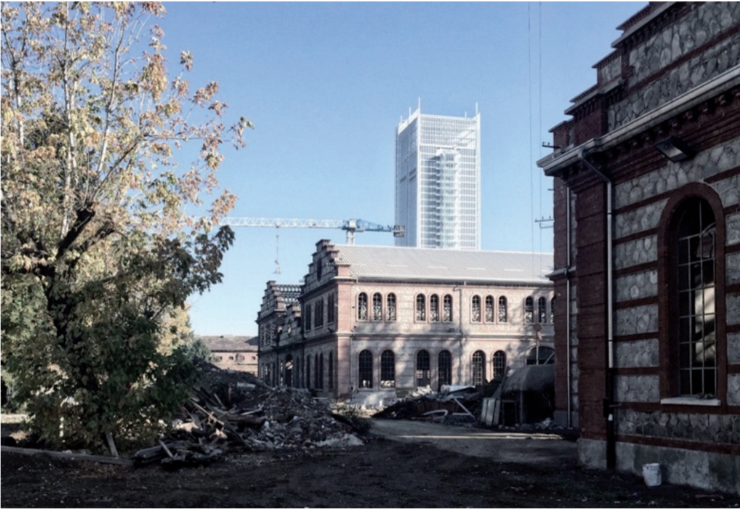
FIG. 1 Torino, OGR Edificio H: fronti Ovest Torino, OGR H building: West side
