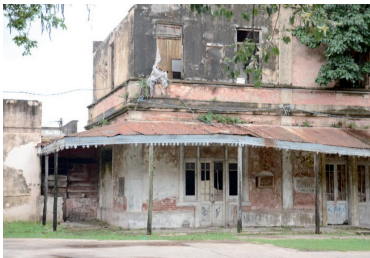
FIG. 1 Palazzina uffici de La Fabril (Resistencia), stato attuale Office building at La Fabril (Resistencia), present state
