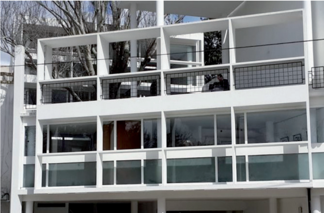
FIG. 1 Le Corbusier, Maison Curutchet, La Plata 1949-55: fronte brise-soleil Le Corbusier, Maison Curutchet, La Plata 1949-55: brise-soleil façade
