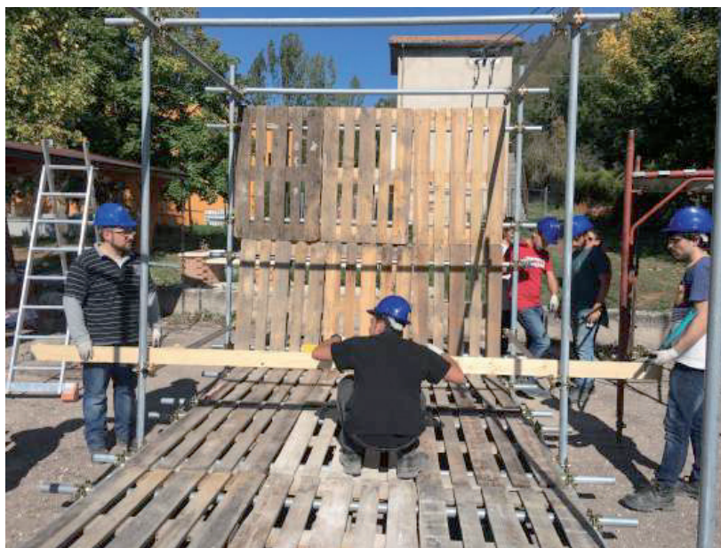
FIG. 1 Autocostruzione in corso del progetto ABBA Self-construction in progress of the project ABBA
