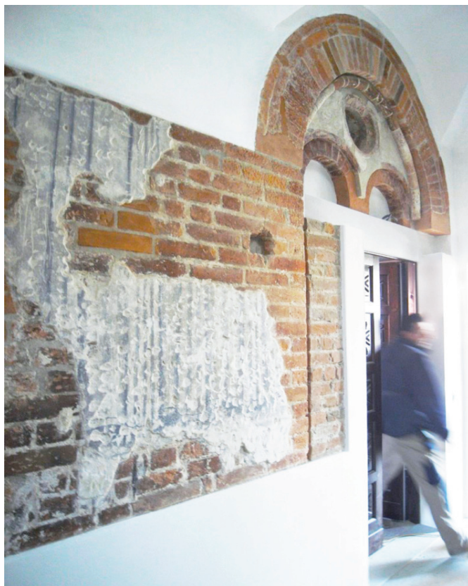
FIG. 2 Alba, Palazzo Govone Caratti: bifora interclusa dopo il restauro Alba, Palazzo Govone Caratti: mullioned locked window after the restoration works
