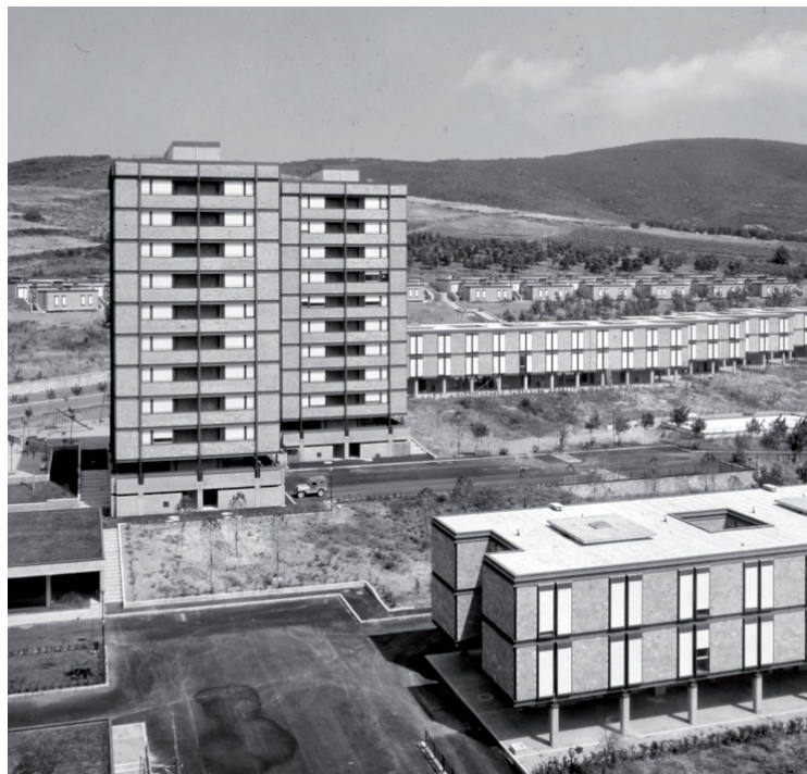
FIG. 2 Piombino, Quartiere CECA di F. Gorio, M. Grisotti, E. Mandolesi, A. Petriagnani, 1963-67: vista d'insieme Piombino, Quartiere CECA di F. Gorio, M. Grisotti, E. Mando- lesi, A. Petriagnani, 1963-67: External view
