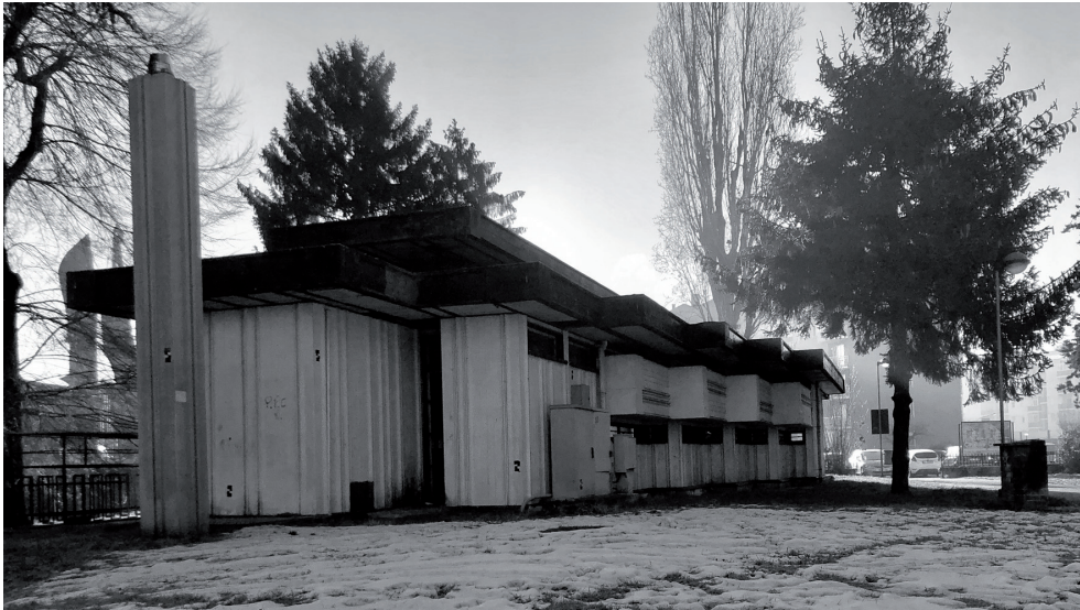
FIG. 1 Biblioteca progettata da Bruno Zevi per la città di Beinasco, esterno Library designed by Bruno Zevi for the city of Beinasco, exterior
