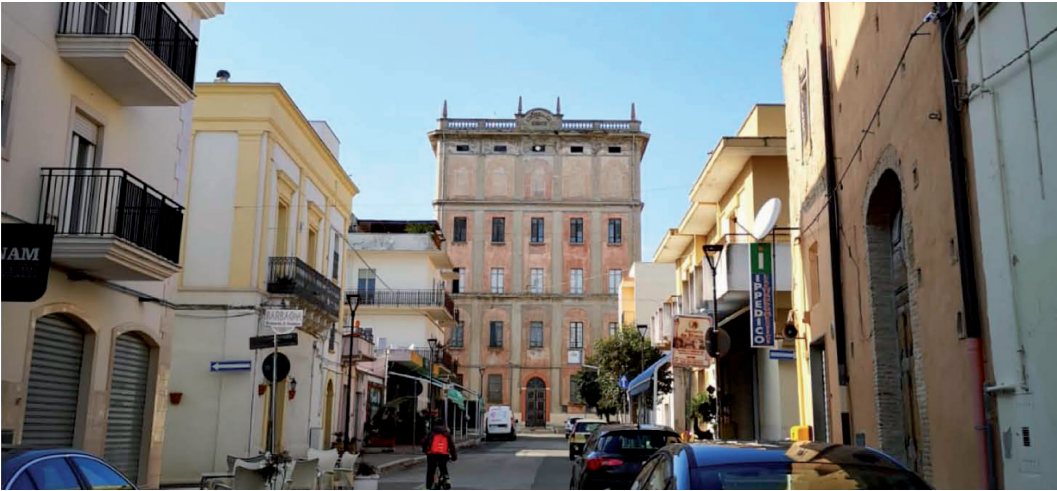
FIG. 1 Bernalda, Ex Acquedotto dell'Agri: prospetto principale Bernalda, Ex Acquedotto dell'Agri: main front
