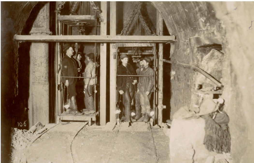
FIG. 2 Montepioni, Pozzo Vittorio Emanuele: le gabbie metalliche per il trasporto dei minatori Montepioni, Vittorio Emanuele shaft: metal cages for transporting miners
