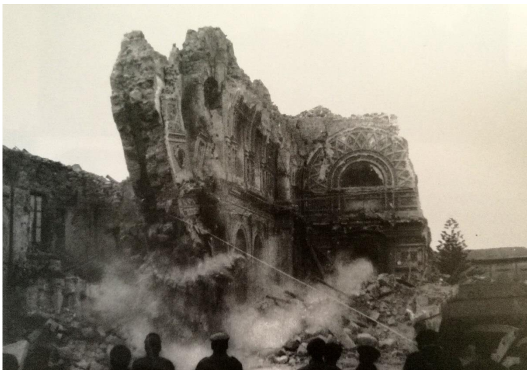
Figura 2.41 - Santa Margherita di Belice. chiesa Madre. Demolizione. I gravi danni causati dal sisma alla chiesa Madre resero necessarie demolizioni controllate delle porzioni pericolanti. Fonte: Scuderi, 2003, 573.
