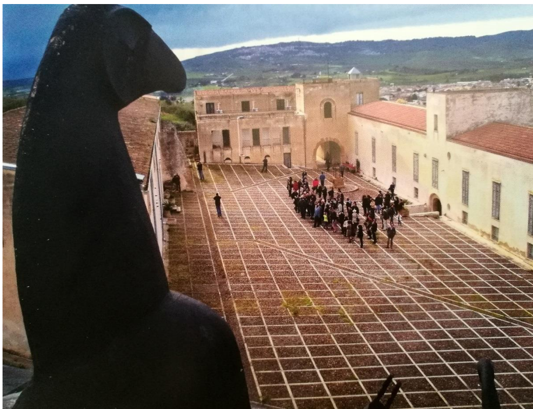
Figura 2.91 – Baglio Di Stefano. Fondazione Orestiadi. L'edificio rifunzionalizzato in centro culturale si inserisce in un complesso processo di ricostruzione anche culturale che ribalta la memoria di Gibellina quale piccolo villaggio a servizio di un feudatario. Fonte: Corà, 2014, 57.
