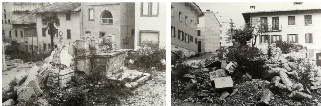
Figura 2.237 - Gemona del Friuli. Chiesa di S. Maria di Fossale. Macerie. Le macerie della chiesa furono addossate alle murature superstiti e lasciate in abbandono per oltre dieci anni. Fonte: Bellina, 1986, 107.
