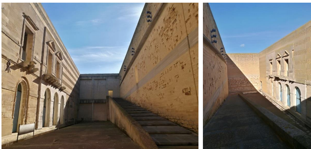
Figura 2.85 – Gibellina Nuova. Palazzo Di Lorenzo. Oggi. L'utilizzo di diversi materiali e la scansione ritmica per fasce orizzontali costruisce una nuova percezione dell'architettura del passato e mette in comunicazione le tracce della memoria con la comunità attraverso un percorso "immersivo". Fonte: Foto dell'autrice, 2017.
