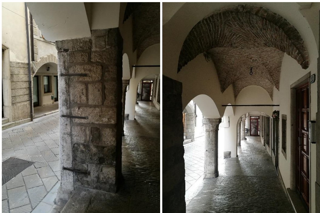
Figura 2.211 - Gemona del Friuli. Via Bini. Portici. La via conduce dal Duomo al Municipio ed è stata interessata da interventi di restauro conservativo tesi alla conservazione delle facciate e degli elementi architettonici più significativi . Fonte: Foto dell'autrice, 2017.
