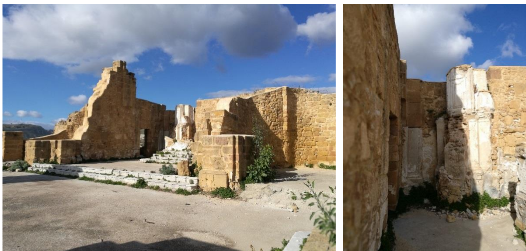
Figura 2.119 – Ruderi di Salaparuta. Chiesa Madre. L'edificio sacro era realizzato con murature in blocchi squadrati di tufo provenienti da cave locali. Fonte: Foto dell'autrice, 2017.
