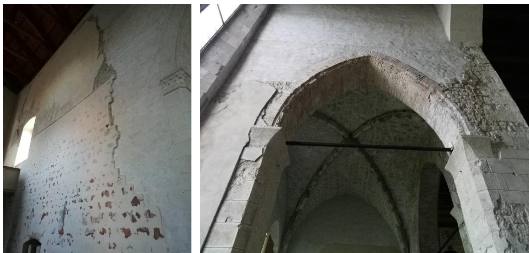
Figura 2.191 – Venzone. Duomo di S. Andrea Apostolo. Interno. Oggi. L'intervento di integrazione delle lacune ebbe come principio la distinguibilità fra pietra autentica, di integrazione o di sostituzione. Fonte: Foto dell'autrice, 2017.
