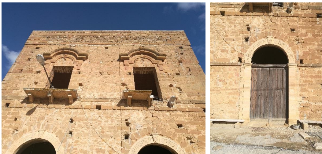
Figura 2.136 – Ruedi di Poggioreale. Palazzo Agosta. Particolare dei balconi e dei portali. L'edificio mostra ricchi elementi decorativi di pregio e denota la presenza di maestranze abili nella lavorazione del tufo. Fonte: Foto dell'autrice, 2017.
