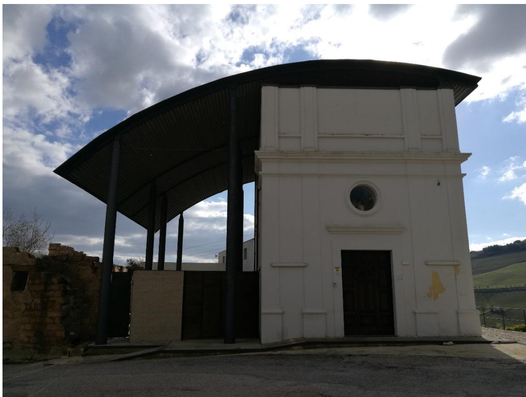
Figura 2.107 – Gibellina Vecchia. chiesa di Santa Caterina. L'intervento di restauro della chiesa si configura come incontro antico-nuovo finalizzato alla ricostruzione parziale dell'edificio e alla sua musealizzazione attraverso l'inserimento di una copertura separata dalla preesistenza e realizzata con tecniche e materiali dichiaratamente moderni. Fonte: Foto dell'autrice, 2017.
