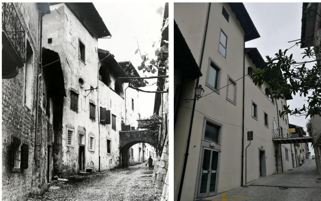
Figura 2.221 - Gemona del Friuli. Ex Palazzo Elti. Ieri e Oggi. La facciata su via dei Conti rispetto a quella su via Bini è stata ricostruita ripristinando parzialmente il disegno originario, conservandone gli aspetti formali e introducendo sostanziali modifiche dovute al suo adeguamento funzionale. Fonte: Archivio fotografico Maieron, Negativo n. 774Ar. Pro-Glemone, Autore: Donato Maieron, 1975 e Foto dell'autrice, 2017.
