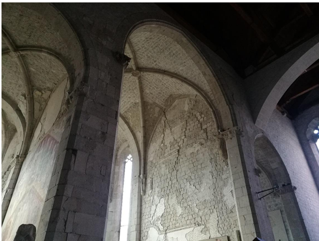
Figura 2.189 – Venzone. Duomo di S. Andrea Apostolo. Interno. Oggi. L'integrità dei concii determinò il loro recupero, catalogazione e ricomposizione virtuale a terra. Fonte: Foto dell'autrice, 2017.
