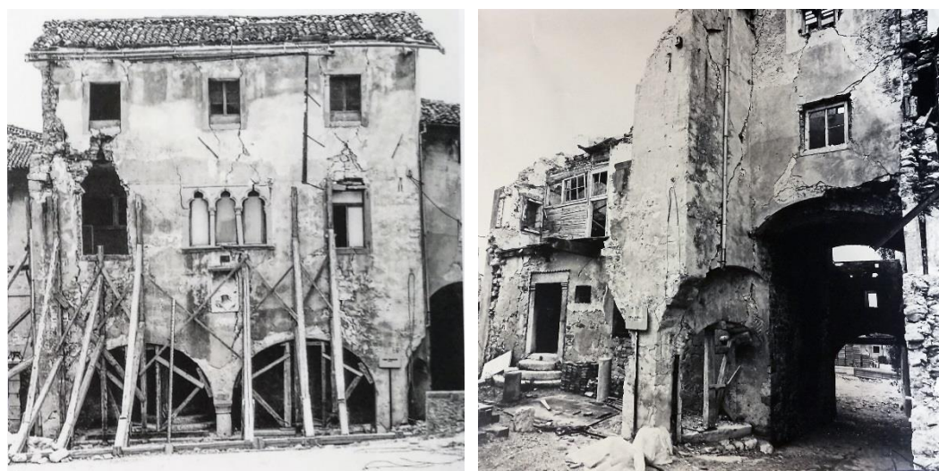
Figura 2.213 - Gemona del Friuli. Casa Gurisatti post sisma. L'edificio a seguito della scossa di maggio e in continuità con quanto definito per via Bini venne puntellato. Fonte: Archivio fotografico Maieron, Negativo n. 894 Pro-Glemone, Autore: Donato Maieron, 1975 e Marino, 2014, 88.
