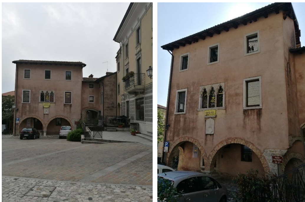
Figura 2.214 - Gemona del Friuli. Casa Gurisatti. Oggi. La ricostruzione del Palazzo risalente al XV secolo quasi completamente distrutto ha consentito di ricomporre la configurazione planimetrica della piazza del Duomo. Fonte: Foto dell'autrice, 2017.
