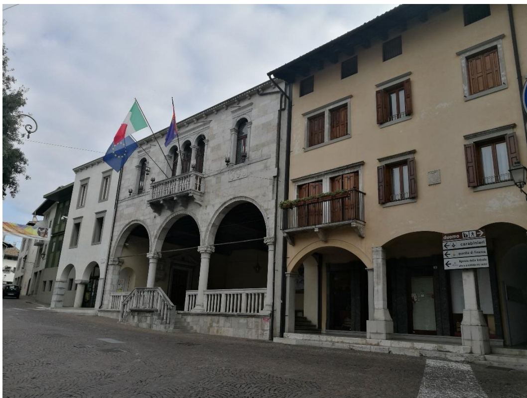
Figura 2.231 – Gemona del Friuli. Palazzo Boton, Sede del Municipio. Oggi. Il Palazzo Boton assieme al Duomo costituisce il caso emblematico della ricostruzione “dov’era, com’era” ed è il punto iniziale del percorso di via Bini che li collega. Fonte: Foto dell’autrice, 2017.
