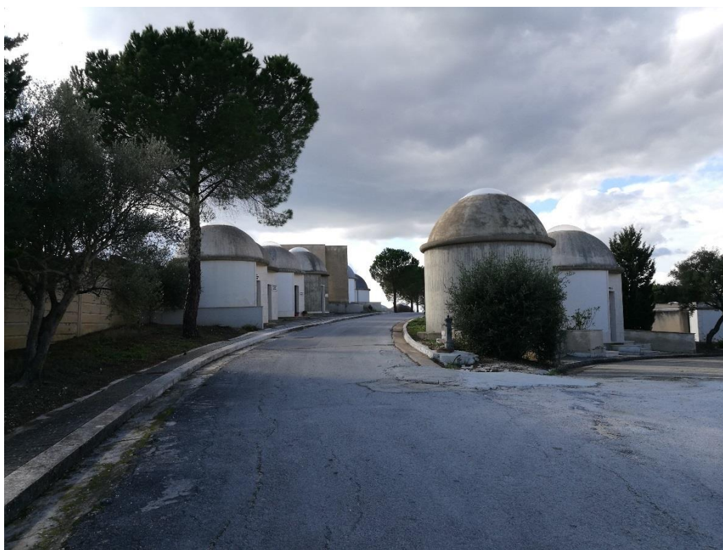
Figura 2.98 - Gibellina Nuova. Cimitero di Consagra. Il nuovo cimitero progettato da Consagra si pone in continuità con la nuova città per caratteri di modernità, estensione e organizzazione. Come nella nuova Gibellina, anche qui all'interno del cimitero, le distanze tra un punto e l'altro si percorrono in automobile. Fonte: Foto dell'autrice, 2017.
