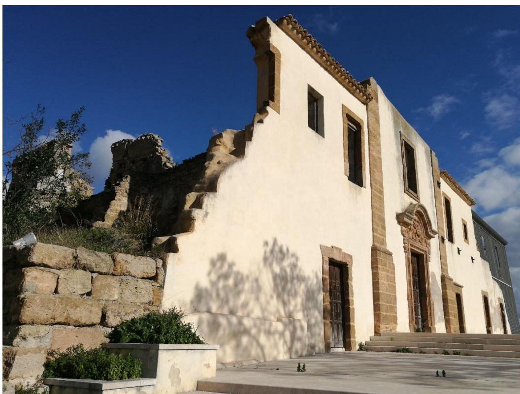
Figura 2.121 – Ruderì di Salaparuta. Ex Convento dei Cappuccini. Il restauro ha interessato la sola porzione di facciata aulica con portale. Altre porzioni sono state ricostruite nei volumi attraverso reti e strutture in acciaio, altre ancora sono state lasciate allo stato di rudere e sono oggi in abbandono. Fonte: Foto dell'autrice, 2017.
