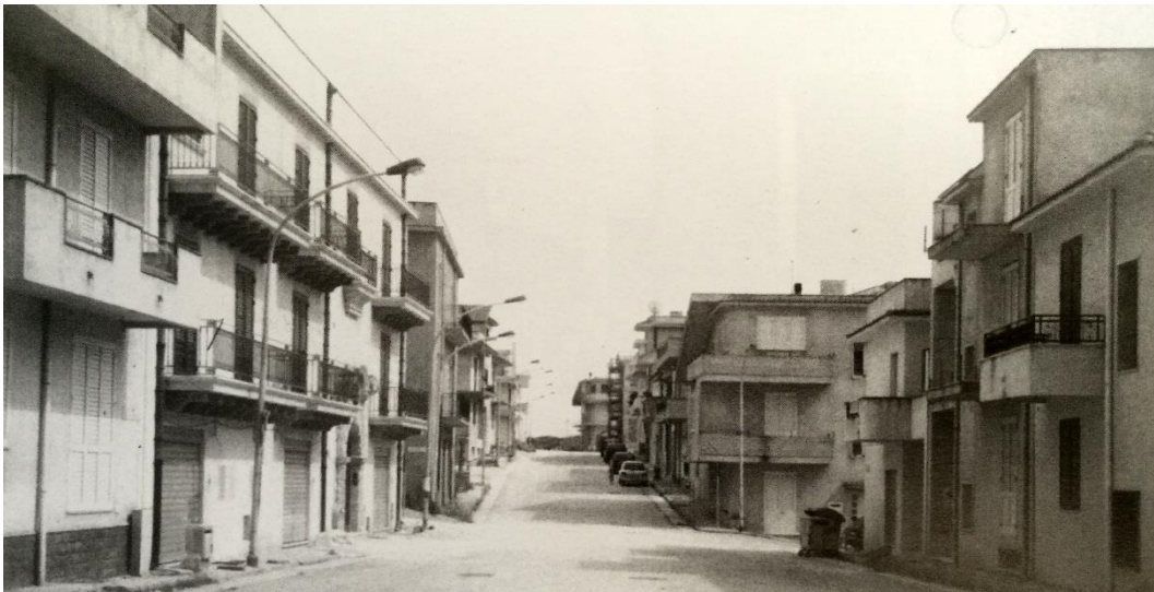
Figura 2.53 - Santa Margherita di Belice. Via dott. Onofrio Abruzzo dopo il sisma. La ricostruzione ha mantenuto il tracciato originario ma ha cancellato la chiesa di San Michele che ne costituiva il punto prospettico. Fonte: Scuderi, 2003, 583.
