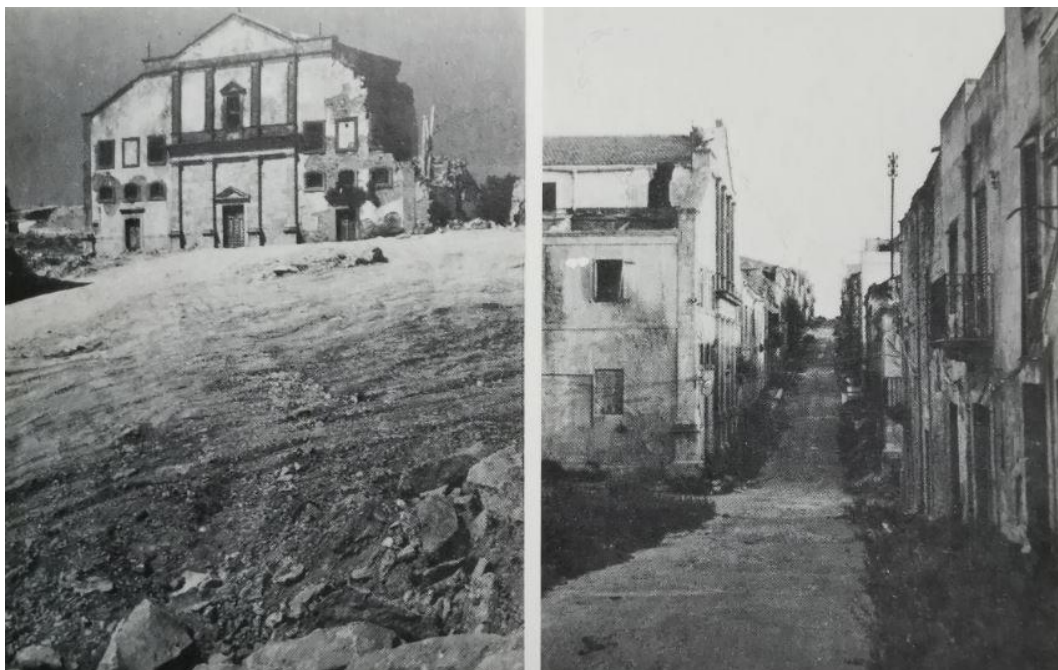
Figura 2.60 - Santa Ninfa. Chiesa della Badia post sisma. L'ambito urbano della chiesa fu interessato nel 1979 da una serie di demolizioni che stravolsero completamente la situazione post terremoto (a destra). Fonte: Renna, De Bonis e Gangemi, 1979, 416.
