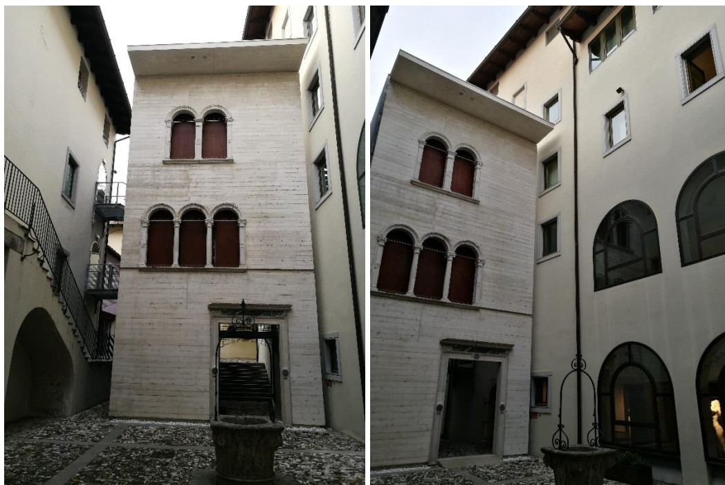
Figura 2.225 - Gemona del Friuli. Palazzo di Caporiacco. Oggi. La ricollocazione dei frammenti lapidei all'interno della corte di Palazzo Elti consente una rilettura di parte della facciata dell'antico Palazzo di Caporiacco. Fonte: Foto dell'autrice, 2017.
