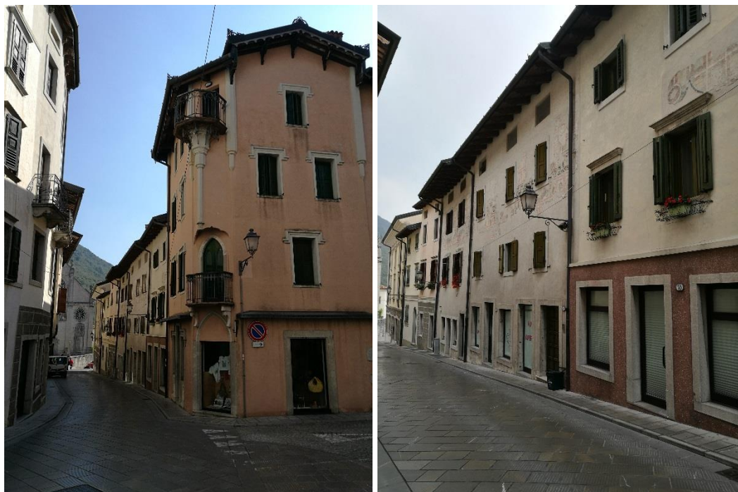
Figura 2.208 - Gemona del Friuli. Via Bini. Area di intervento 13D1. Oggi. Il processo di ricostruzione del tratto di via Bini a ridosso del duomo ha restituito l'immagine ante sisma del fronte continuo sulla via. Fonte: Foto dell'autrice, 2017.
