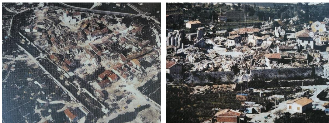
Figura 2.154 - Venzone. Vedute post sisma. Il sisma del 6 maggio 1976 danneggiò gran parte degli edifici del centro storico e causò crolli diffusi. I primi interventi prevedono dunque interventi provvisori lungo le vie principali. I sismi dell'11 e 15 settembre 1976 rasero al suolo il centro storico. Fonte: Bollettino dell'Associazione "Amici di Venzone", 2006, 18-19.
