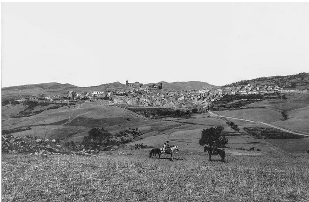
Figura 2.112 – Salaparuta. Vecchio centro. Veduta panoramica ante 1968. Il centro abitato incastonato nel paesaggio agricolo della Valle era addensato attorno al fulcro del Castello e della chiesa Madre che fungevano da vero e proprio landmark. Fonte: Salaparuta Ieri e Oggi.
