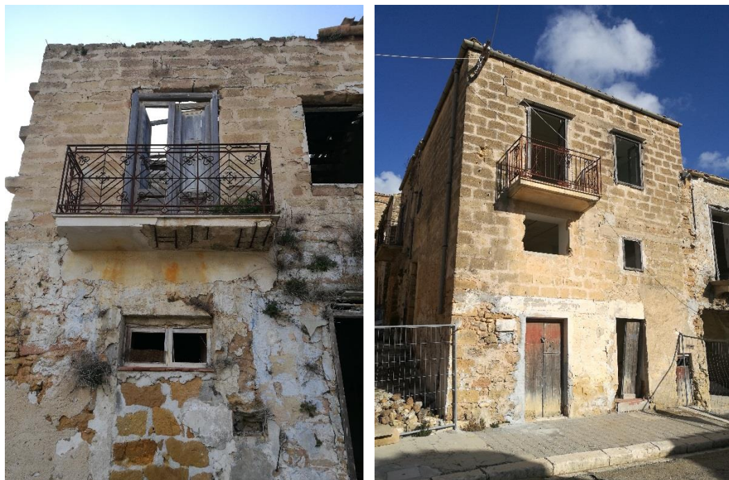
Figura 2.15 – Ruederi di Poggioreale. I quartieri di più recente espansione presentano edifici a struttura mista con elementi strutturali in cemento armato. Fonte: Foto dell'autrice, 2017.
