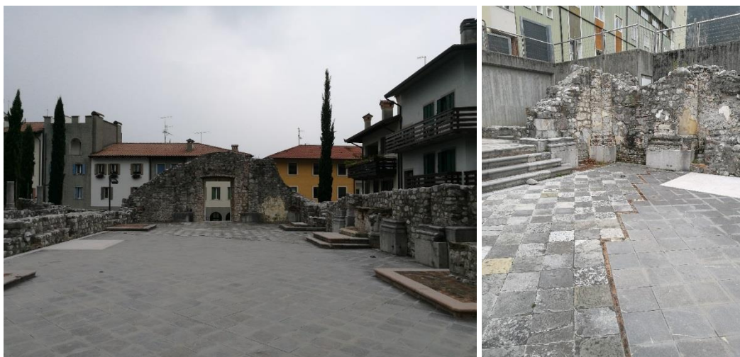
Figura 2.249 - Gemona del Friuli. Ruederi della chiesa Santa Maria delle Grazie. L'intervento di restauro e valorizzazione ha avuto tra gli obiettivi il consolidamento dei resti della chiesa e la messa in evidenza delle tracce della preesistenza rispetto agli interventi di completamento e di integrazione delle lacune. Fonte: Foto dell'autrice, 2017.
