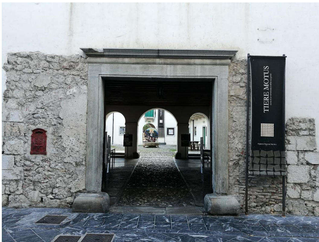
Figura 3.3 - Venzone. Museo Tiere Motus. Ingresso. L'intervento di ricostruzione evidenzia le porzioni superstiti rispetto a quelle realizzate ex novo e restituisce l'immagine lacerata del tessuto edilizio. Fonte: Foto dell'autrice, 2017.
