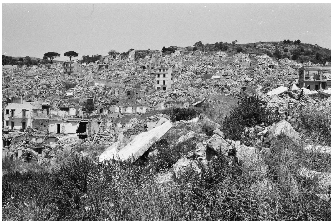
Figura 2.18 - Gibellina Vecchia. Macerie. Il tessuto costituito da abitazioni povere e realizzate con tecniche e materiali di scarsa qualità fu completamente distrutto dal sisma. Fonte: Archivio CRESM.
