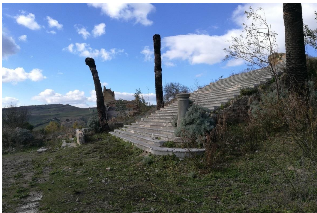
Figura 2.116 – Ruderi di Salaparuta. Chiesa Madre. I resti della scalinata di accesso alla chiesa distrutta dal sisma costituiscono chiari segni della sua magnificenza Fonte: Foto dell'autrice, 2017.
