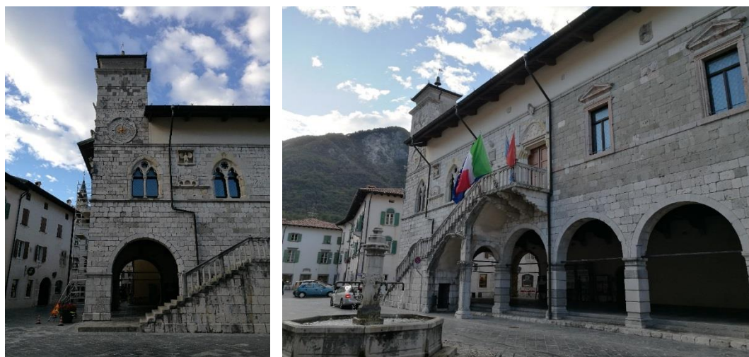
Figura 2.181 – Venzone. Palazzo Comunale. Oggi. Il ripristino dell'ambiente urbano è stato garantito attraverso la ricostruzione delle facciate e degli elementi di arredo che caratterizzavano lo spazio prima dei sismi. Fonte: Foto dell'autrice, 2017.
