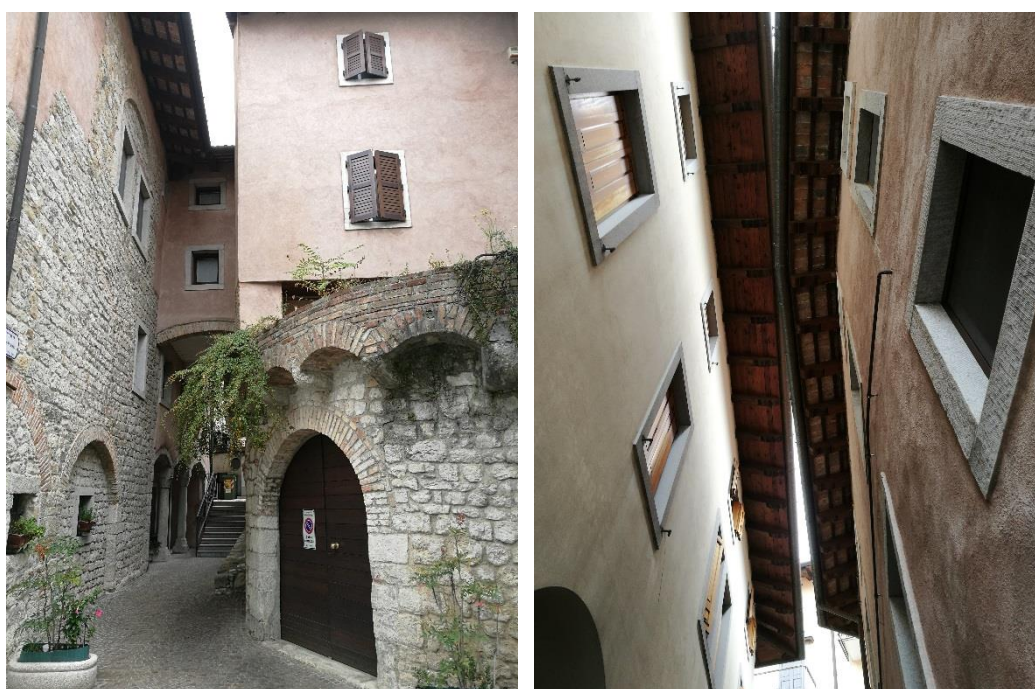
Figura 2.217 - Gemona del Friuli. Casa Gurisatti. Oggi. Particolari. La ricostruzione del tessuto di matrice storica di Gemona ha riconfigurato i caratteri identitari dell'impianto urbanistico, conservando quindi anche la posizione reciproca degli edifici e i percorsi tipici dell'impianto medievale. Fonte: Foto dell'autrice, 2017.
