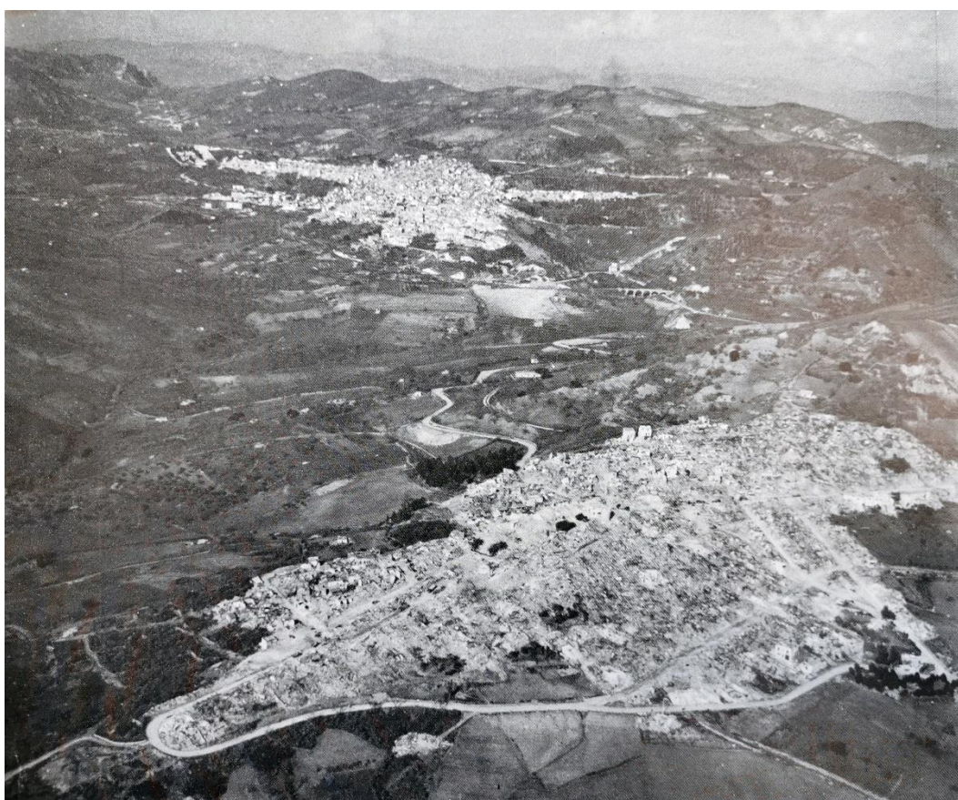
Figura 2.10 – Gibellina e Salaparuta dopo il terremoto. I due centri abitati costituiti prevalentemente da un tessuto edilizio povero e minuto furono gravemente colpiti dal sisma e rasi al suolo. Fonte: Di Maio e Carta, 1970, 74.
