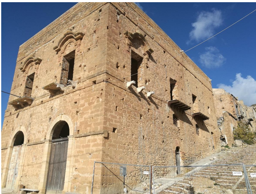
Figura 2.135 – Ruedi di Poggioreale. Palazzo Agosta. L'edificio posto all'ingresso del centro abitato mostra i caratteri tipici dell'architettura locale realizzata con muratura in conci di tufo. Fonte: Foto dell'autrice, 2017.
