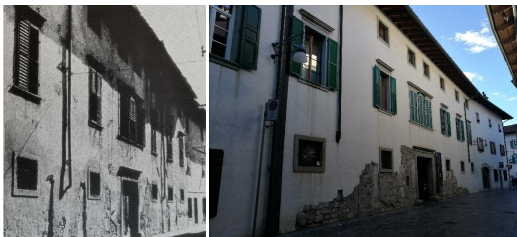
Figura 2.173 - Venzone. Palazzo Orgnani-Martina. Facciata. Ieri e oggi. Le porzioni di muratura superstiti sono state consolidate ed evidenziate rispetto a quelli completamente ricostruite al fine di ripristinare l'assetto planivolumetrico dell'antico centro. Fonte: Segreteria del Convegno Licio Pavan, 1983, 28 e Foto dell'autrice, 2017.
