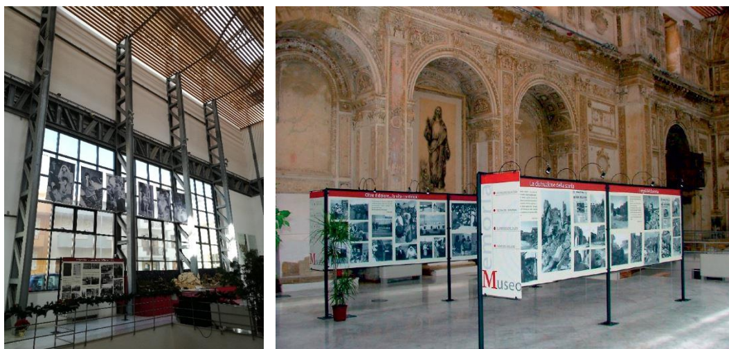
Figura 3.1 - Santa Margherita di Belice. Ex chiesa Madre oggi sede del Museo della Memoria. L'edificio ricostruito mediante una nuova struttura a traliccio metallica, è stato rifunzionalizzato in Museo della Memoria e ospita un'ampia documentazione fotografica del sisma del 1968. Fonte: Foto dell'autrice, 2017 e Cimino, 2018, 87.
