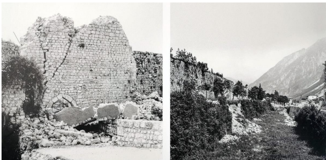
Figura 2.165 - Venzone. Sistema difensivo urbano post sisma. La Torre di Porta San Genesio e l'intera cerchia muraria già interessate da diffusi degni alle strutture furono gravemente danneggiate dalle scosse di maggio. Fonte: Marino, 2014, 116.
