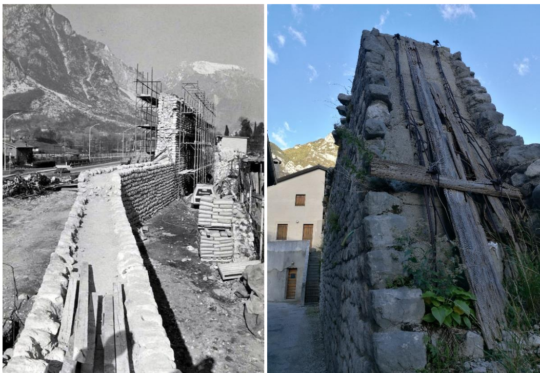
Figura 2.169 - Venzone. Sistema difensivo urbano. Ieri e oggi. La tecnica del “cassero del Gruagno” consentì di realizzare una sorta di muratura a sacco che ricordava quelle originarie e che ancora oggi risulta visibile in alcuni tratti della cerchia muraria non completati. Fonte: Roberto Pirzio Biroli Architetto e Foto dell’autrice, 2017.
