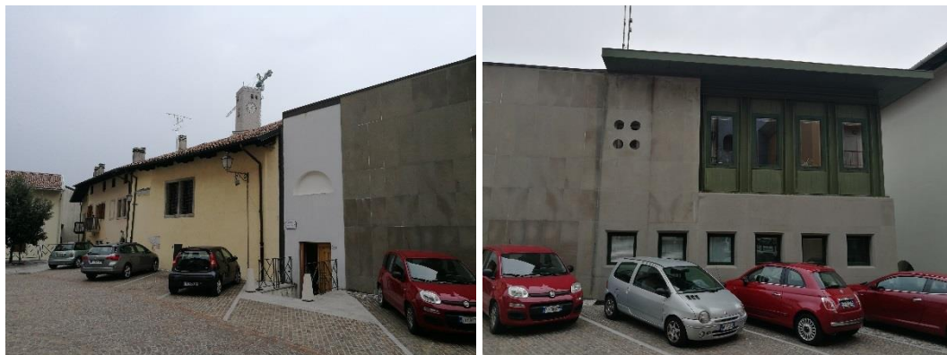
Figura 2.234 - Gemona del Friuli. Palazzo Boton e suo ampliamento. Oggi. La ricostruzione della facciata del municipio su piazzetta Fantoni non è stata finalizzata al ripristino dell'ambiente urbano antecedente al sisma come invece è accaduto per il prospetto su piazza Municipio. Fonte: Foto dell'autrice, 2017.
