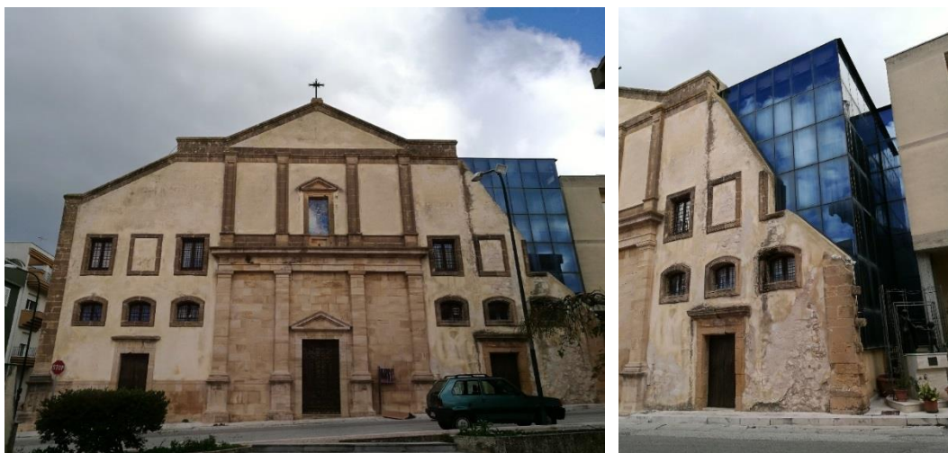
Figura 2.62 – Santa Ninfa. Chiesa della Badia. Oggi. La facciata superstite conserva un doppio ordine di quattro lesene e una cornice marcapiano e due timpani triangolari su finestra e portale. Fonte: Foto dell'autrice, 2017.
