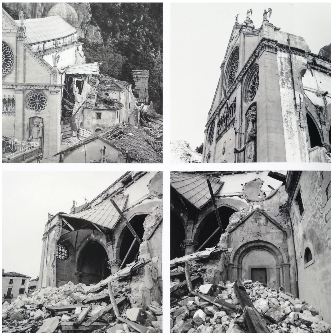
Figura 2.242 - Friuli. Gemona del Friuli. Duomo di Santa Maria Assunta post sisma. I sismi hanno provocato dissesti e crolli diffusi con conseguenti problemi statici che ne hanno compromesso la struttura. Fonte: Marino, 2014, 144.
