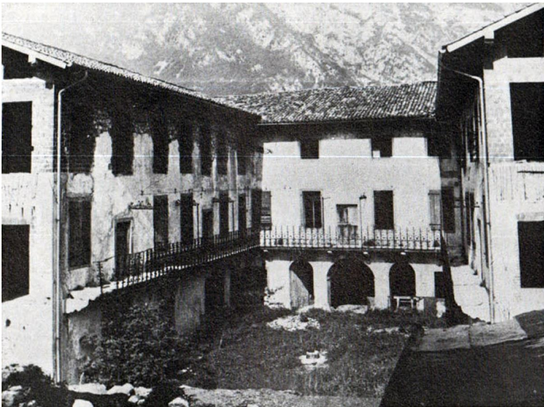
Figura 2.171 - Venzone. Palazzo Orgnani-Martina post 1944. Nel dopoguerra il complesso fu parzialmente ricostruito e restaurato mediante l'impiego di latero-cemento. Fonte: Bollettino “Amici di Venzone” V, 1976, 96.
