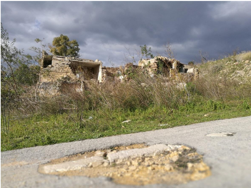
Figura 2.125 - Ruderì di Salaparuta. Lungo la strada di collegamento tra Salaparuta e Poggioreale è possibile ritrovare le tracce del sedime dell'antico tracciato. Fonte: Foto dell'autrice, 2017.
