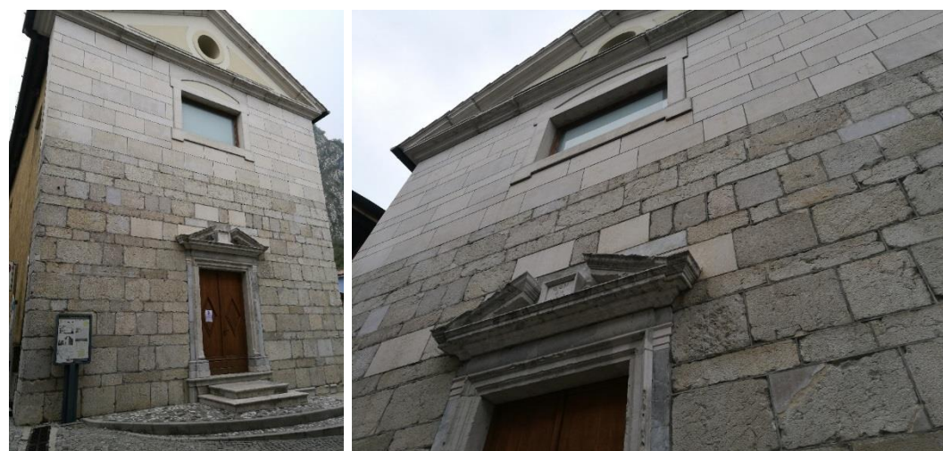
Figura 2.239 - Gemona del Friuli. Chiesa di S. Maria di Fossale. Oggi. Particolare della facciata. La facciata distrutta dal sisma mostra le tracce evidenti della ricostruzione e del completamento della parte sommitale con nuovi materiali. Fonte: Foto dell'autrice, 2017.
