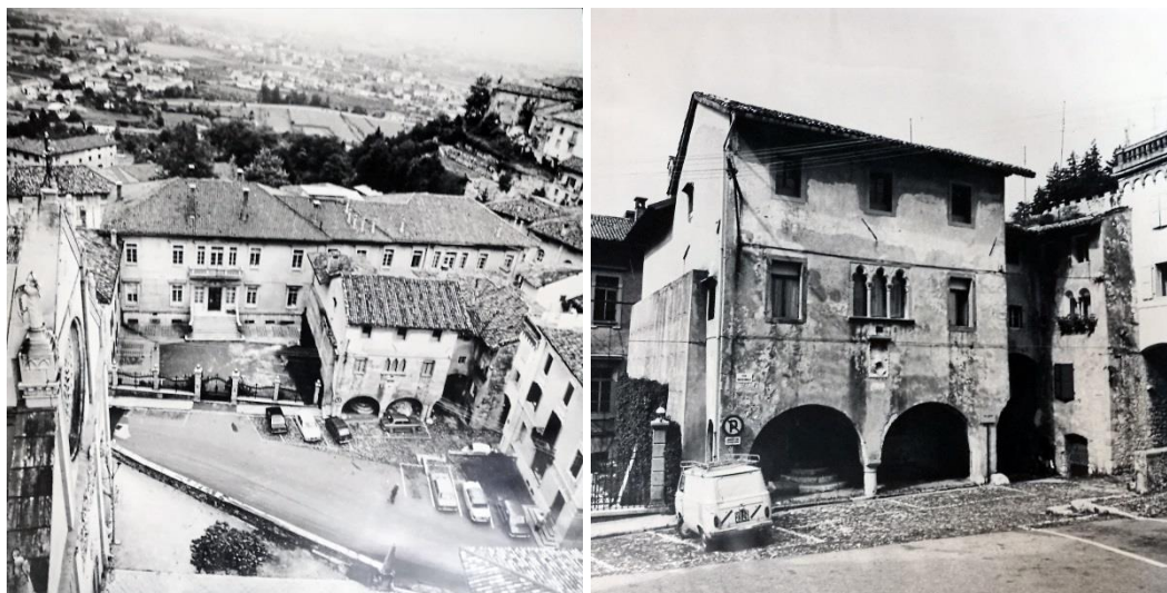
Figura 2.212 - Gemona del Friuli. Casa Gurisatti ante sisma. Il palazzo di origine trecentesca era collocato all'imbocco di via Bini nei pressi del Duomo di S. Andrea Apostolo. Fonte: Archivio Comune di Gemona di Friuli.
