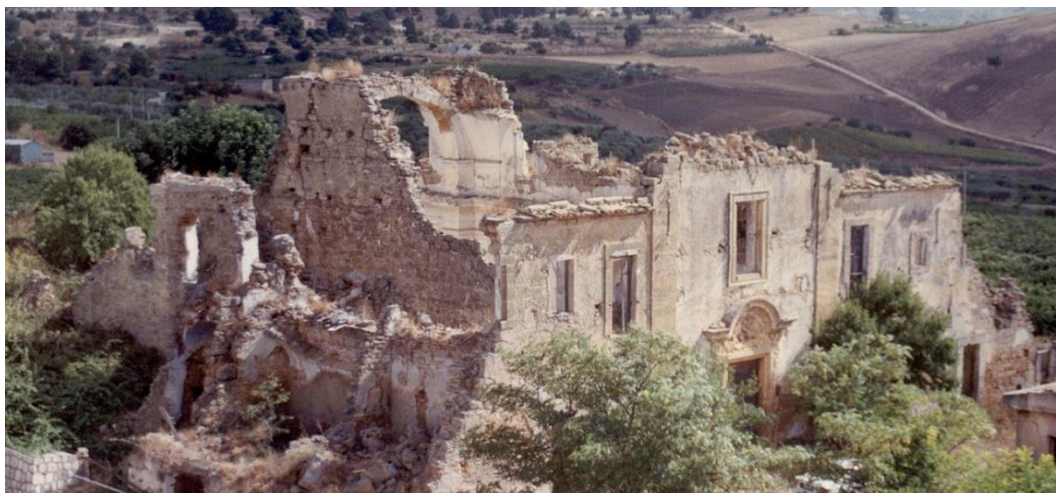
Figura 2.120 – Ruderì di Salaparuta. Ex Convento dei Cappuccini. L'edificio gravemente danneggiato dal sisma del 1968 è rimasto in stato di abbandono fino al 2005. Fonte: Architettutastorica.
