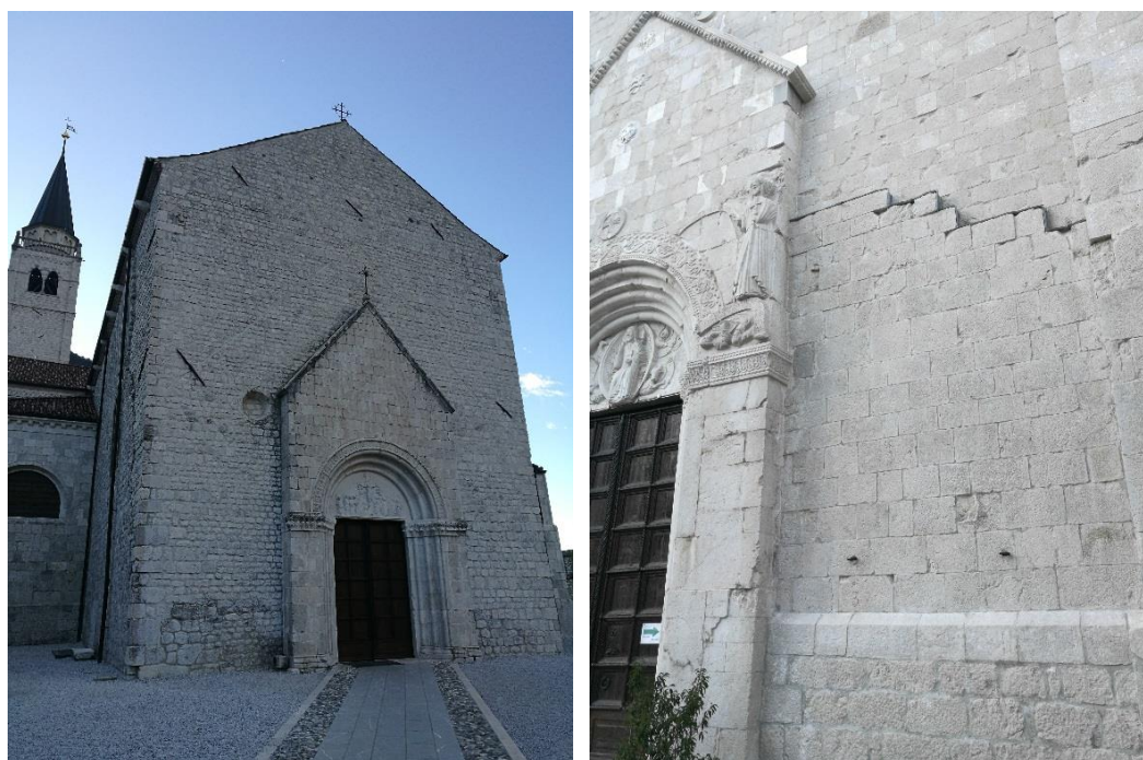
Figura 2.186 – Venzone. Duomo di S. Andrea Apostolo. Facciata. Oggi. L'intervento anastiloscopico ha consentito una ricostruzione “dov'era, com'era” nella quale sono state conservate le evidenze del trauma e i fuori piombo della muratura. Fonte: Foto dell'autrice, 2017.
