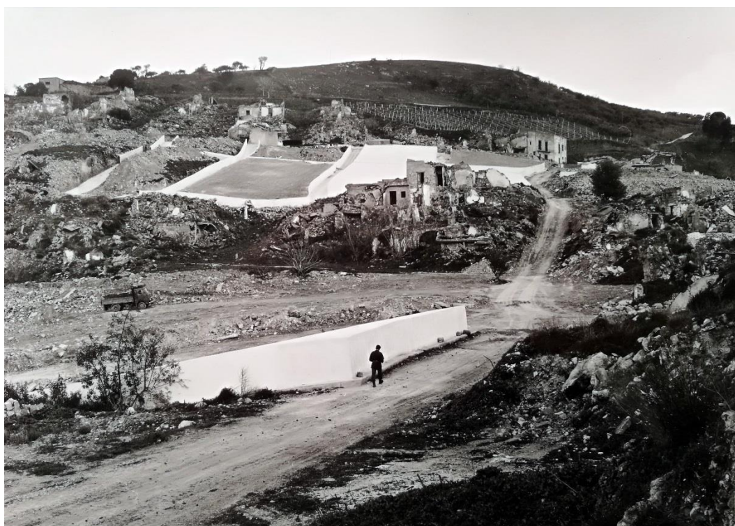
Figura 2.101 - Gibellina Vecchia. Cretto di Burri. Cantiere. La progressiva cancellazione delle rovine di Gibellina attraverso la realizzazione del Grande Cretto registrata da uno scatto di Vittorugo Contino. Fonte: Archivio Comune di Gibellina.
