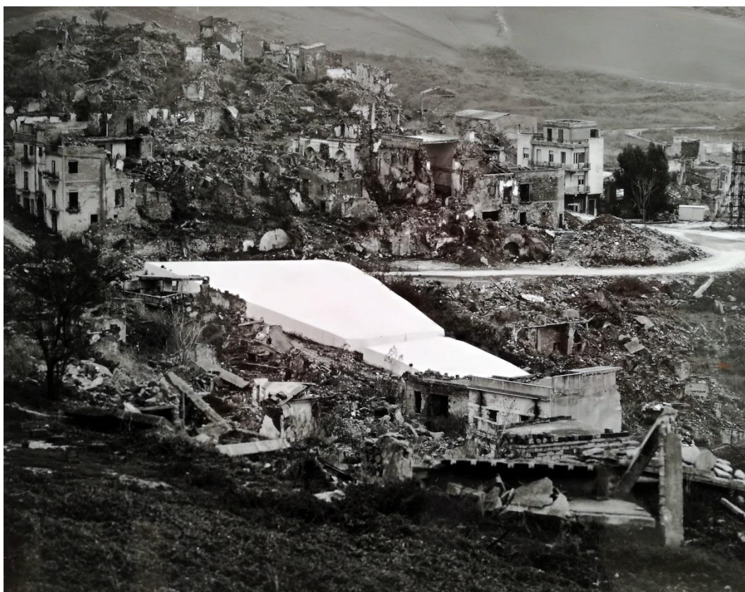
Figura 2.99 – Gibellina Vecchia. Cretto di Burri. Cantiere. Il Grande Cretto in costruzione immortalato nel 1984 in uno scatto di Vittorio Contino . Fonte: Archivio Comune di Gibellina.
