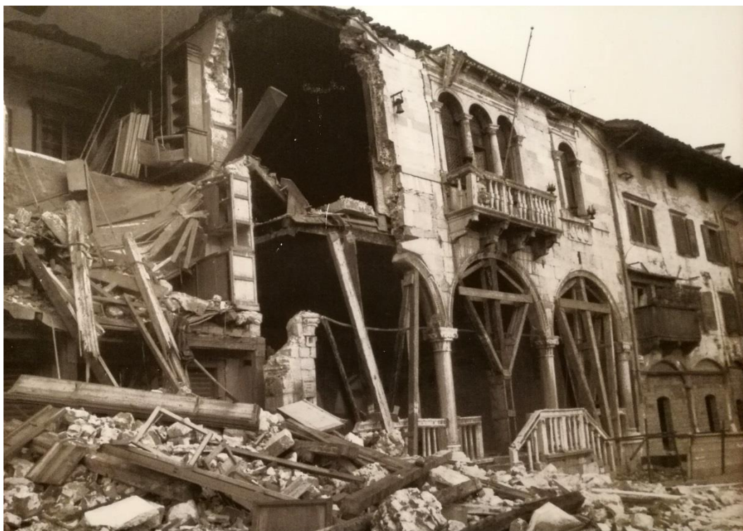
Figura 2.227 - Gemona del Friuli. Palazzo Botòn e Casa Comis post sisma. Le opere provvisorie realizzate a seguito della scossa di maggio impedirono il crollo completo degli edifici. Fonte: Archivio Comune di Gemona del Friuli.
