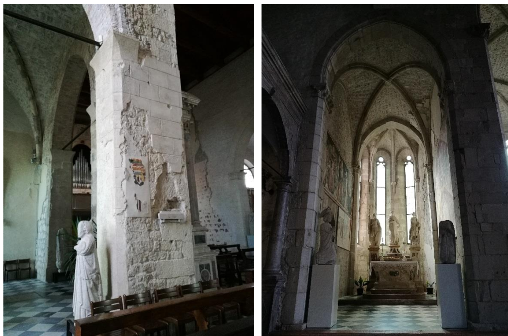
Figura 2.190 – Venzone. Duomo di S. Andrea Apostolo. Interno. Oggi. La ricostruzione dell'edificio ha garantito la salvaguardia degli affreschi trecenteschi e la ricollocazione delle opere d'arte di pregio recuperate a seguito dei sismi. Fonte: Foto dell'autrice, 2017.
