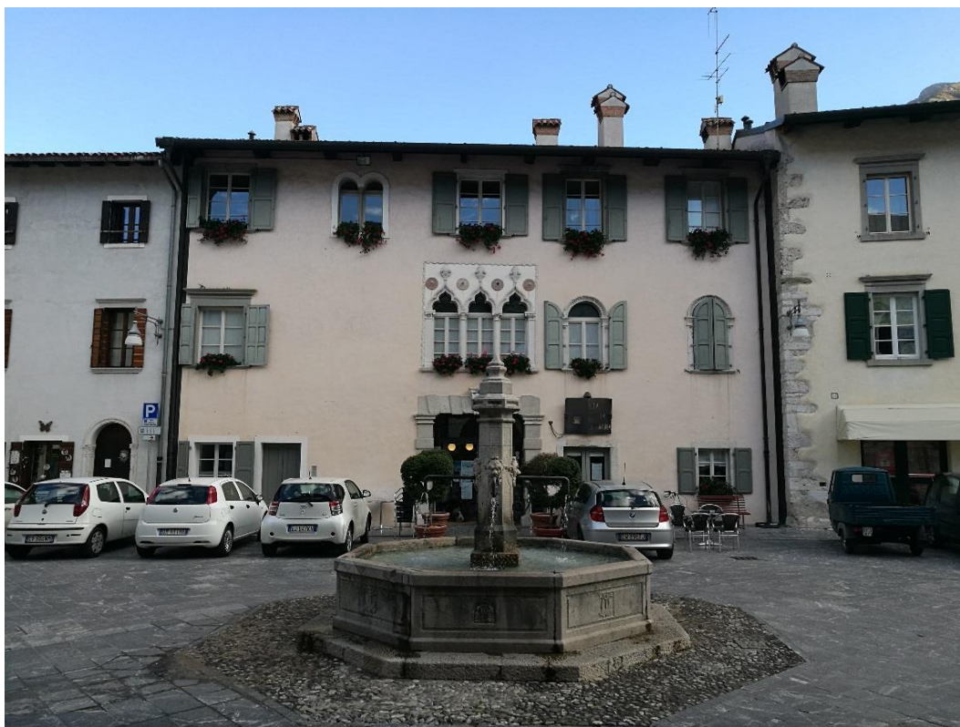
Figura 2.182 - Venzone. Piazza del Municipio. Oggi. Il ripristino di interi ambienti urbani è stato garantito attraverso la ricostruzione delle facciate e degli elementi di arredo che caratterizzavano lo spazio prima dei sismi, come nel caso della fontana pubblica e di Palazzo Radiussi. Fonte: Foto dell'autrice, 2017.
