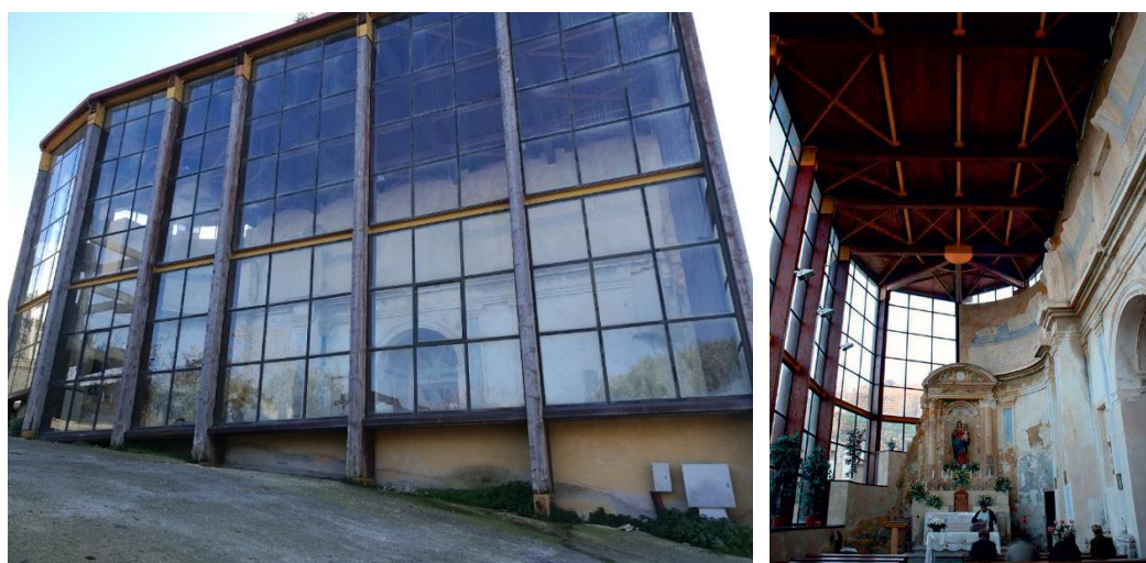
Figura 2.50 - Santa Margherita di Belice. Chiesa di Santa Maria delle Grazie. Oggi. La nuova struttura progettata dall'arch. Benfari si configura come una teca di vetro a protezione dei ruderi della chiesa. Fonte: Foto dell'autrice, 2017 e Cimino, 2018, 159.
