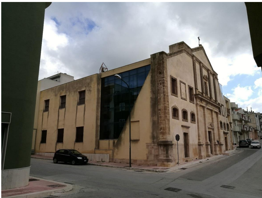
Figura 2.61 – Santa Ninfa. Chiesa della Badia. Oggi. La chiesa realizzata tra XVIII e XIX secolo in seguito all'ampliamento del Conservatorio di Maria Addolorata è stata quasi completamente distrutta dal sisma del 1968 ad eccezione della facciata a capanna completata da un grande timpano. Fonte: Foto dell'autrice, 2017.
