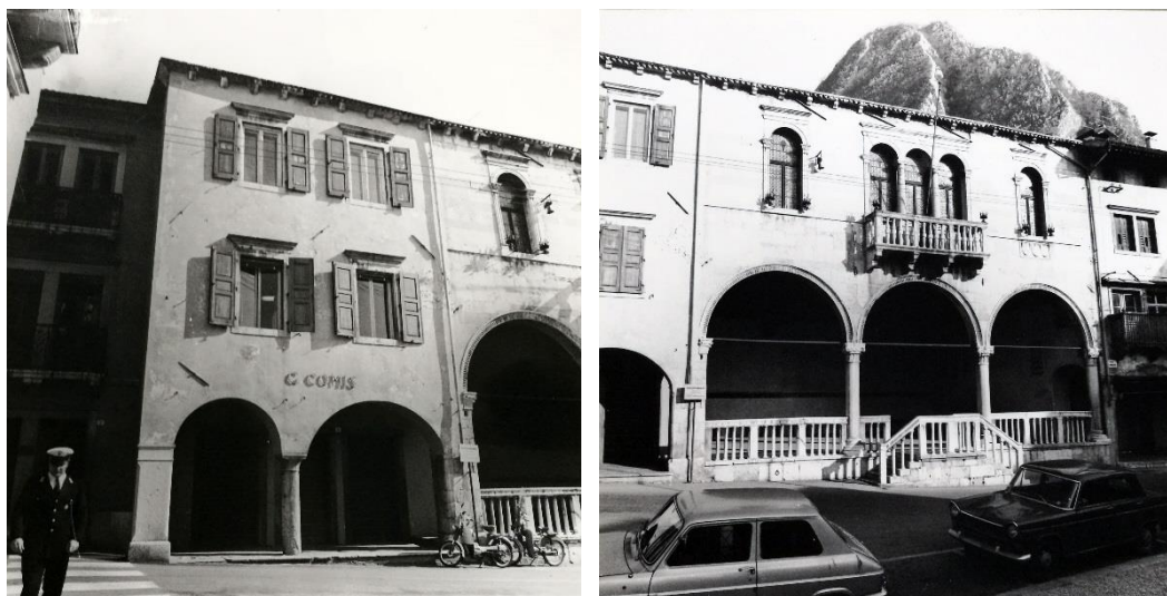
Figura 2.226 - Gemona del Friuli. Palazzo Botòn e Casa Comis ante sisma. I due edifici situati all'imbocco di via Bini caratterizzavano il fronte edilizio prospiciente Piazza Municipio. Fonte: Archivio fotografico Maieron, Negativo n. 1156Ar Pro-Glemone e 620Arch. Pro-Glemone, Autore: Donato Maieron, 1975.
