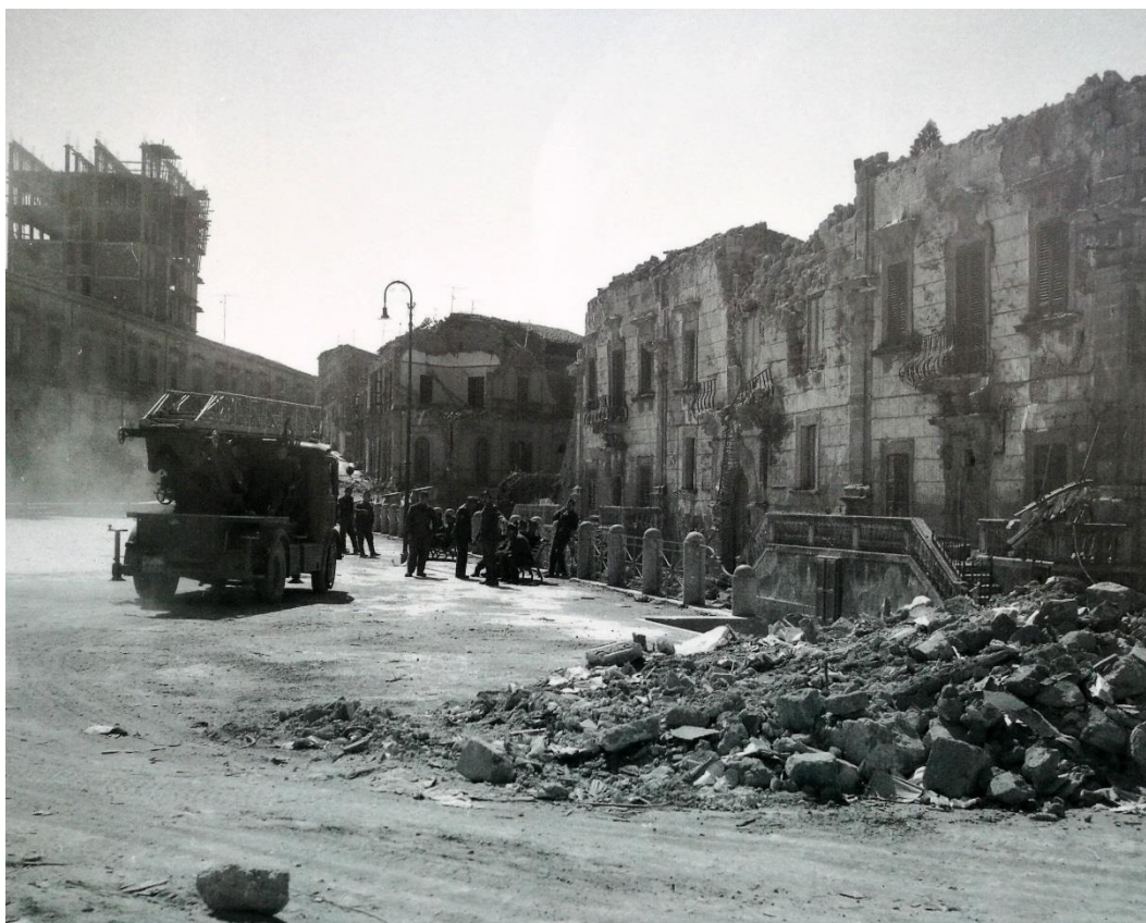
Figura 2.40 - Santa Margherita di Belice. Palazzo Filangeri-Cutò post sisma. Il sisma del 1968 distrusse quasi completamente il complesso che fu ricostruito per restituirne la memoria e l'immagine della città. Fonte: Museo della Memoria di Santa Margherita di Belice.
