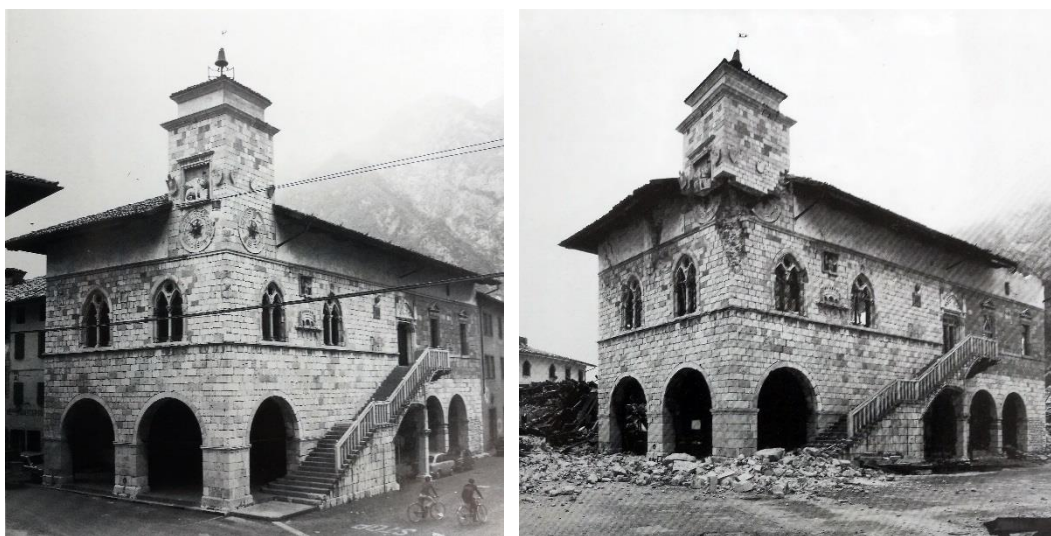
Figura 2.178 - Venzone. Palazzo Comunale ante e post sisma. A sinistra l'edificio dopo la ricostruzione del 1952-1959 mostra la configurazione ante sisma, a destra l'edificio mostra i segni dei danni subiti a seguito delle scosse di settembre 1976. Fonte: Bellina, 1986, 149, 151.
