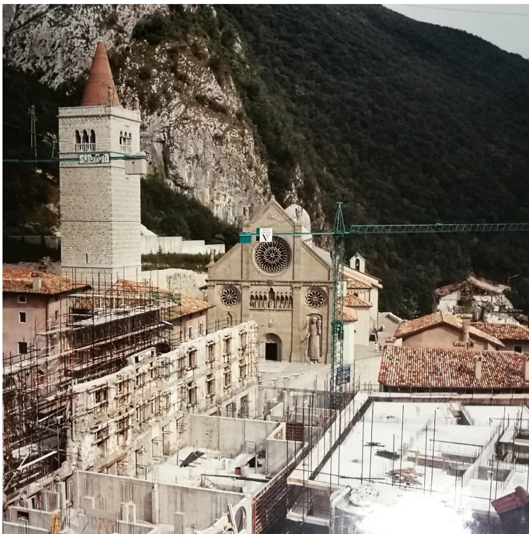
Figura 2.205 - Gemona del Friuli. Via Bini. Cantiere. La ricostruzione della via si articolò nella conservazione delle facciate sottoposte a vincolo e nella costruzione ex novo delle porzioni retrostanti adeguate alle nuove esigenze abitative. Fonte: Archivio Comune di Gemona del Friuli.
