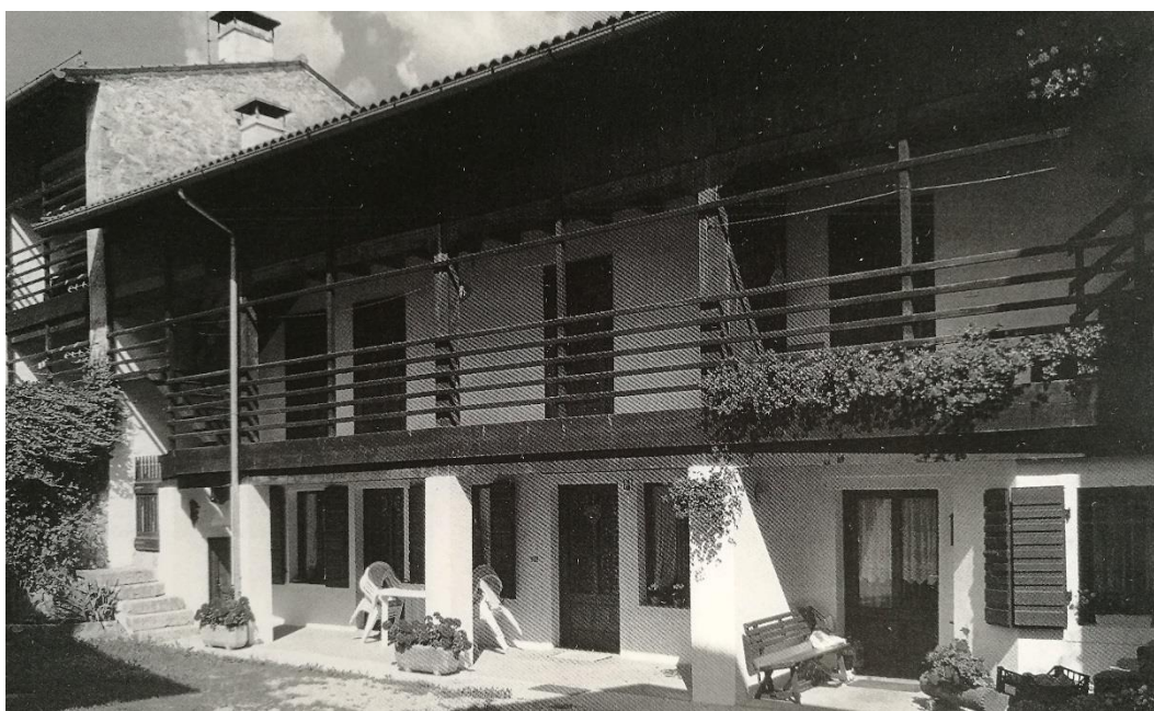
Figura 2.152 - Friuli. Andreis. Dopo l'intervento. L'edificio è stato oggetto di un recupero funzionale e statico che ha consolidato le strutture murarie e sostituito gli elementi degradati per restituire l'aspetto originario. Fonte: Gentilli, 2008, 138.
