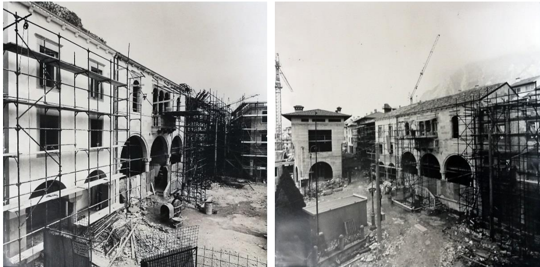
Figura 2.230 - Friuli. Gemona del Friuli. Palazzo Botòn e Casa Comis. Cantiere. I cantieri di ricostruzione dei due edifici su Piazza Municipio garantirono la riconfigurazione dello spazio pubblico cuore della città. Fonte: Archivio Comune di Gemona del Friuli.
