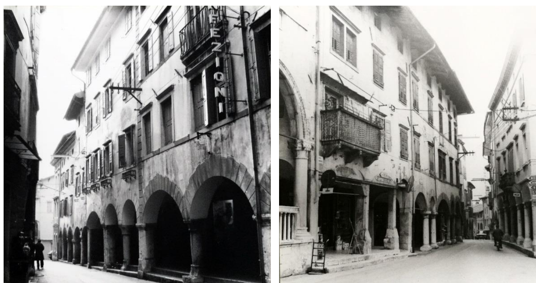
Figura 2.202 - Gemona del Friuli. Via Bini ante sisma. L'asse medievale porticato di collegamento tra Duomo e Municipio fu identificato quale area di massima conservazione. Fonte: Archivio fotografico Maieron, Negativo n. 885 e 801Ar Pro-Glemone, Autore: Donato Maieron, 1975.
