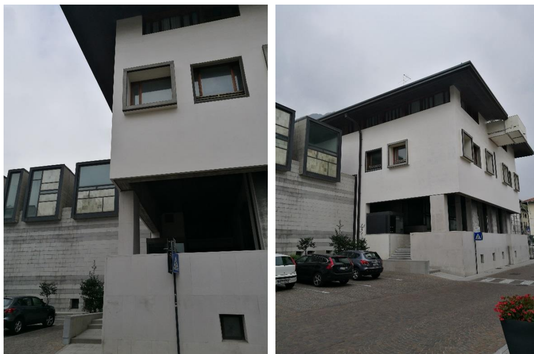
Figura 2.257 - Gemona del Friuli. Ex Banca Popolare. Particolari. Il nuovo edificio si inserisce come cerniera tra una porzione di città completamente nuova e una porzione in cui sono evidenti le tracce della memoria e della conservazione dei valori identitari. Fonte: Foto dell'autrice, 2017.
