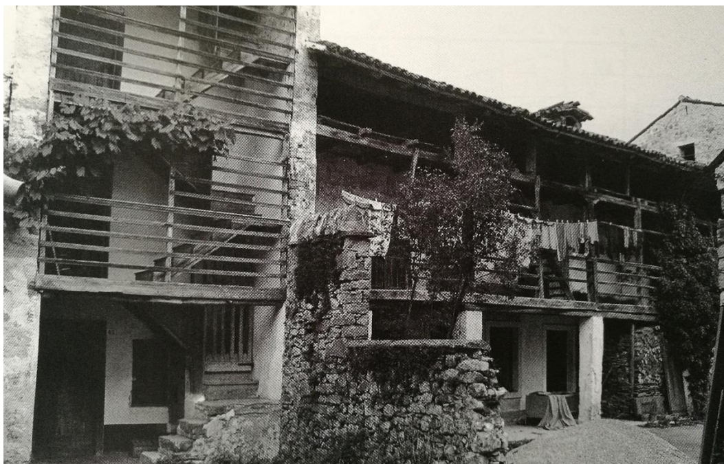
Figura 2.151 - Friuli. Andreis. Prima dell'intervento. L'edificio appartenente ad un complesso più ampio è caratterizzato da murature di pietra intonacate e ballatoio ligneo. Fonte: Gentilli, 2008, 127.
