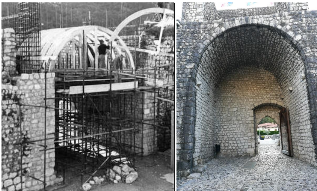
Figura 2.167 - Venzone. Sistema difensivo urbano. Ieri e oggi. Le mura della città furono ricostruite mediante l'impiego della tecnica del "cassero del Gruagno". Fonte: Roberto Pirzio Biroli Architetto e Foto dell'autrice, 2017.
