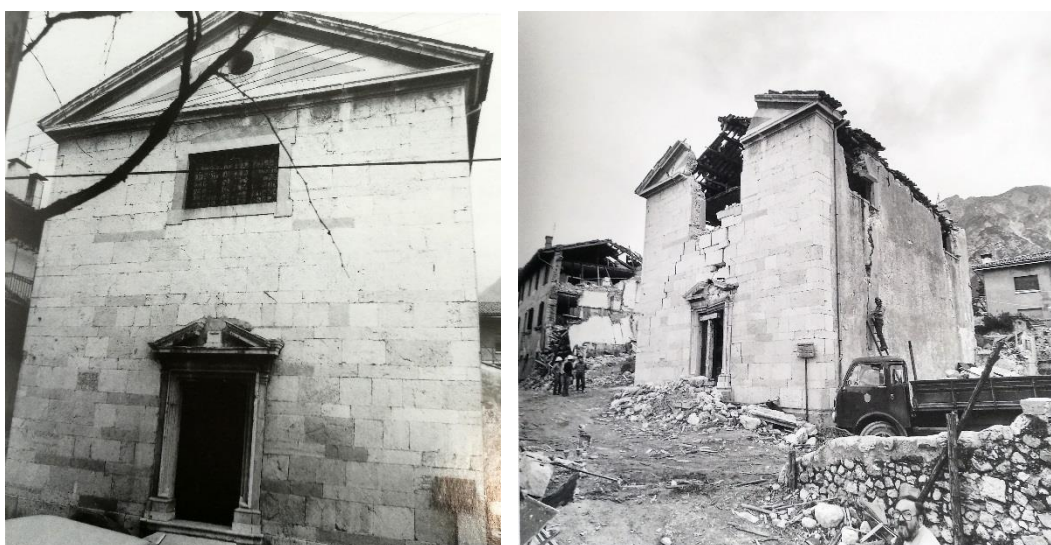
Figura 2.235 - Gemona del Friuli. Chiesa di S. Maria di Fossale ante e post sisma. Le scosse del 6 maggio 1976 provocarono lesioni diffuse e il crollo della sacrestia e della parete centrale del timpano. Fonte: Bellina, 1986, 103, 105.
