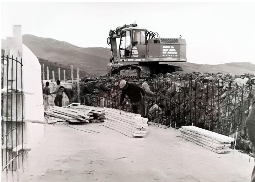
Figura 2.100 - Gibellina Vecchia. Cretto di Burri. Cantiere. La fotografia di Vittorugo Contino mostra le rovine di Gibellina arginate in reti metalliche e amalgamate nel cemento bianco. Fonte: Archivio Comune di Gibellina.
