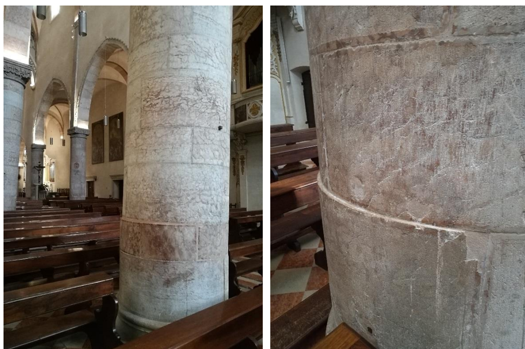
Figura 2.246 – Gemona del Friuli. Duomo. Oggi. Interno. La volontà di conservare la memoria del sisma ha determinato un intervento di restauro strutturale che ha consentito di “congelare” il movimento dei conci e l'inclinazione delle colonne dovuta al meccanismo innescato dal sisma. Fonte: Foto dell'autrice, 2017.
