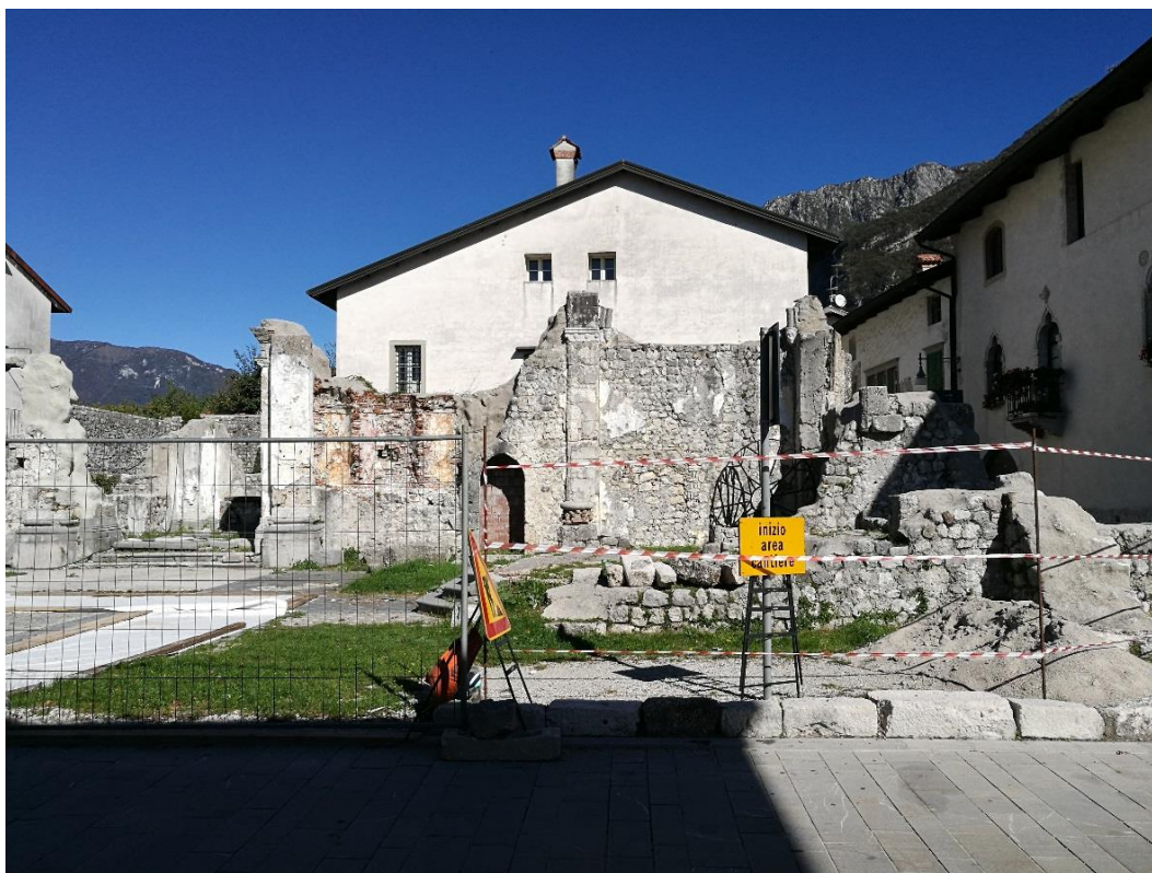
Figura 2.196 - Venzone. Ruederi della chiesa di San Giovanni Battista. Le porzioni superstiti oggi in corso di restauro sono state prontamente salvaguardate dalle demolizioni indiscriminate e consolidate nei giorni successivi al terremoto.
