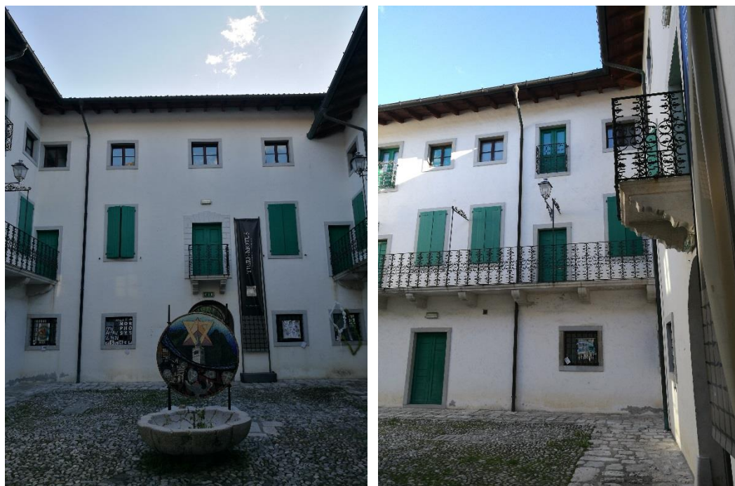
Figura 2.175 - Venzone. Palazzo Orgnani-Martina. Cortile interno. Oggi. Il processo di ricostruzione ha restituito filologicamente il complesso oggi rifunzionalizzato in museo della memoria. Fonte: Foto dell'autrice, 2017.
