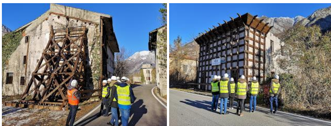
Figura 3.14 – Portis Vecchio. Gli edifici superstiti di Portis fanno parte del campo di addestramento della SERM.Academy nel quale vengono testate tecnologie e procedure innovative messe a punto dal laboratorio SPRINT dell'Università degli Studi di Udine. Fonte: Sprint Blog.
