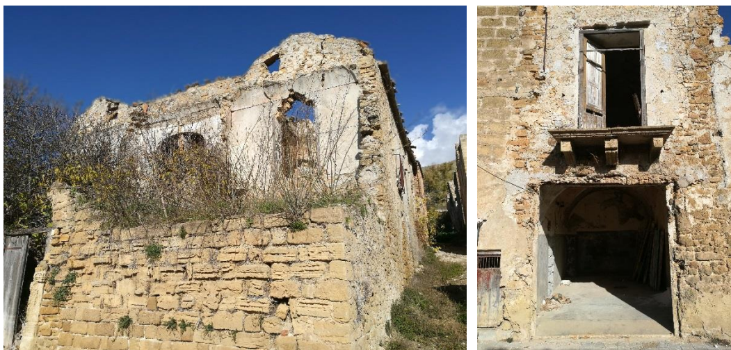
Figura 2.12 – Ruedi di Poggioreale. Le murature degli edifici sono caratterizzate dall'impiego di grandi blocchi squadrati o di diversa dimensione disposti in modo più o meno regolare. Fonte: Foto dell'autrice, 2017.
