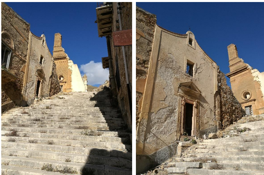
Figura 2.134 – Ruedi di Poggioreale. Ruedi della chiesa Madre. La chiesa matrice era collocata in posizione preminente e isolata rispetto al tessuto costruito. Altri edifici religiosi erano incastonati nelle insulae a formare una cortina continua sui percorsi pedonali come la Cappella del Purgatorio risalente al XVIII secolo. Fonte: Foto dell'autrice, 2017.
