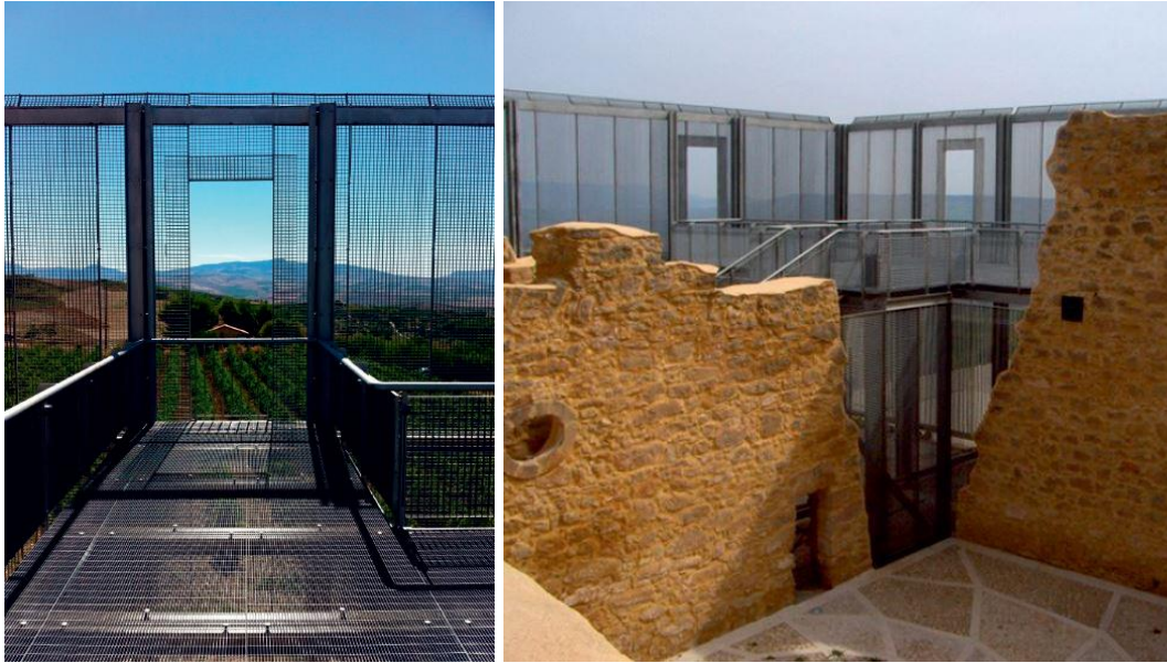
Figura 2.124 – Ruderì di Salaparuta. Ex Convento dei Cappuccini. Il grigliato strutturale riconfigura i volumi e completa il disegno di facciata per linee semplificate degli elementi architettonici parzialmente sopravvissuti. Fonte: Cimino, 2018, 163-164.
