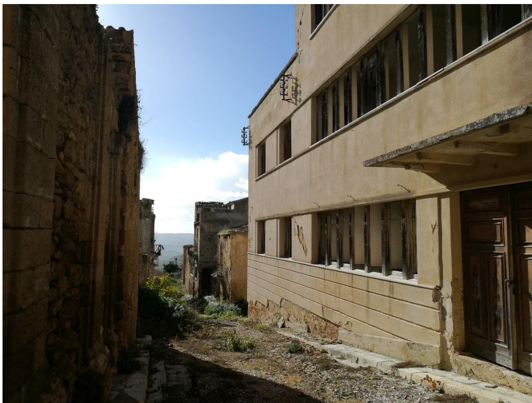
Figura 2.16 – Ruedi di Poggioreale. La biblioteca comunale è caratterizzata da una struttura di cemento armato che ne ha garantito la resistenza al sisma. Fonte: Foto dell'autrice, 2017.
