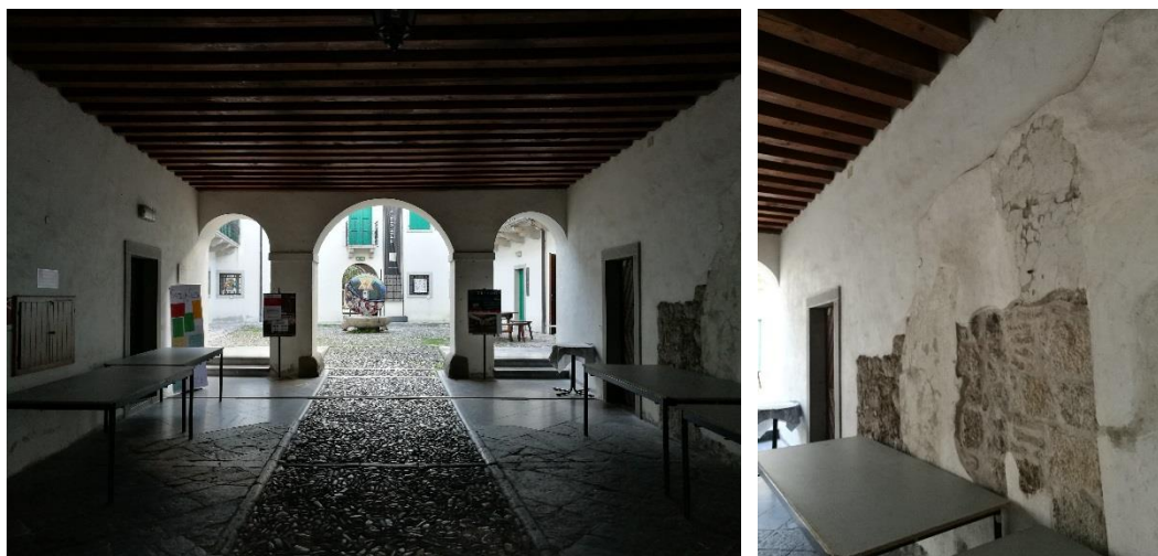
Figura 2.176 – Palazzo Orgnani-Martina. Ingresso. Oggi. Le tracce del trauma sono evidenziate attraverso l'utilizzo di nuovi materiali e di reintegrazioni tese a ripristinare l'assetto generale dell'edificio. Fonte: Foto dell'autrice, 2017.
