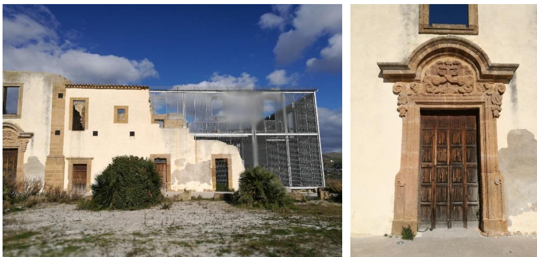
Figura 2.122 – Ruderì di Salaparuta. Ex Convento dei Cappuccini. Il grigliato riconfigura i volumi senza schermare e consente di aprire scorci sul paesaggio inediti. Inoltre, la facciata del complesso conserva intatto il portale principale della chiesa inserita nel complesso, la cui cornice superiore racchiude il simbolo dei Francescani. Fonte: Foto dell'autrice, 2017.
