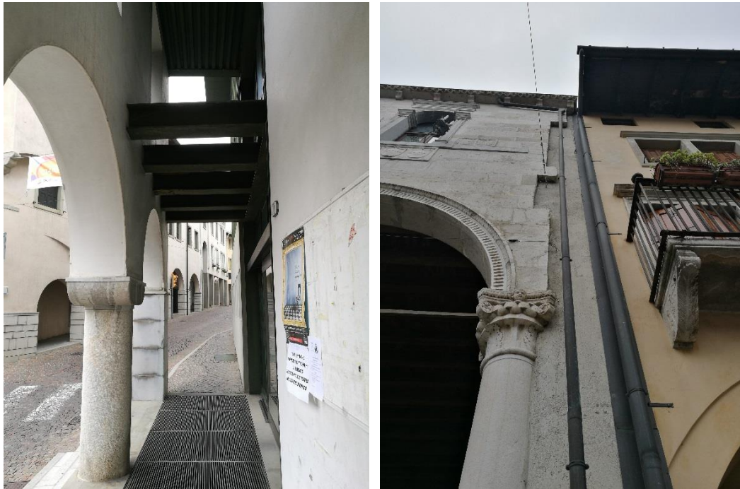
Figura 2.233 – Gemona del Friuli. Palazzo Boton, Ingresso. Oggi. L'incontro antico-nuovo si manifesta nei dettagli di moderne soluzioni tecniche e nel trattamento della facciata "ricollocata" su una nuova struttura. Fonte: Foto dell'autrice, 2017.
