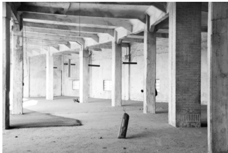
Fig. 5: Mercado de Legazpi nel 2015. Particolare della struttura al primo piano dell'edificio.
