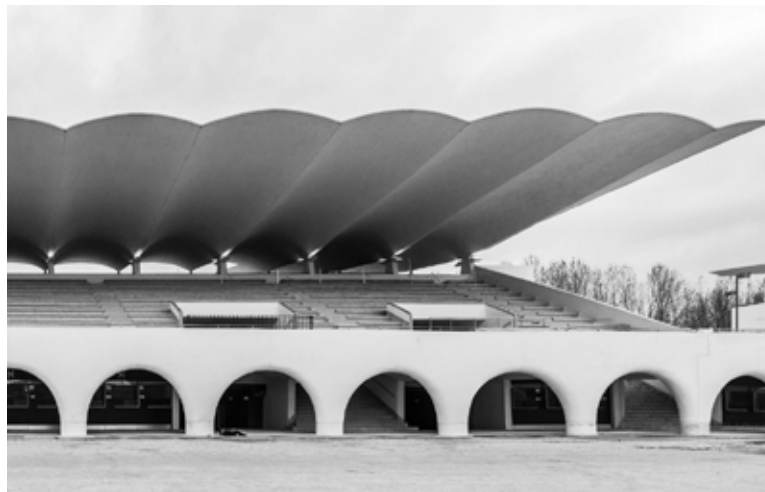
Fig. 2: Hipódromo de la Zarzuela. Madrid. Progetto di Eduardo Torroja, Carlos Amiches Moltó e Martín Domínguez. Con la sua famosa tettoia, è un'opera straordinaria, una delle più importanti del XX secolo, per la sua architettura innovativa e la sua bellezza.
