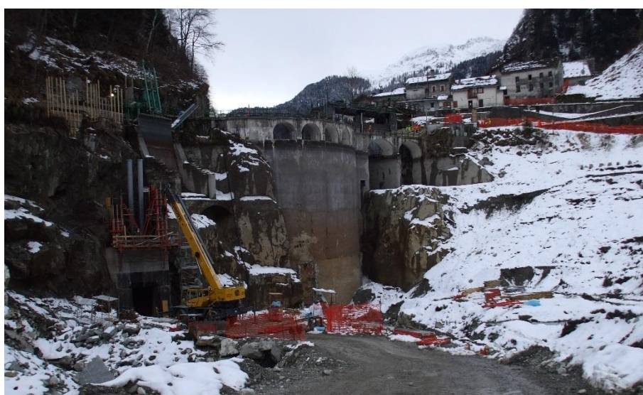
Figura 46: vista del paramento di monte della diga di Rimasco durante i lavori di adeguamento. Sul corpo diga si vedono alcune delle luci sfioranti considerate, a destra il secondo scarico presidiato da paratoie piane.
