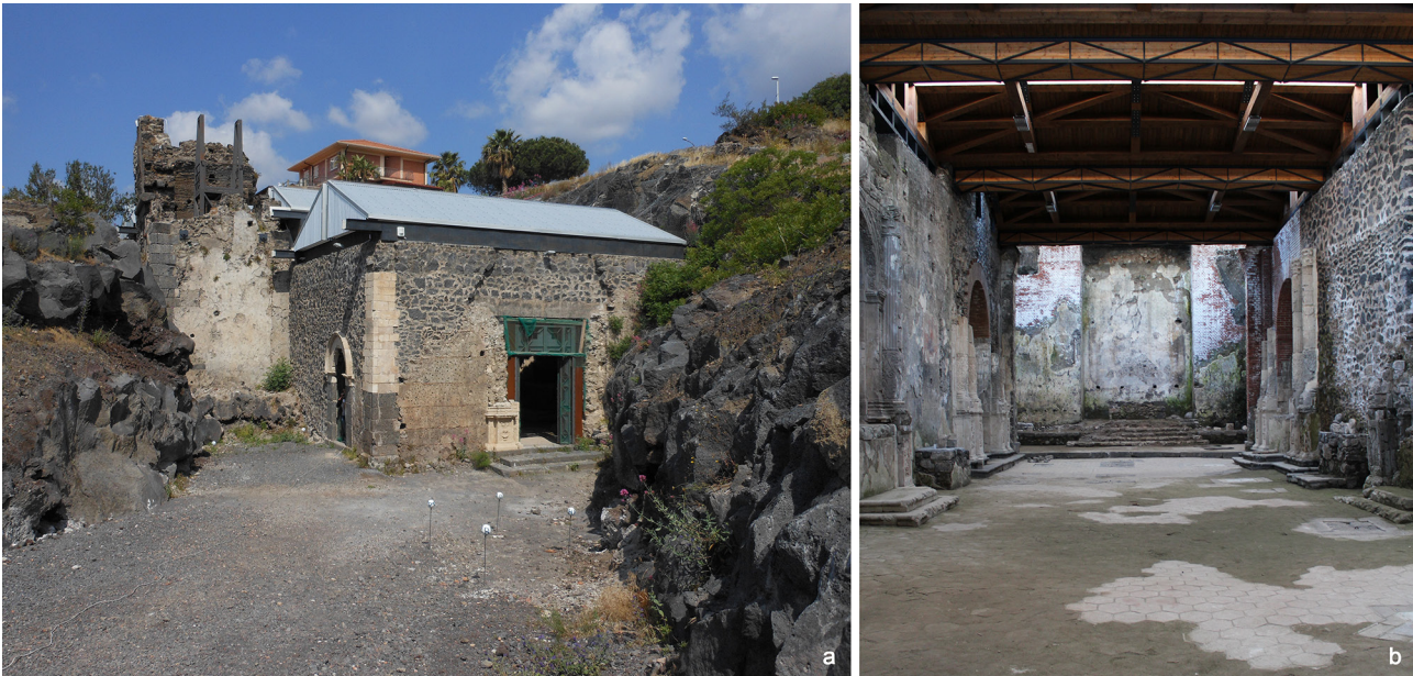
Fig. 4. Viste della chiesa: a) facciata principale, b) interno della navata (foto di R.G. e C.S.)
