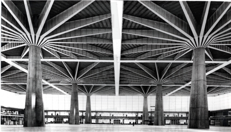
Fig. 2: The interior of Palazzo del Lavoro, Torino [9].
