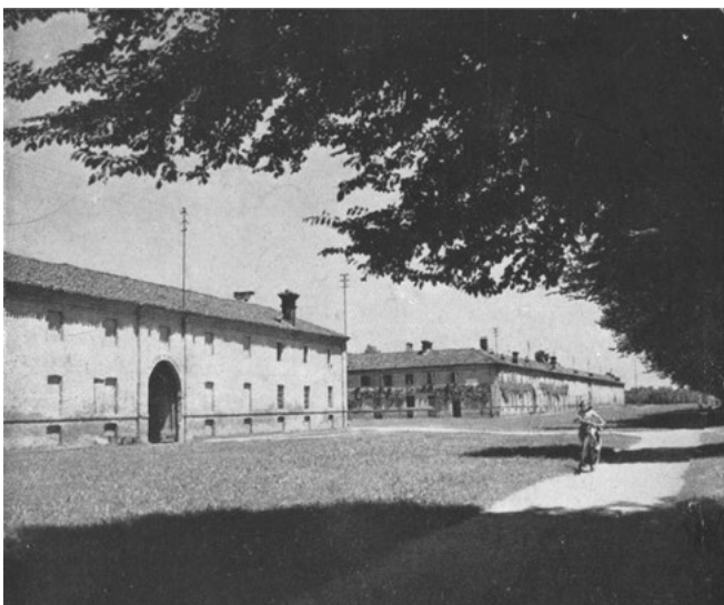
Figura 8. «Metron», le cascine di Stupinigi, ai lati della locanda.
