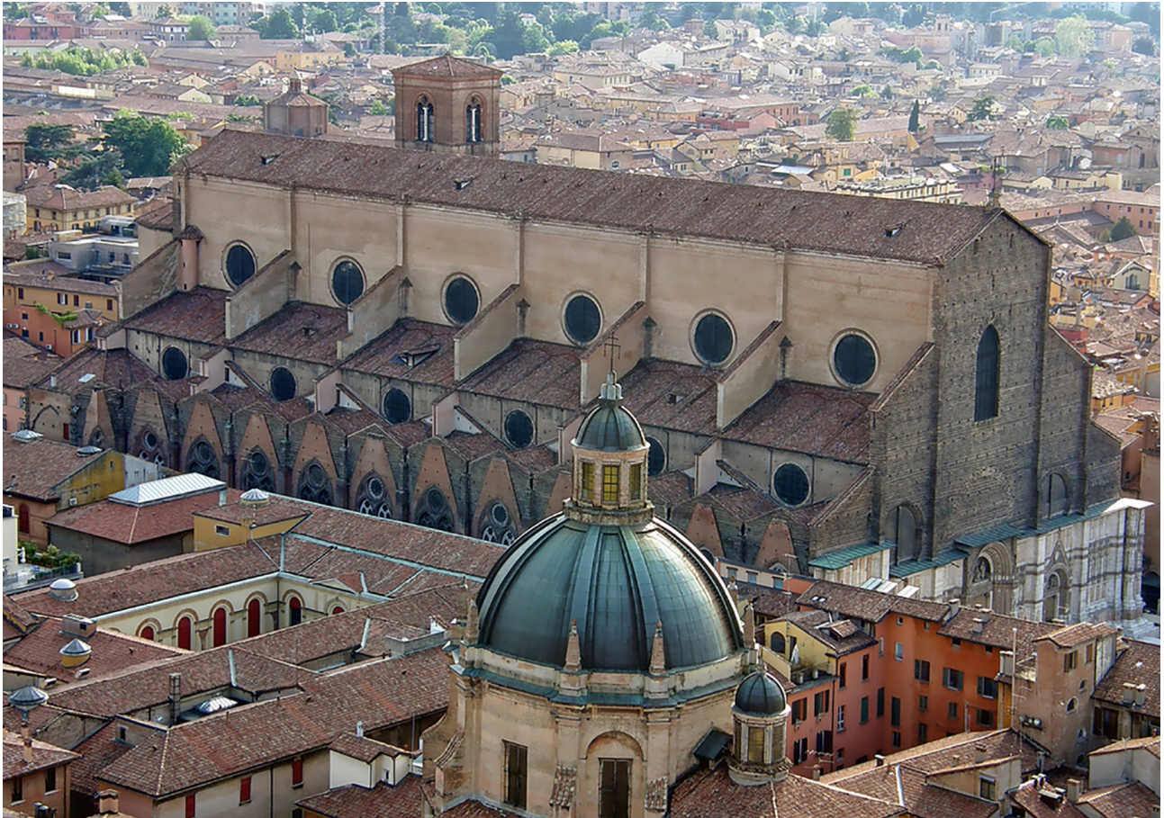
1.23 San Petronio, Bologna, veduta aerea. (foto archivio autore)
