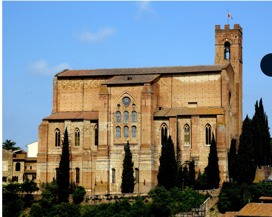
1.5 San Domenico, Siena, lato absidale. (foto archivio autore)
