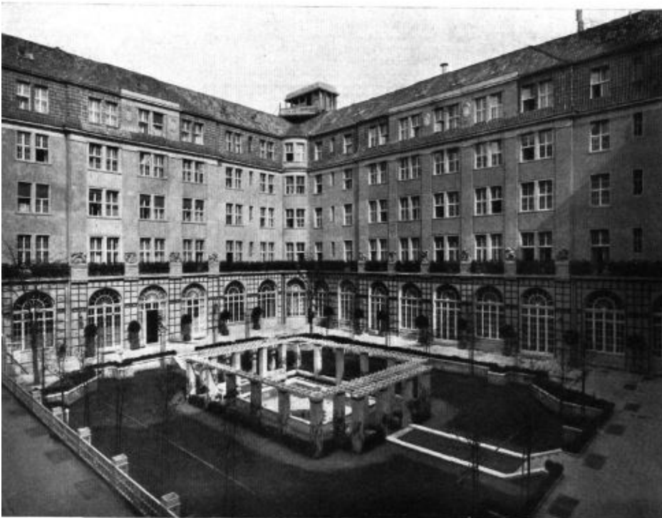
Fig.10. Robert Leibnitz, una delle corti interne del Boarding Palast sul Kurfürstendamm, 1913 [da Berliner Architekturwelt Jg. 15, H.10, 1913]
