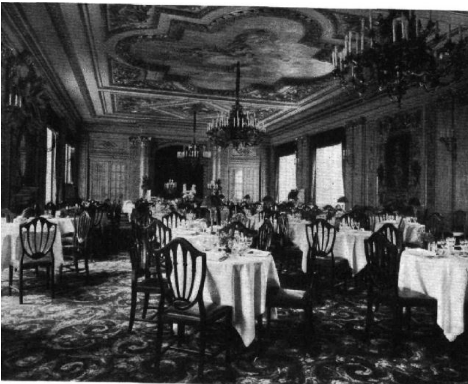
Fig.12. Sala da pranzo maggiore del Boarding Palast sul Kurfürstendamm, 1913 [da Berliner Architekturwelt Jg. 15, H.10, 1913]
