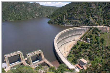
General view of Mulargia reservoir in Sardinia. Source: Ente acque della Sardegna (ENAS)
