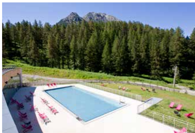
La vasca esterna e l'area prendisole in rapporto alla pineta del Melezet (fotografia di T. Durant, 2015).
