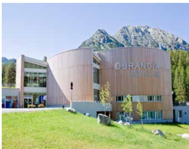
I prospetti in corrispondenza della zona di ingresso (fotografia di T. Durant, 2015).
