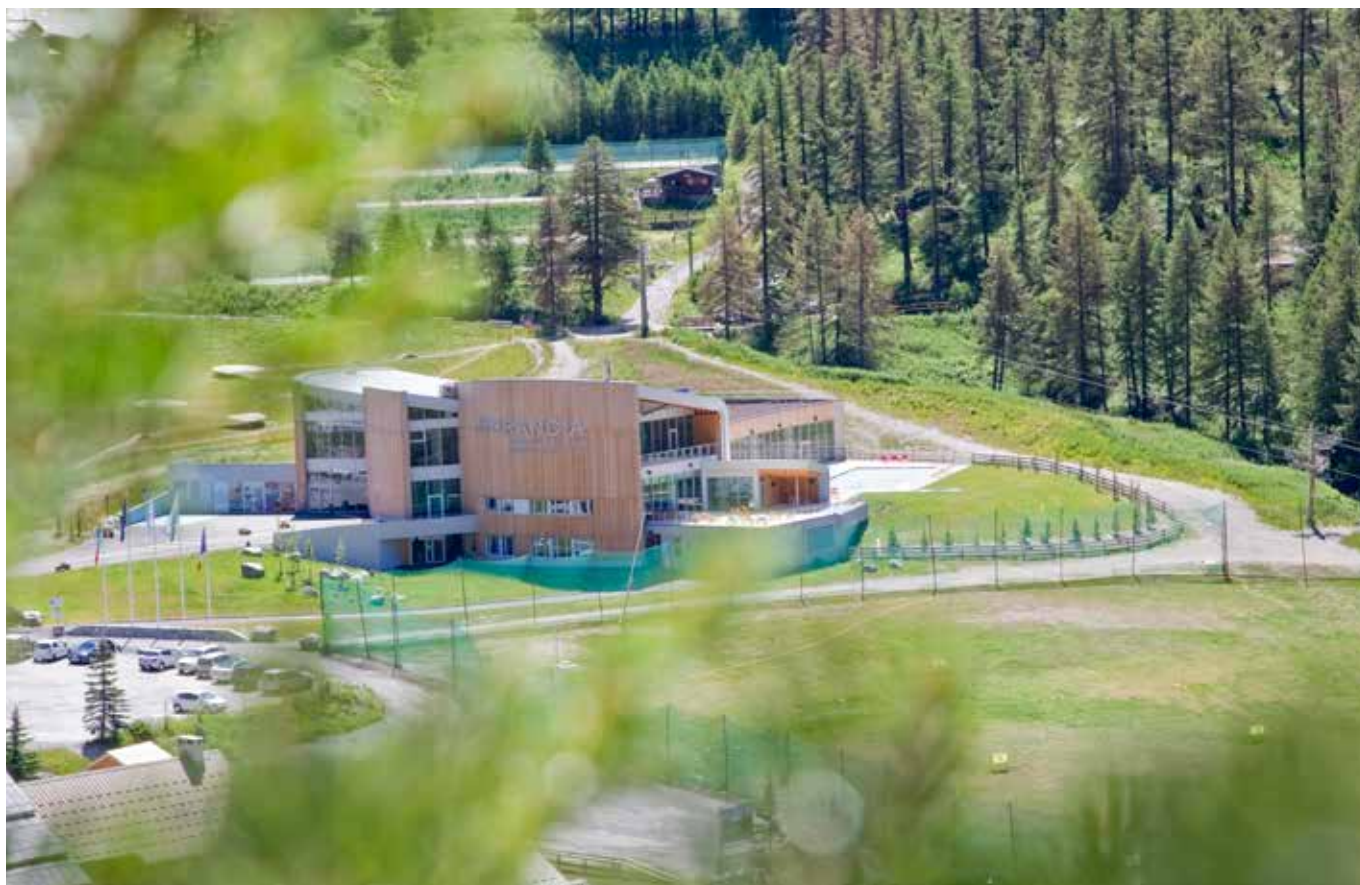
Vista d'insieme dei volumi attraverso i quali è articolato il nuovo centro balneoludico (fotografia di T. Durant, 2015).
