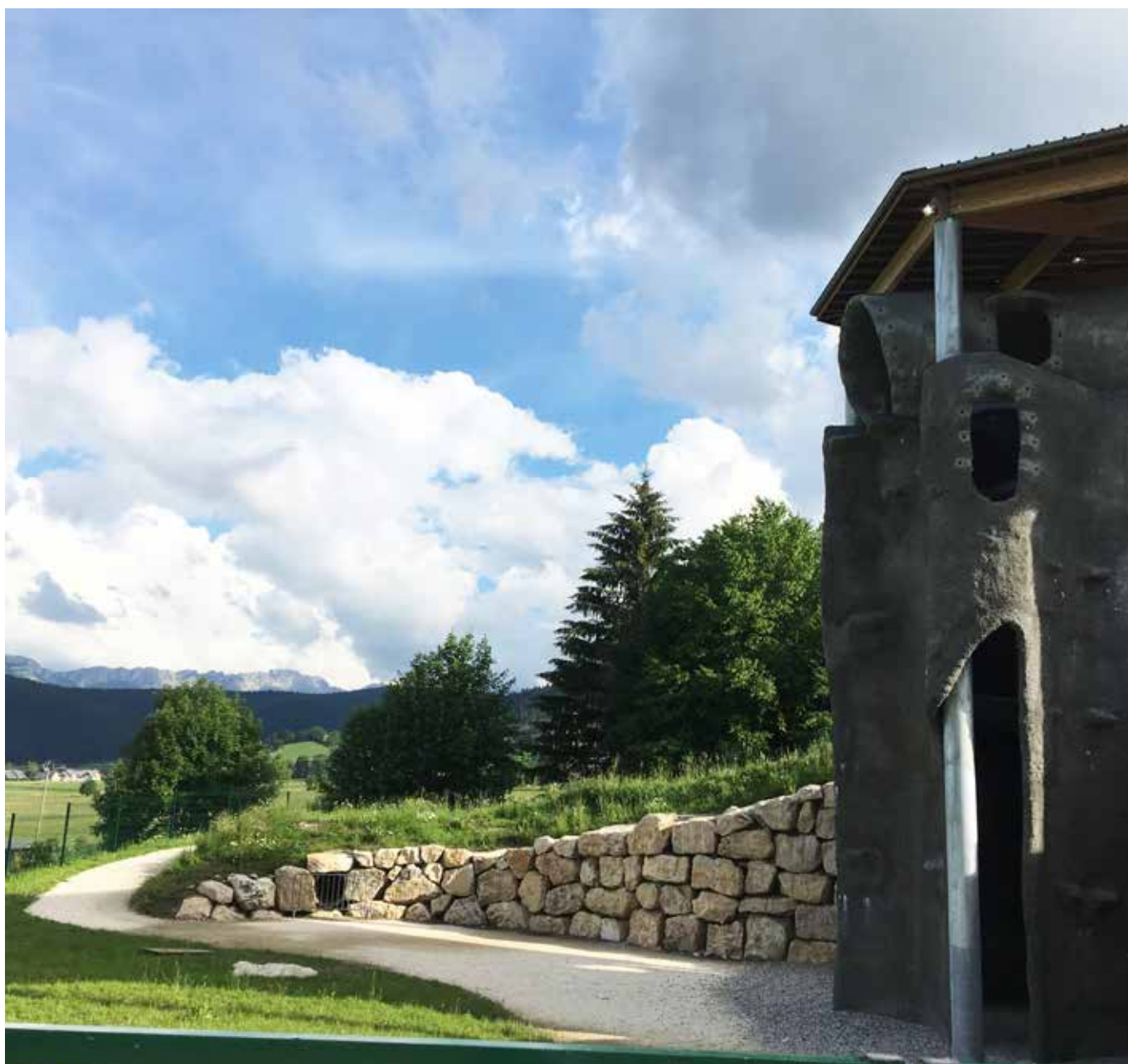
Vista dal fronte ovest.
