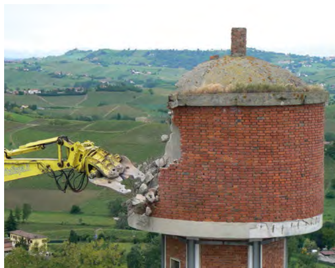
Moasca, demolizione della torre piezometrica che costituiva un elemento di detrazione nello skyline (foto di Marco Tiso).
