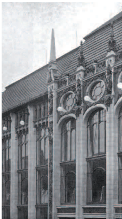
Fig. 1. Warenhaus Wertheim di Leipziger Straße 132/133 (1897- 1898).
