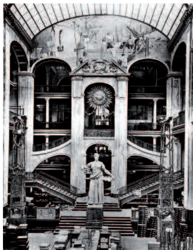
Fig. 5. Interno della corte a illuminazione zenitale ( Lichthof ).
