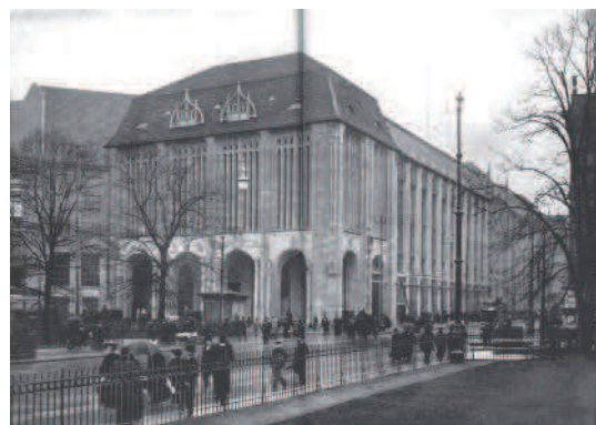
Fig. 13. Warenhaus Wertheim Leipziger Platz (1904/1906), testata sulla piazza.
