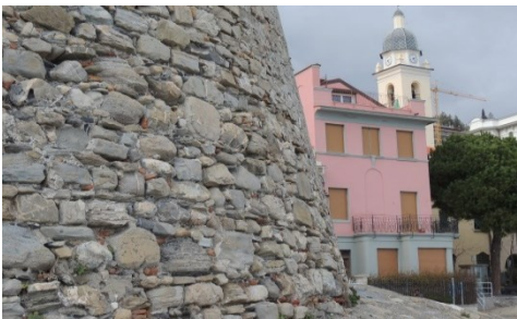
Fig. 8- Torre di Alassio: corsi suborizzontali (Fratini, 2018)
