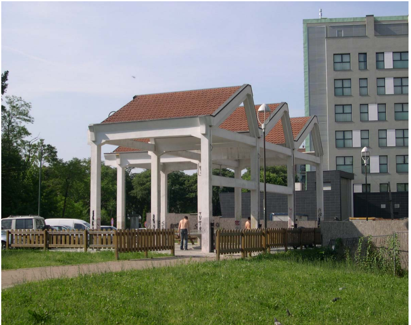
1: Ditta Venchi - U.N.I.C.A., Torino. I pochi lacerti dello stabilimento produttivo conservati nell'intervento che ha previsto il recupero di una piccola porzione dell'intero complesso (Foto di Manuela Mattone, 2010).
