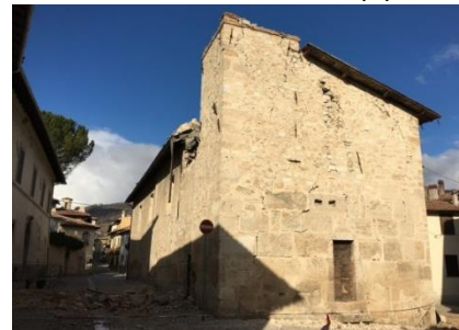
N. 21 Collapsed church (1)
