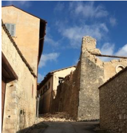
N. 22 Collapsed church (2)
