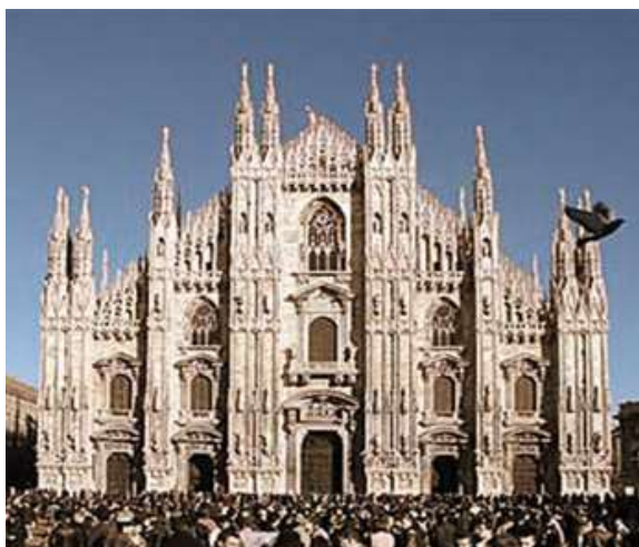
Fig. 16. Duomo di Milano, facciata principale.
