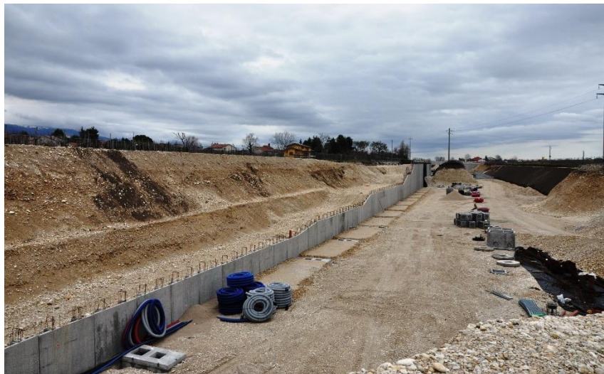
Figura 47 - Cantiere della Pedemontana nei pressi di Paulona, a Sud-Ovest di Vicenza (foto di Paolo Meneghini).
