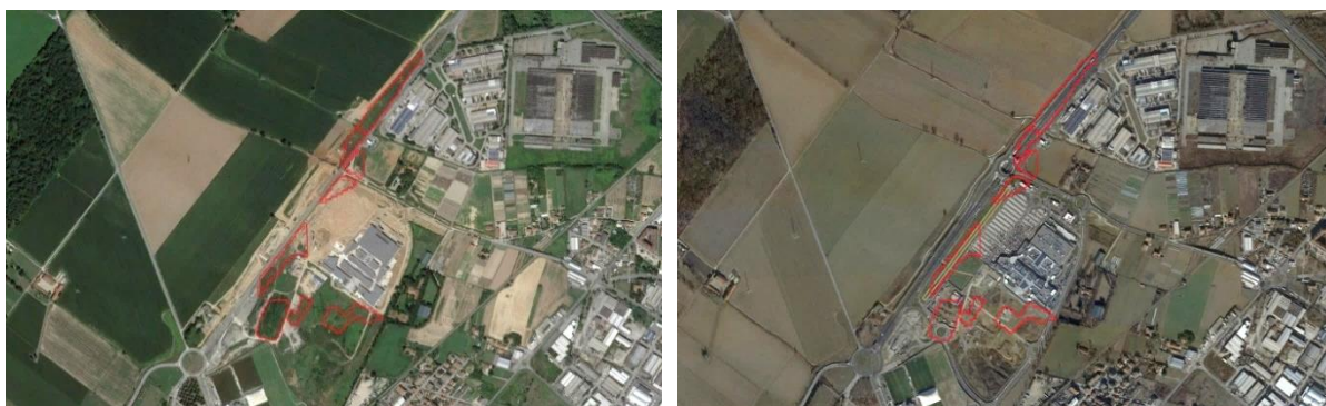
Figura 33 - Cantiere nell'area commerciale a cavallo dei territori di Nichelino e Vinovo e il raddoppio e completamento della nuova strada Debouché, intervento infrastrutturale di 37.000 m 2 che collega i due centri abitati in provincia di Torino, ha condotto alla recente occupazione di suolo pari a 4 ettari.
