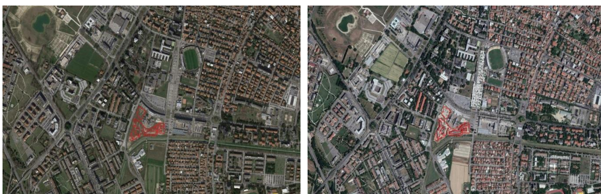
Figura 68 - Sede dei nuovi uffici del Comune e dell'ARPAE, con i complementari servizi, nel comune di Ravenna, la quale, nel 2017, ha visto un incremento del consumo di suolo di 16 ettari di cui 1,6 sono stati occupati dai nuovi uffici.
