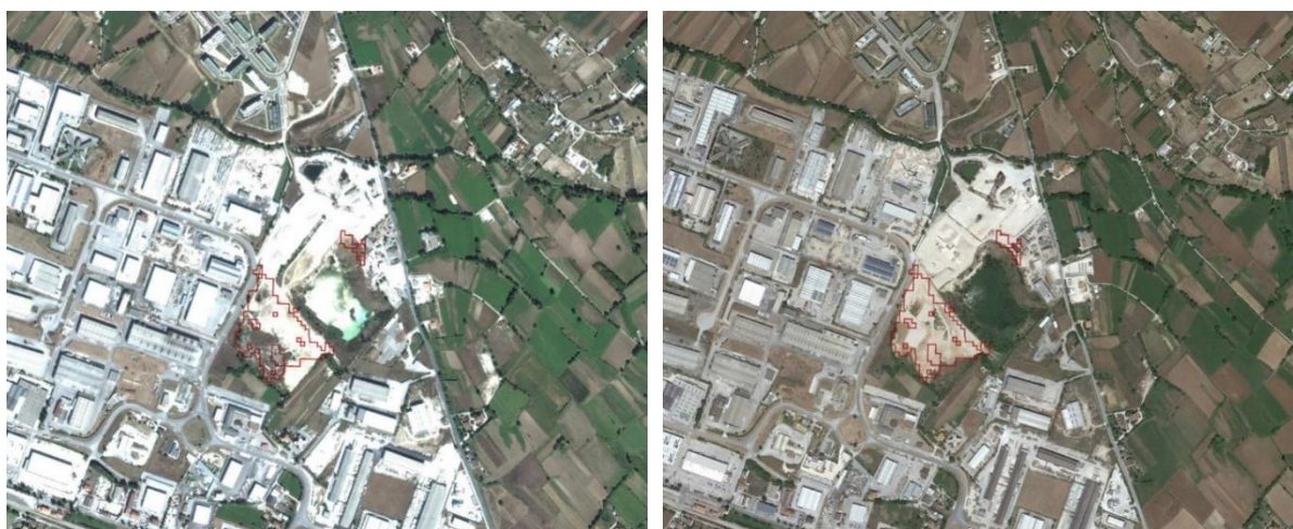
Figura 86 – Anche per l'ampliamento di un deposito di materiali edili da 25.000 m 2 , nei 474 km 2 de L'Aquila il consumo di suolo tra il 2016 e il 2017 è incrementato di 6,5 ettari. Nella Regione Abruzzo, nella quale sono stati documentati cambiamenti per 117 ettari, L'Aquila è il primo Comune.
