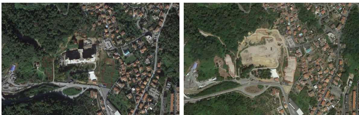
Figura 64 - Demolizione dell'ex ospedale Felettino di La Spezia. Nel capoluogo ligure, nell'ultimo anno è stato stimato un consumo di suolo di appena 1,4 ettari, con interventi prevalentemente localizzati nel centro abitato.
