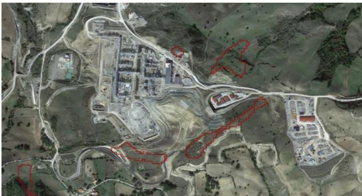
Figura 99 - Tempa Rossa, il giacimento petrolifero nell'alta valle del Sauro, ampliato di 48.000 m 2 tra il 2016 e il 2017, rappresenta la quasi totalità della trasformazione locale del territorio del Comune di Corleto Perticara (89 km 2 ), estendendosi su una superficie pari a 58.000 m 2 .
