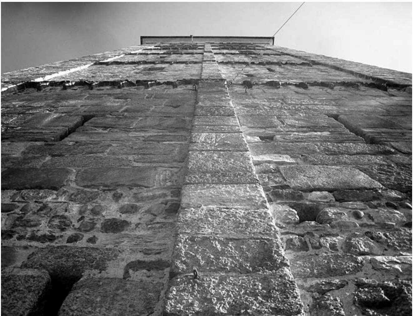
Fig. 7. Torre campanaria, lato nord. Una strada verso il cielo.
