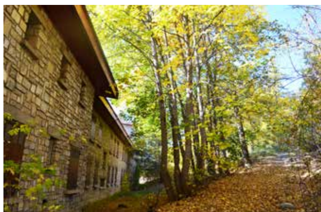
Una delle palazzine per il personale, costruita sul bordo del rilievo lungo la Route de Grenoble e collegata con il complesso sanatoriale con viali interni (fotografia di Alessandro Mazzotta, 2017).
