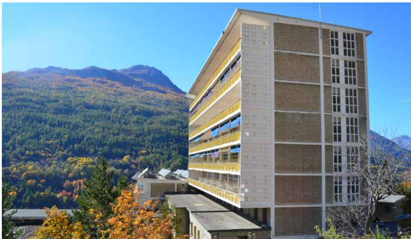
Il volume più alto tra gli edifici per il ricovero: sul fronte sud, i telai degli originari serramenti in alluminio erano realizzati secondo il système Prouvé, con vetrate Thermopane (fotografia di Alessandro Mazzotta, 2017).
