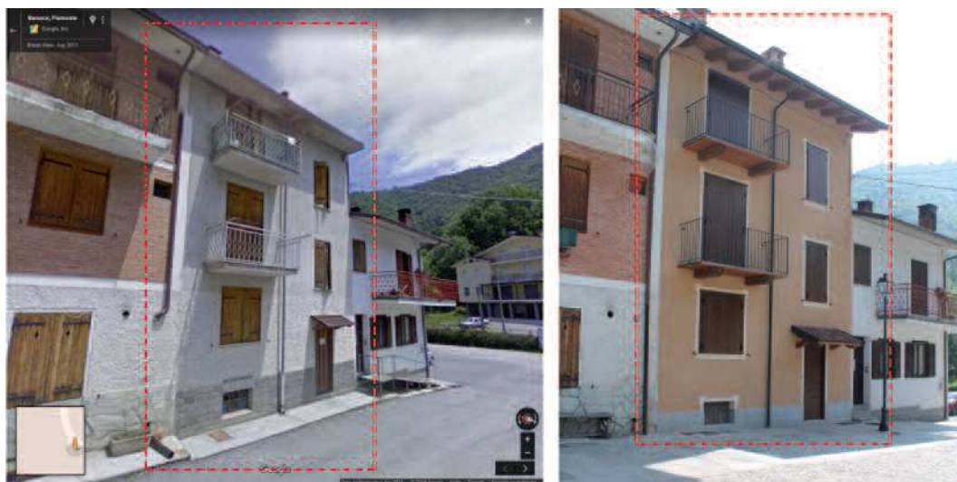
Figura 5 Confronto dell'aspetto dell'edificio pre e post intervento di un edificio recuperato con i contributi della misura 322 nella borgata Baracco - Roccaforte di Mondovì (CN)
