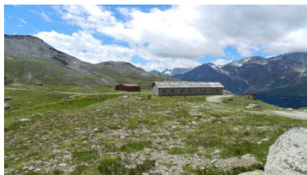
Figura 5. Valtournenche (Val d'Aosta, Italia). Stazione di arrivo della strada ferrata e baracche degli operai in prossimità della diga del Goillet (foto Manuela Mattone).
