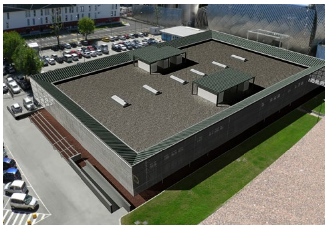
Figura 1. Il blocco delle Aule P visto dall'edificio-ponte. La copertura mostra ancora alcune differenze rispetto alla versione definitiva, nella quale non sono presenti i pannelli solari e sono state eliminate le protezioni delle UTA (fotoinserimento).
