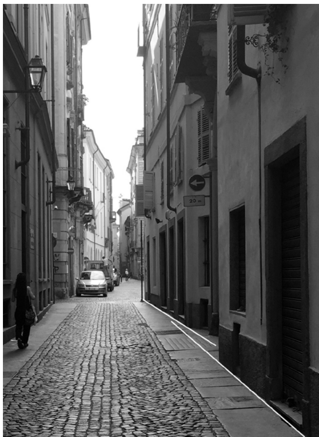
Figura 9. Il disallineamento (evidenziato a terra con una linea bianca) delle due 'ali' di facciata ai lati del corpo centrale.
