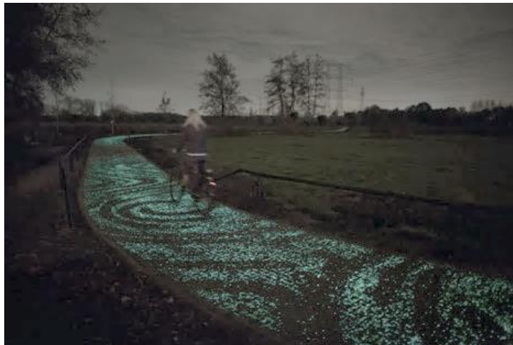
Gogh-Roosegaarde Bicycle Path, pista ciclabile olandese, poi esportata in altre parti del mondo, realizzata in modo che la sua superficie possa catturare la luce del giorno per illuminarsi di sera e di notte
