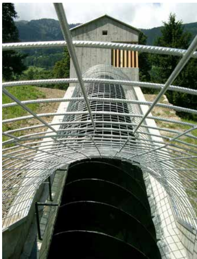
Mini centrale idroelettrica a San Martino in Passiria (Bolzano), Thomas Wiedmer, a-natur; 2007.
