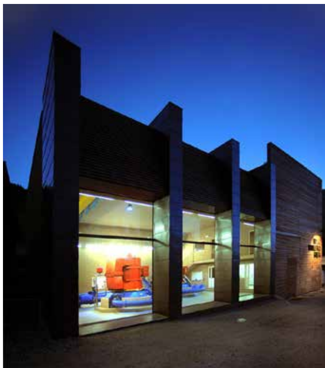
Mini centrale idroelettrica Gadera a San Cassiano (Bolzano), Vudafieri Saverino Partners; 2009.
