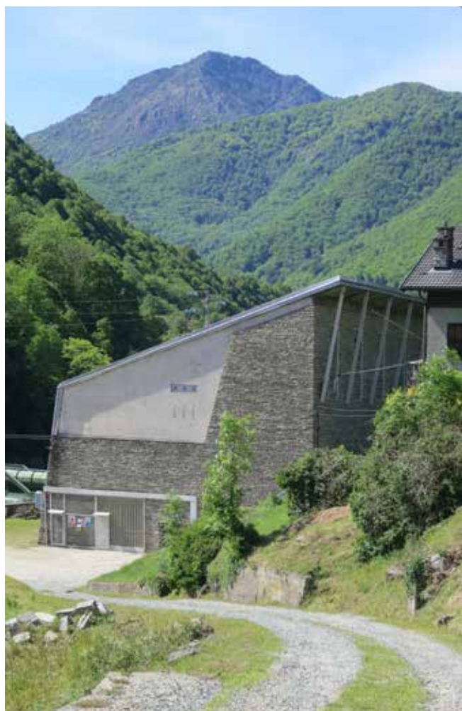
Centrale di Ceres, Torino, 1947-1948.
