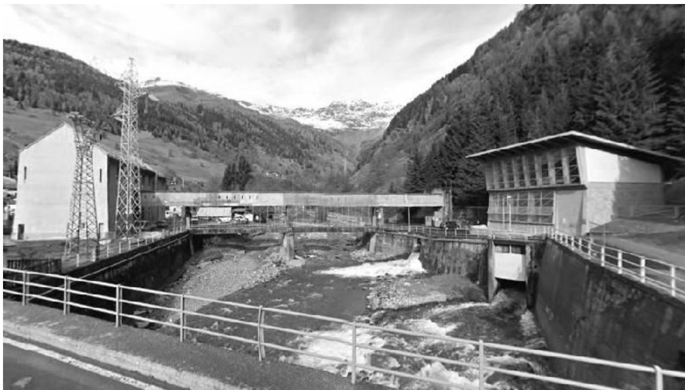
Centrale di Isolato-Madesimo, Sondrio, 1951-1953.
