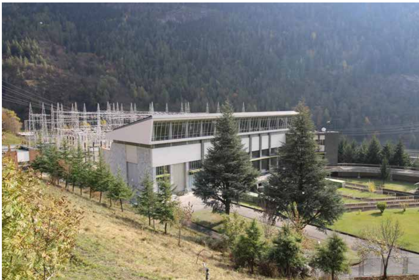
Centrale di Valpelline, Aosta, 1958.
