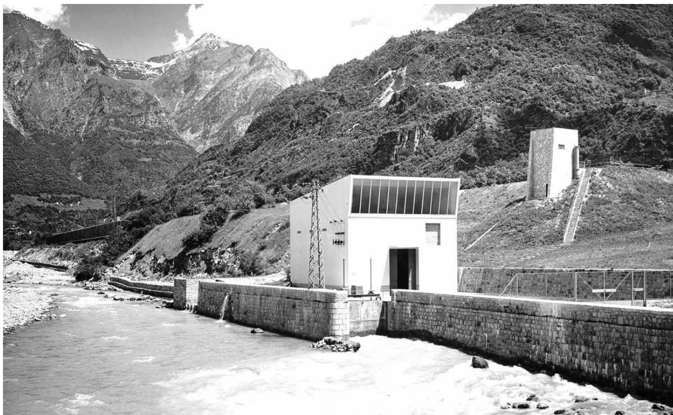
Cabina elettrica di Prata, Sondrio, 1950.
