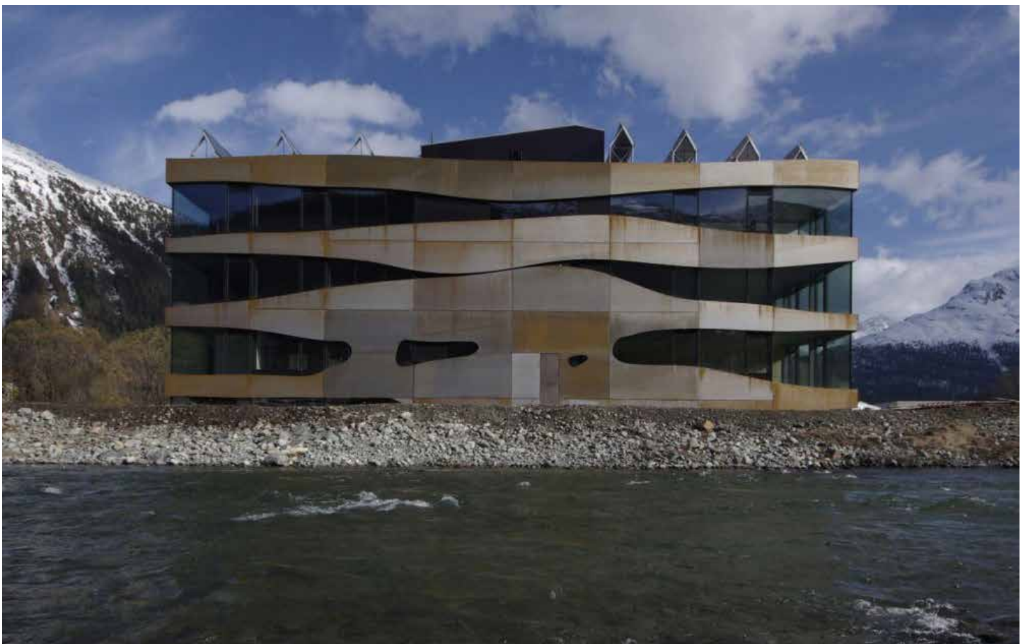
Edificio commerciale Islas a Samedan, Svizzera, Mierta&Kurt Lazzarini, 2012.
