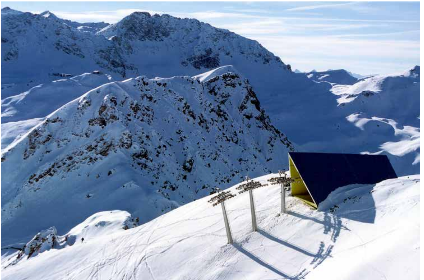
Impianti di risalita a Carmenna, Svizzera, Bearth & Deplazes, 2000 (foto di Ralph Feiner).
