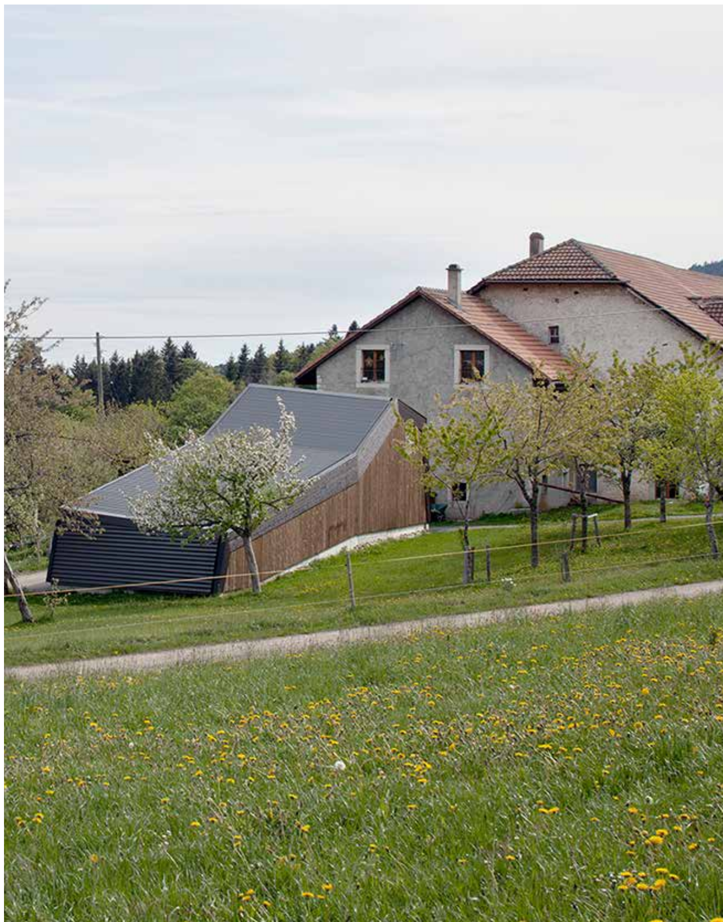
Local Architecture, deposito a Lignières (Svizzera), 2013.
