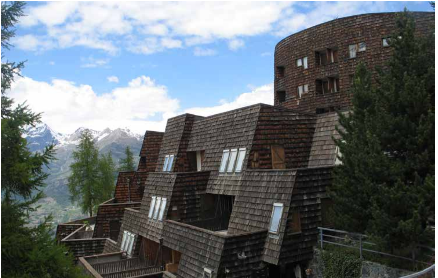
Pila (Gressan), complesso residenziale Plein Soleil (F. Cometto, R. Coquillard, G.B. Debernardi, G. Nebbia, 1976).
