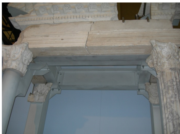
Figura 19. Particolare dell'edicola del tempio (foto: E. Romeo).
