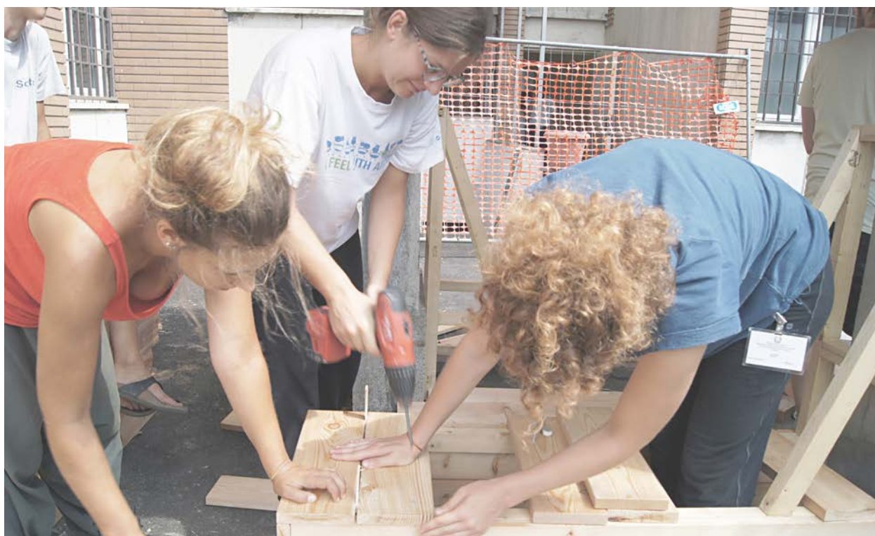
66. Nell'area 2 è ora di posare i rivestimenti in legno.
