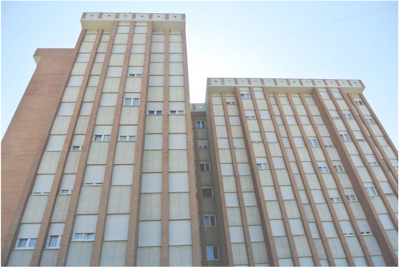
Una caserma all'interno della C.C. Le Vallette, completamente ristrutturata tra il 2013 e il 2014
