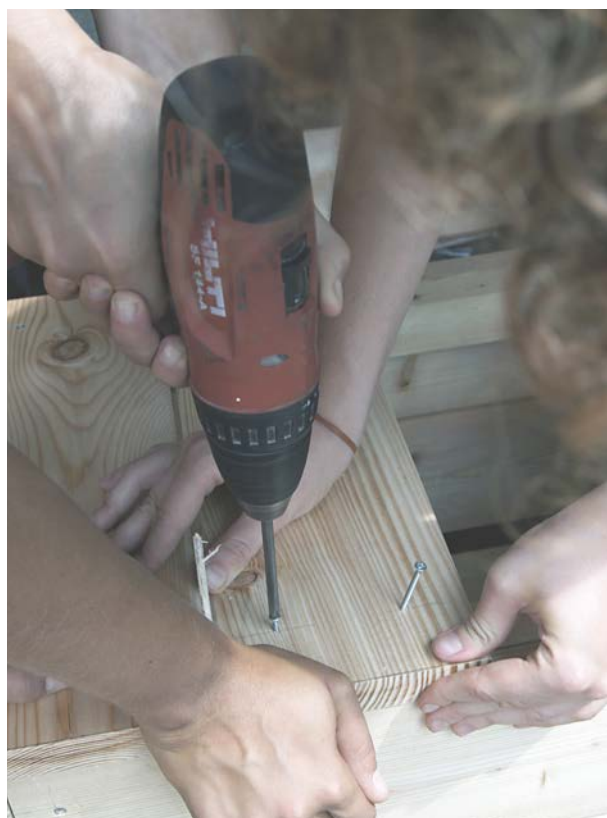
70. Sembra facile mettere una vite, ma è difficile farlo senza che il legno si crepi, procediamo con cautela forando il legno prima di avvitare.
