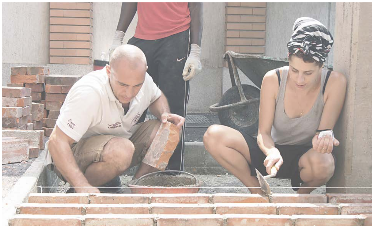
29. Con i mattoni recuperati si lavora alla nuova pavimentazione dell'area fumatori davanti al bar.
