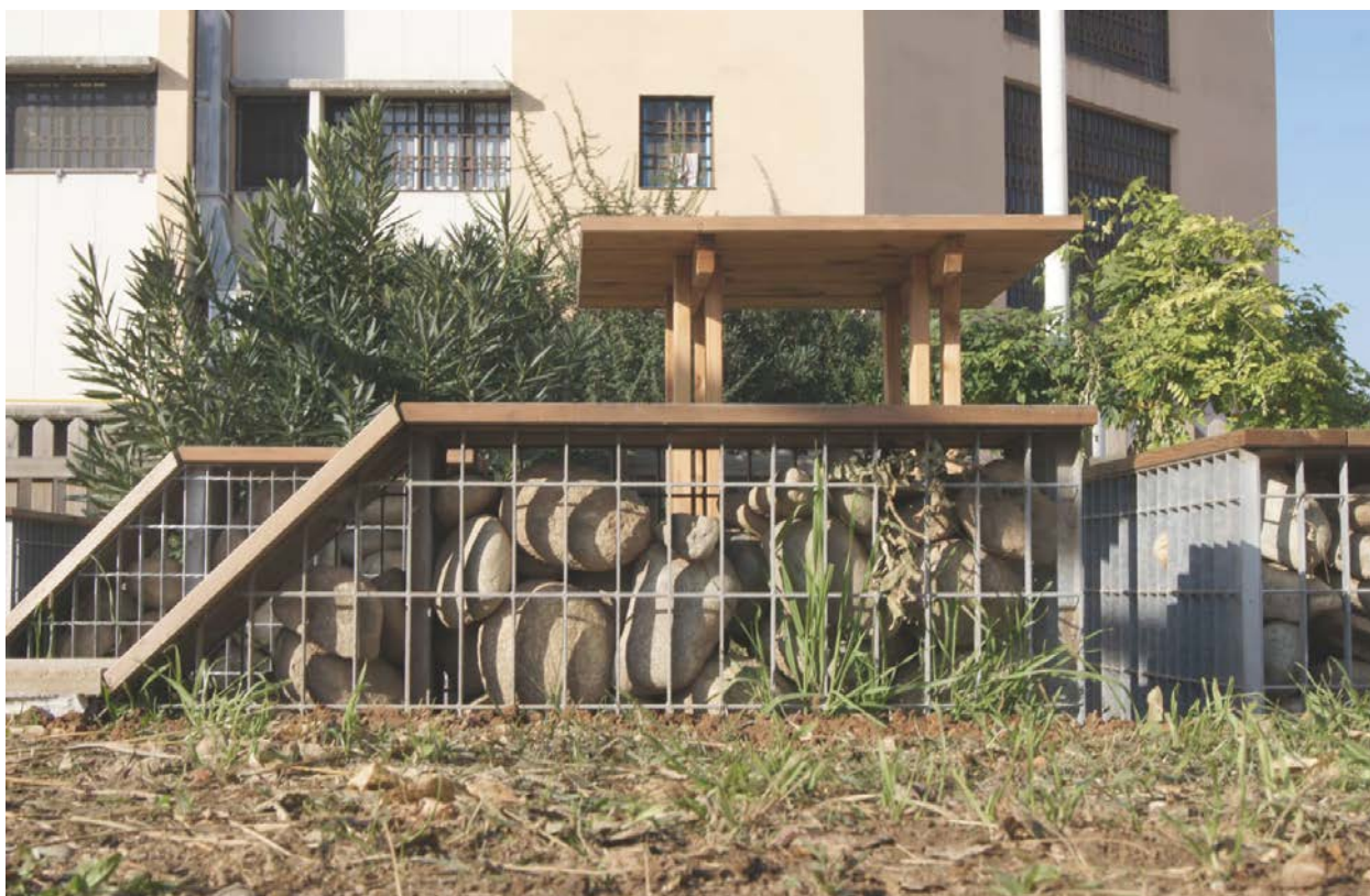
Area1. Dettaglio della seduta con struttura in orso grill e pietra e rivestimento in legno di larice
