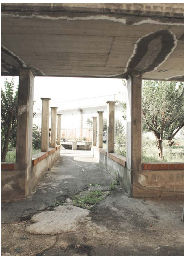
L'ingresso all'area dall'edificio della caserma e dello spaccio.
