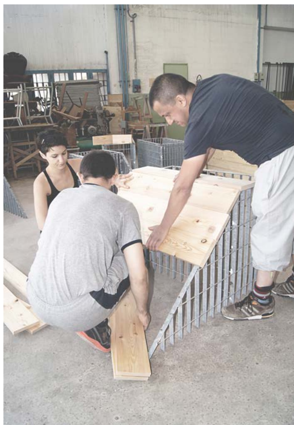
42. La prima prova di posa del rivestimento in legno sui telai in orsoiril. A breve diventeranno le sedute per
