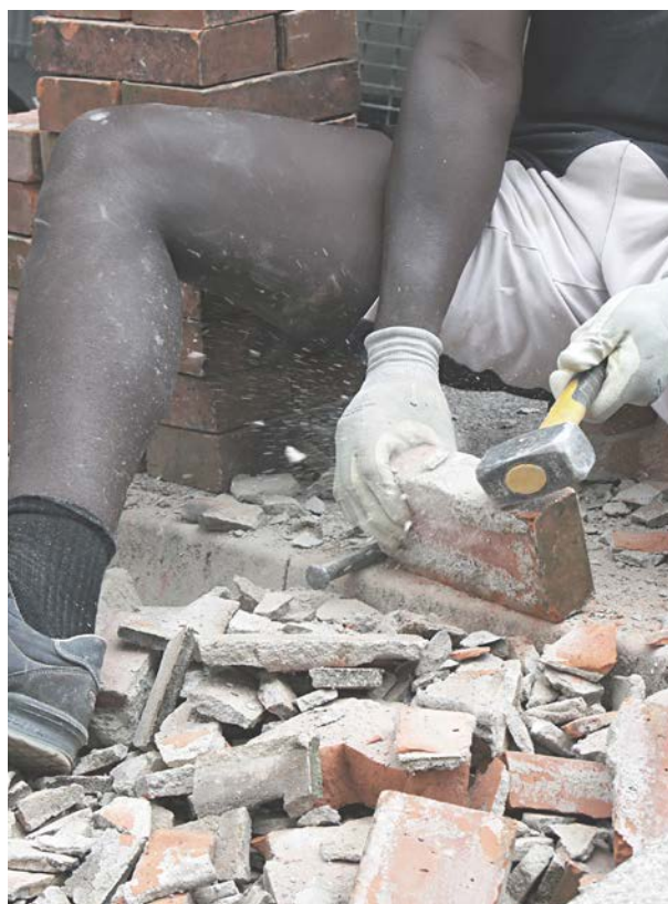
27/28. I mattoni recuperati devono essere puliti, con martello e scalpello si fanno saltare i detriti.
