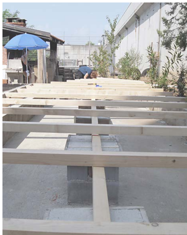
53. La struttura della pedana è pronta.
