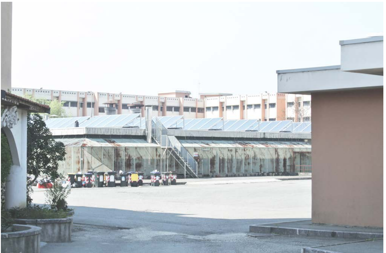
Un'esterno della C.C. Le vallette. L'edificio della centrale termica e sullo sfondo gli edifici delle sezioni detentive, sulla sinistra le fioriere all'ingresso della sezione femminile.
