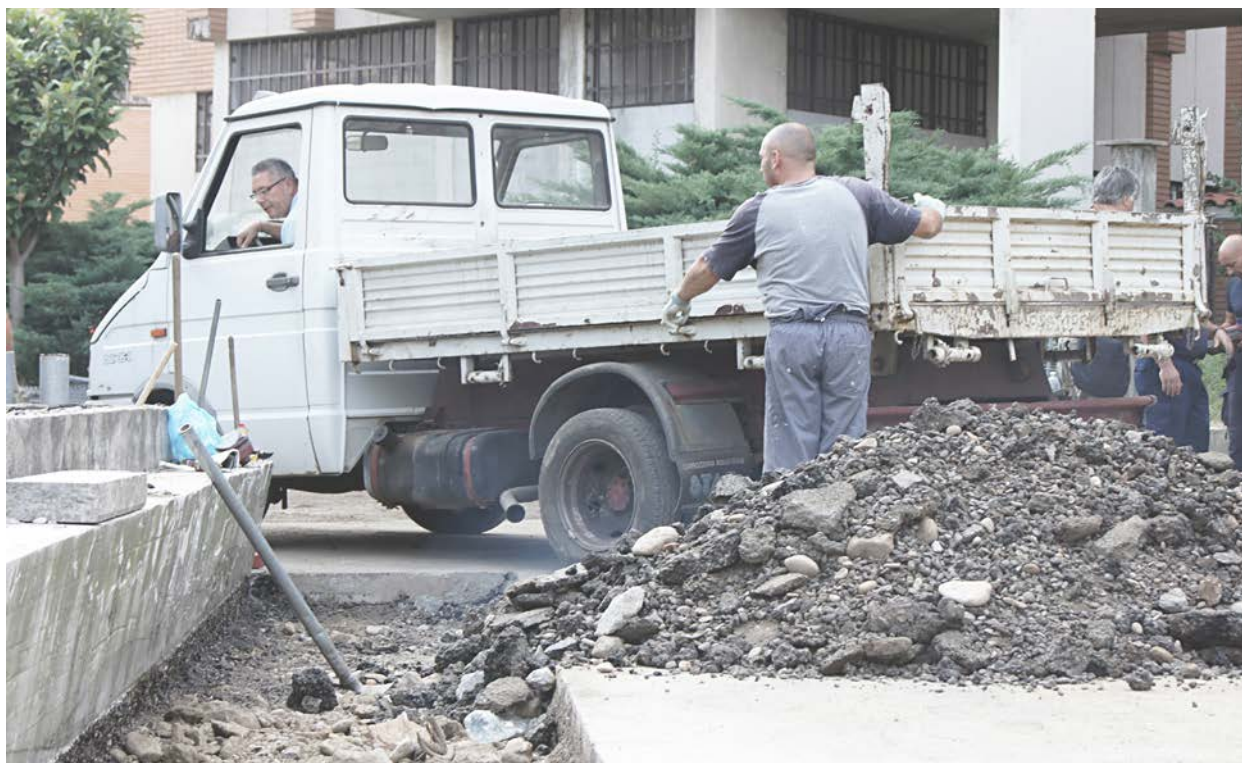
16. I detriti dell'asfalto demolito vengono rimossi.
