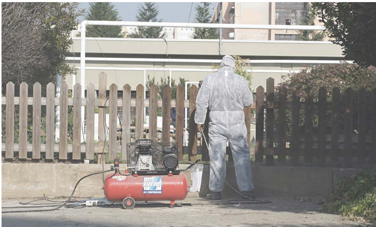
88. Il trattamento del legno della recinzione con impregnante.
