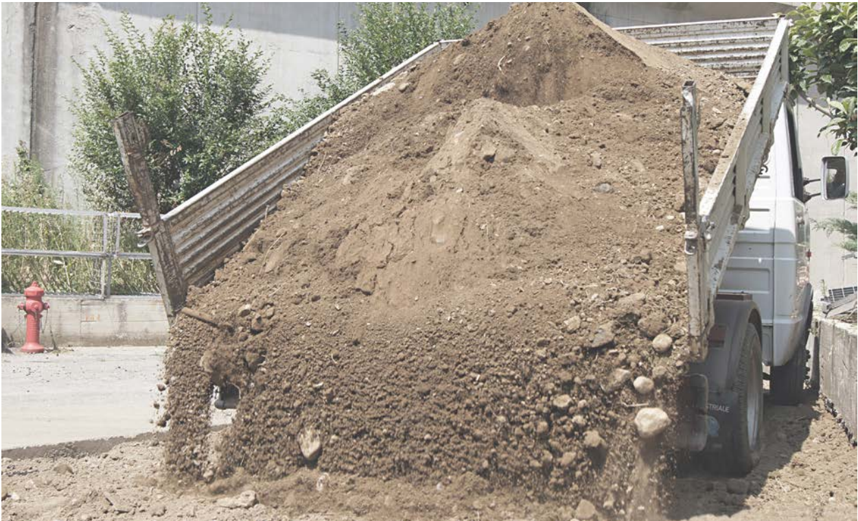
10. La terra pulita in eccesso nell'area 1 viene trasportata nell'area 2 per realizzare il nuovo parterre inerbito nelle zone in cui è stato rimosso l'asfalto.
