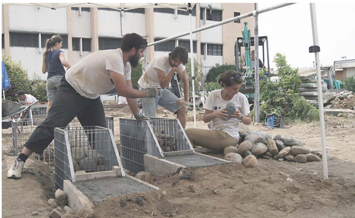
60. I telai vengono riempiti col pietrame recuperato durante gli scavi.
