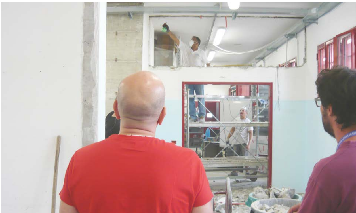
I dipendenti detenuti della cooperativa demoliscono il tramezzo del vecchio ingresso al laboratorio Fischer che deve essere spostato.
