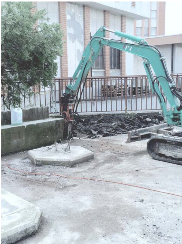
5. Rottura dell'asfalto e demolizione degli arredi in C.A..
