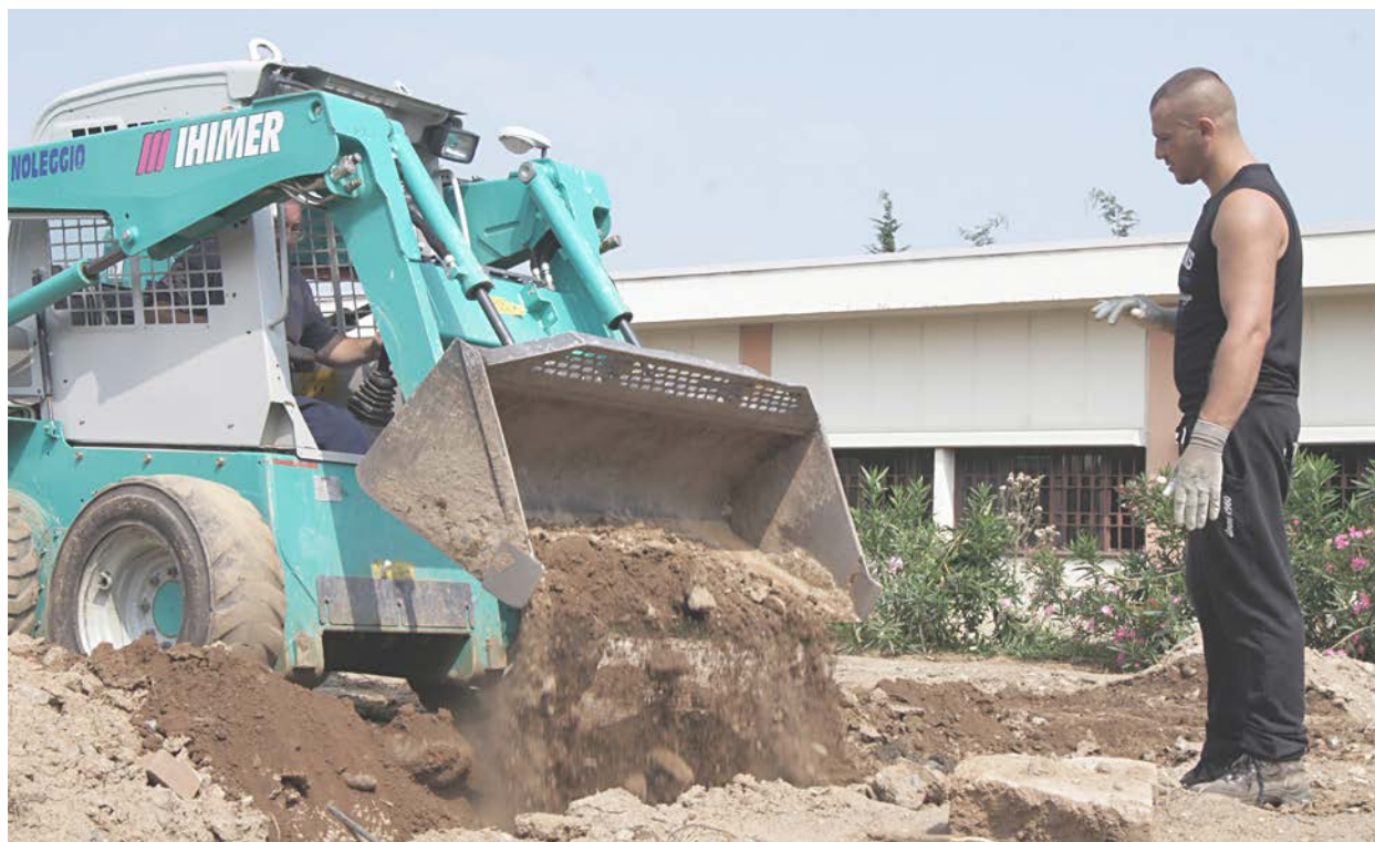
1. I lavori di bonifica del terreno. I macchinari: un mini-escavatore, una mini-pala ed una taglia-asfalto sono stati noleggiati dal gruppo studentesco per circa 1 mese.
