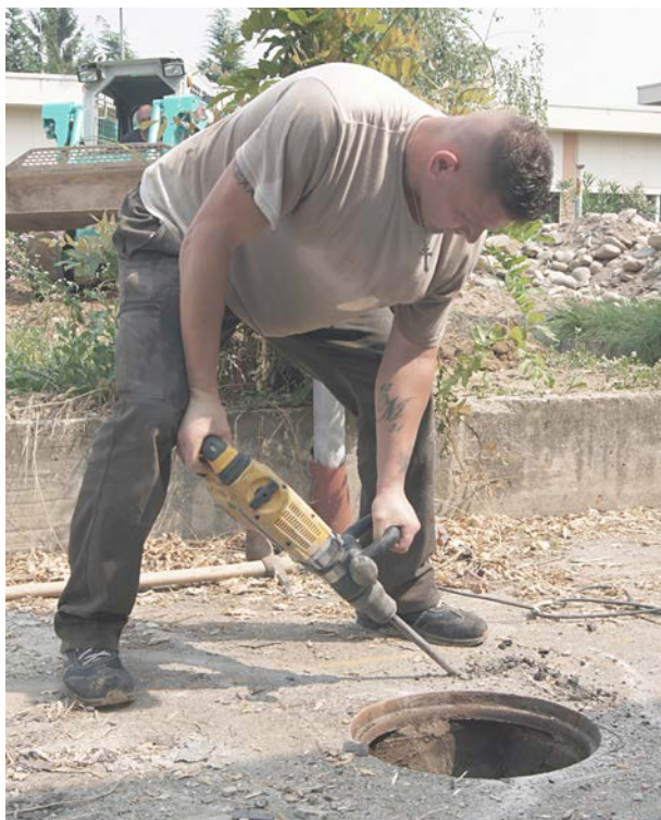
24. Per portare il terreno a livello, un pozzetto di ispezione deve essere sopraelevato.
