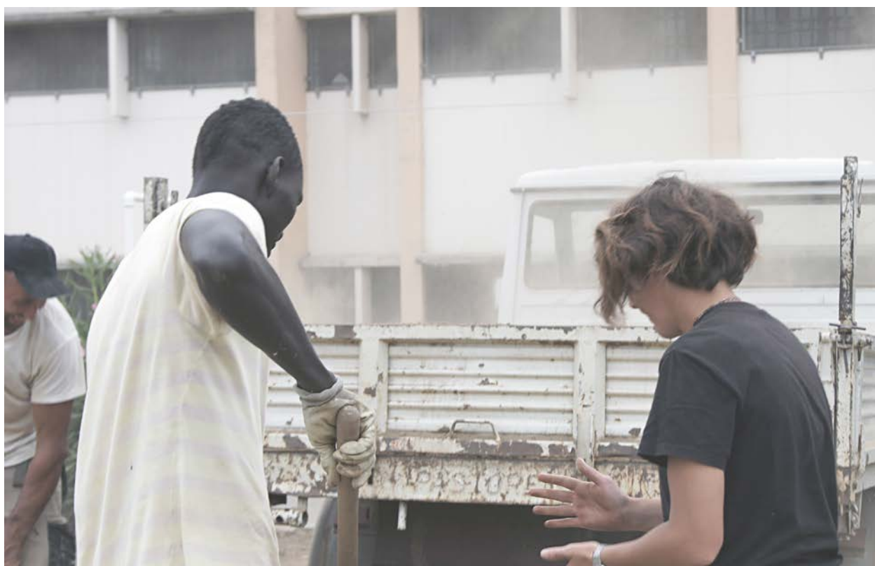
75. Nell'area 1 si procede con le ultime rifiniture e la pulizia del terreno.
