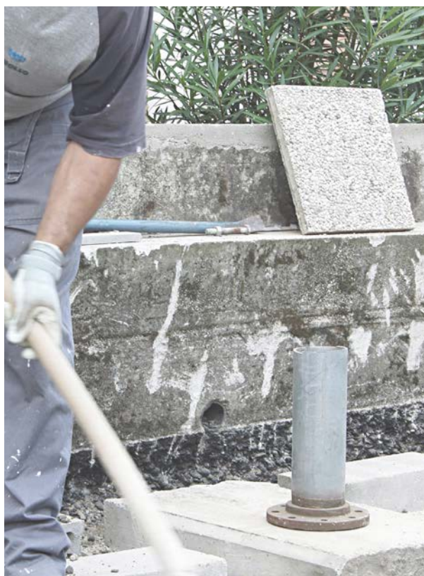
18. Una prova per il piede del tavolo (tubo idraulico + flangia)
