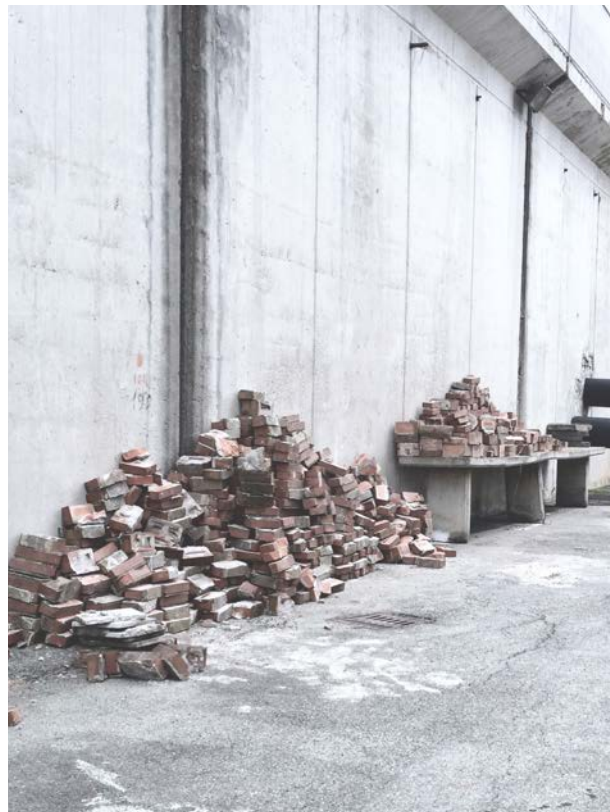
6. I mattoni recuperati dalle demolizioni dei cordoli.
