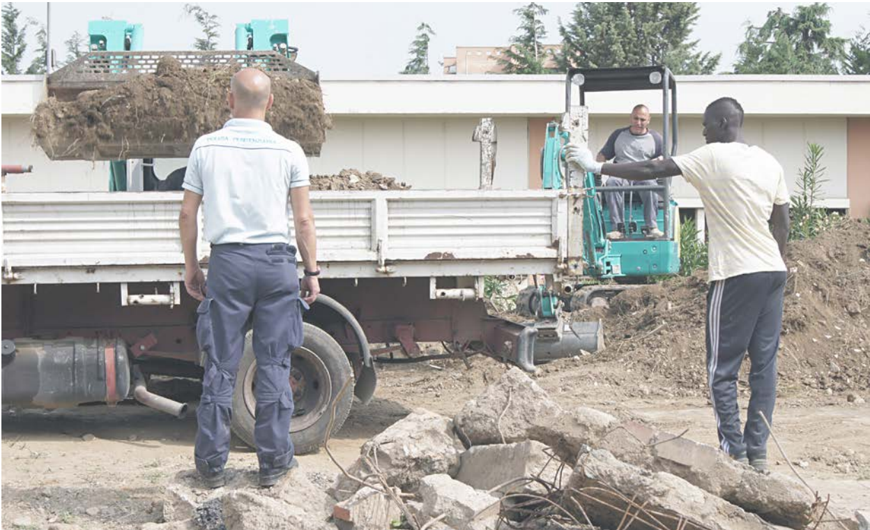
4. Per lo smaltimento dei detriti e la movimentazione del terreno si è utilizzato un furgone con cassone ribaltabile del Corpo di Polizia, solitamente in uso alla MOF.
