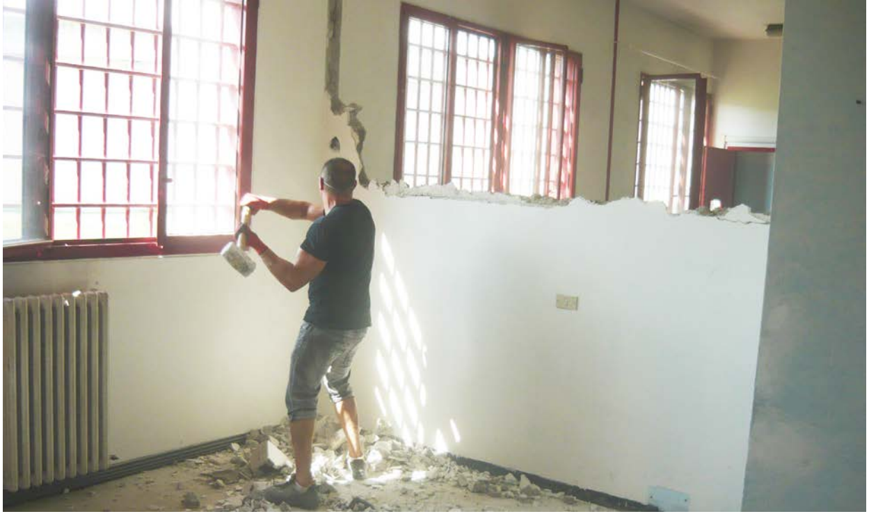
I lavori di demolizione: la cartella che conteneva queste foto è stata inviata a chi scrive dalla cooperativa col titolo “muri cadono”
