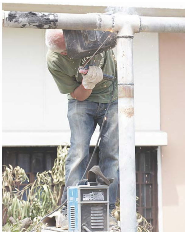
64. La saldatura richiede molto tempo. Le tubature sono composte da una lega di metalli molto difficile da lavorare.
