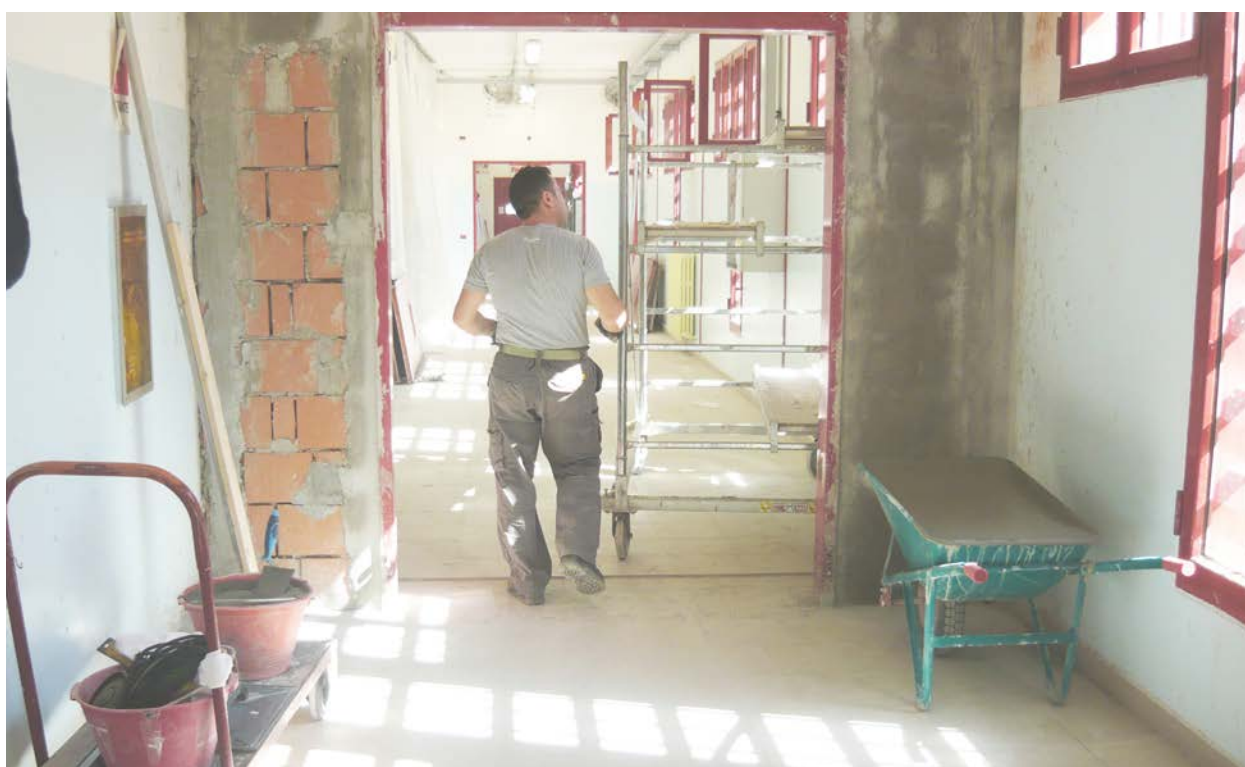
Immagine del cantiere.
