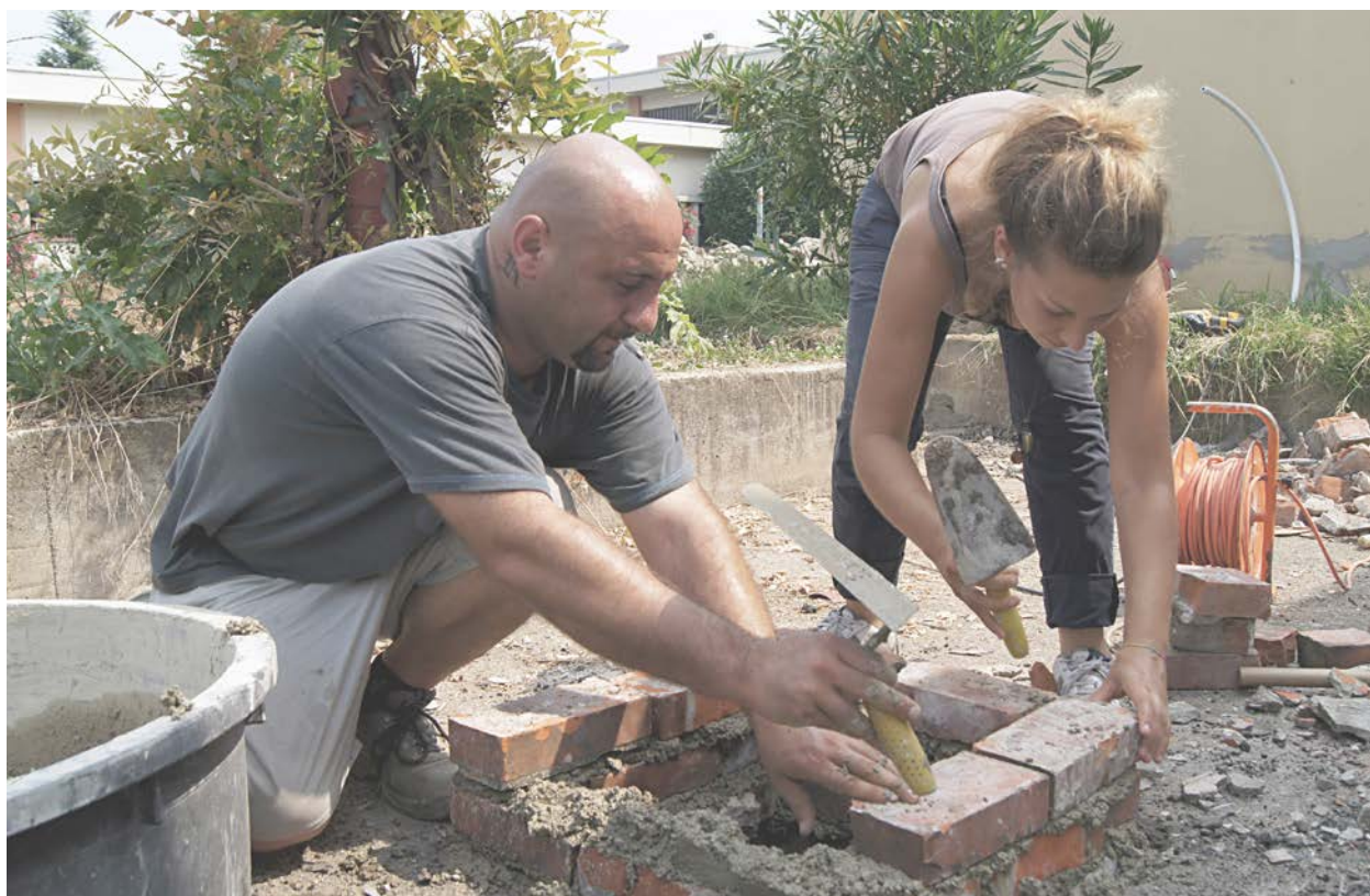
25. La sopraelevazione del pozzetto.
