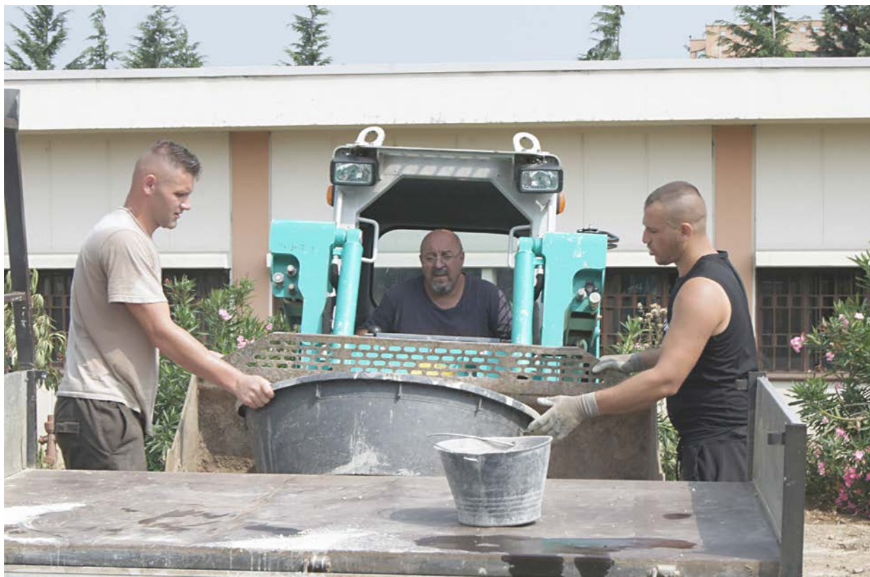
22. La cooperazione è importante per procedere nei lavori: detenuti e agenti, detenuti e studenti, studenti e agenti.
