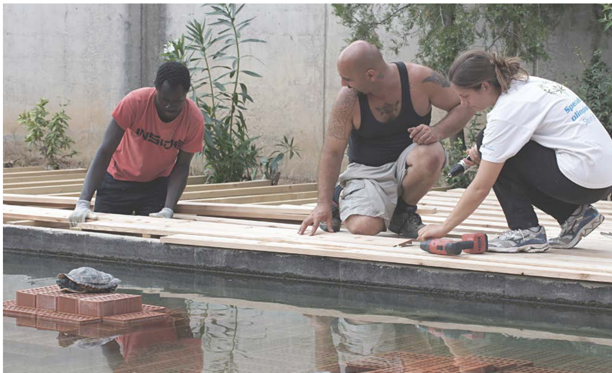
71. Il rivestimento della pedana.
