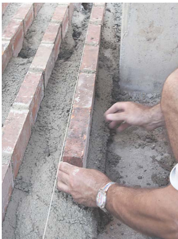
30. Per mettere in linee parallele i mattoni si usa la "lignola".
