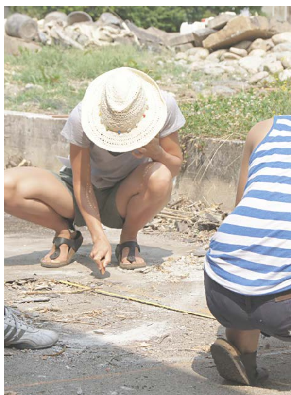
9. Con gli studenti si traccia la posizione dei nuovi cordoli.
