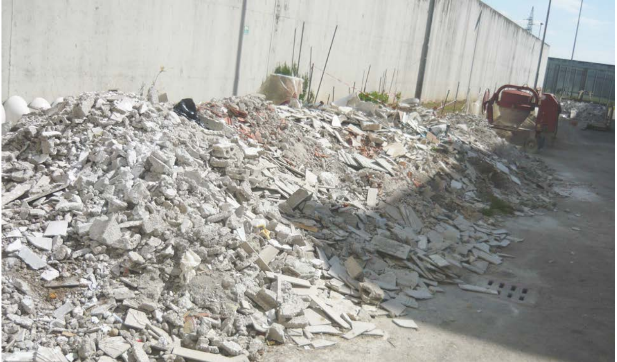
Le macerie prodotte dopo le prime demolizioni
