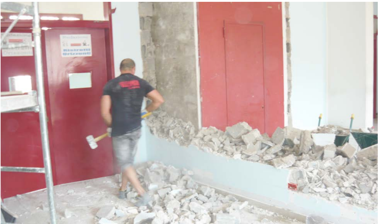
I lavori di demolizione: la cartella che conteneva queste foto è stata inviata a chi scrive dalla cooperativa col titolo “muri cadono”
