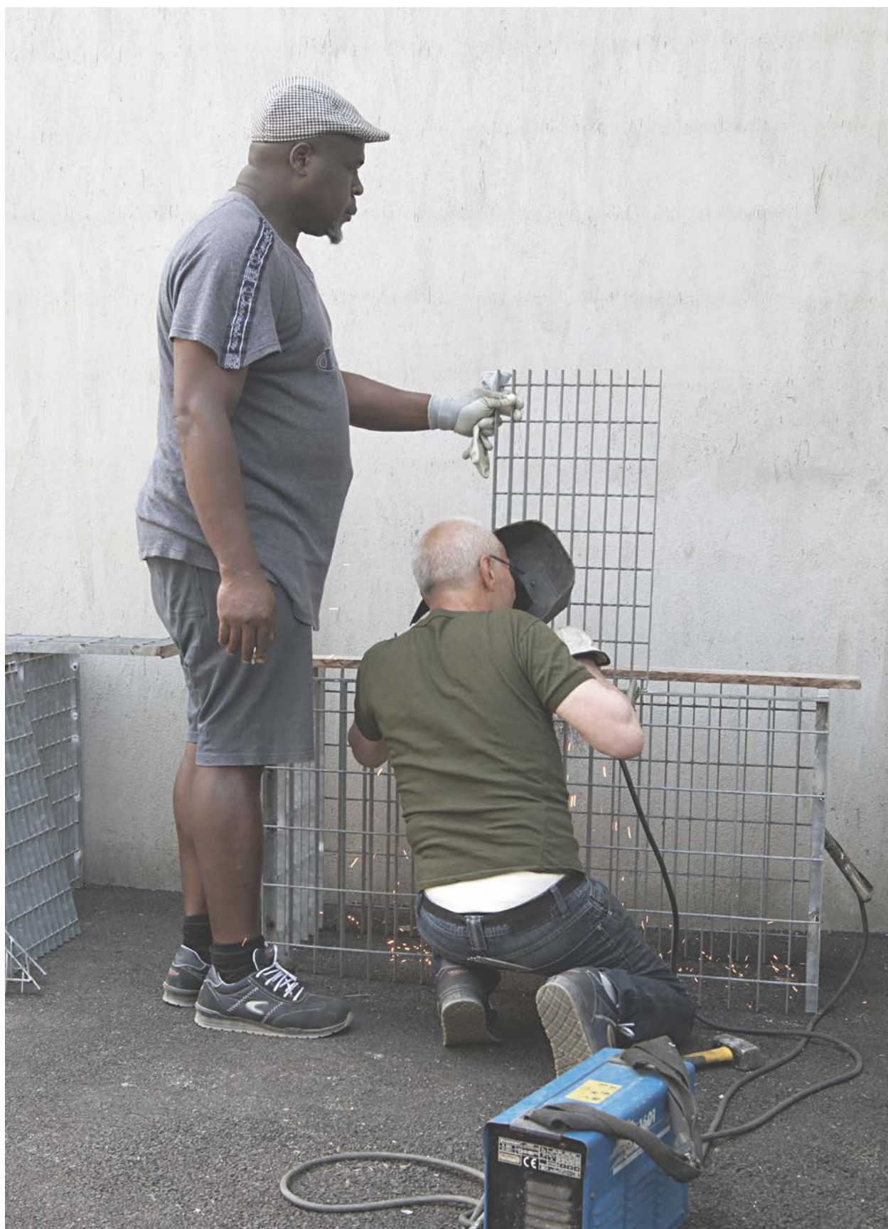
19. Il fabbro continua a tagliare e saldare l'orsogril.
