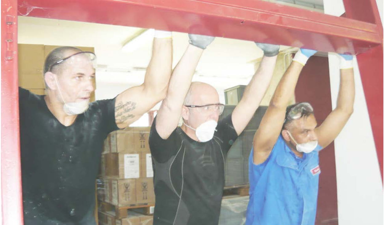
La rimozione del telaio della vecchia porta del laboratorio Fischer.
