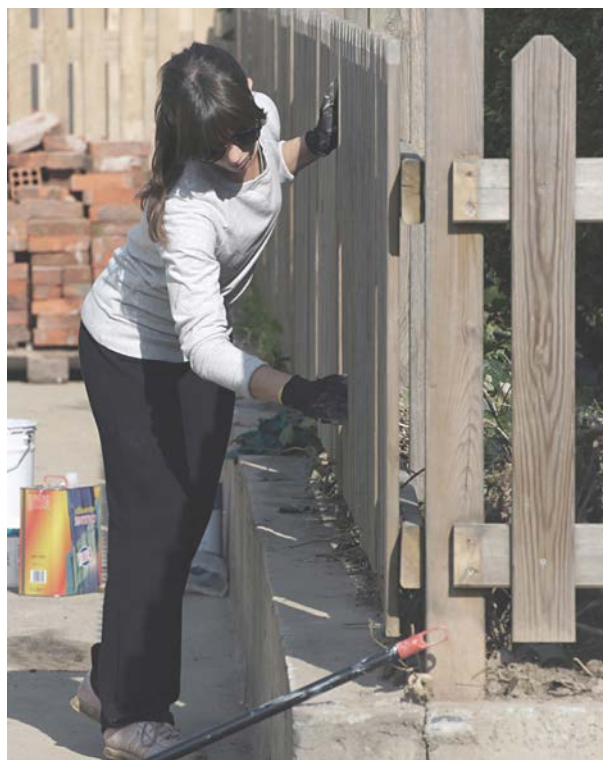
85. L'installazione della recinzione.
