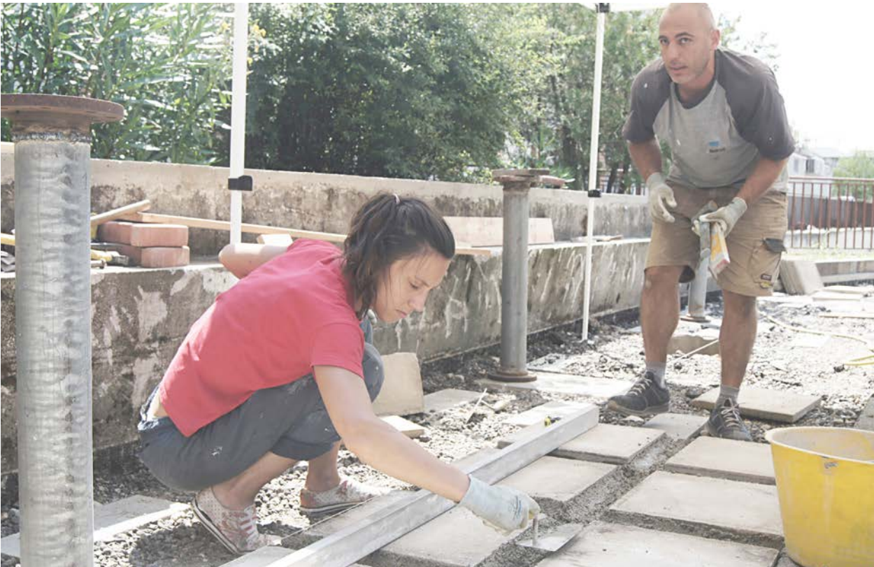
39. Intanto nell'area 2, dove si è rotto il cemento e si sono predisposti i plinti di fondazione, si inizia la posa della pavimentazione.
