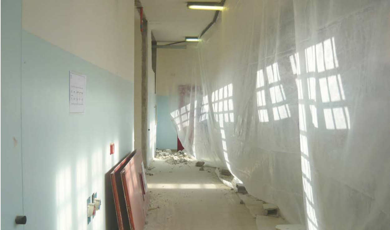
La messa in sicurezza del corridoio durante le demolizioni.
