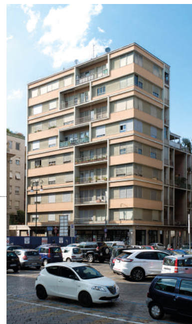
1951-1955 Edificio residenziale dell'ISM, Barcellona, José Antonio Coderch
