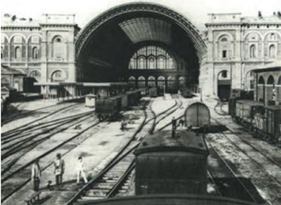
Figure 2: Torino Porta Nuova, the passengers' building and the iron arches of the roof. (L. Ballatore, Storia delle ferrovie in Piemonte, Il Punto: Torino , p. 151, 1996)
