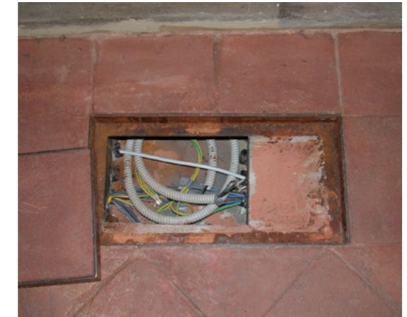
Predisposizione dei punti di alimentazione per elettricità e trasmissione dati. Realizzazione dei chiusini
