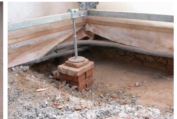
Realizzazione vani ventilconvettori
