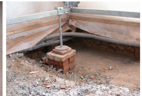
Realizzazione vani ventilconvettori
