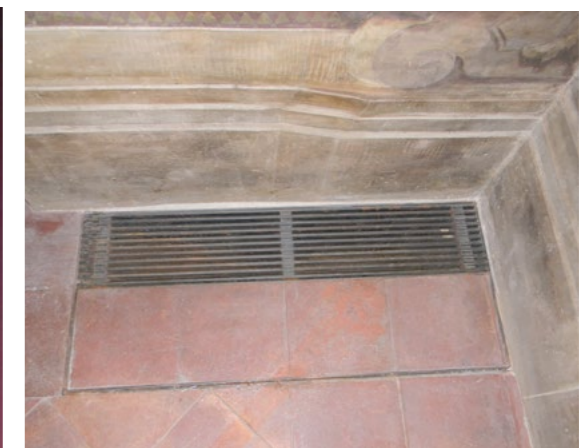
Griglie di aspirazione e di mandata impianto termico
