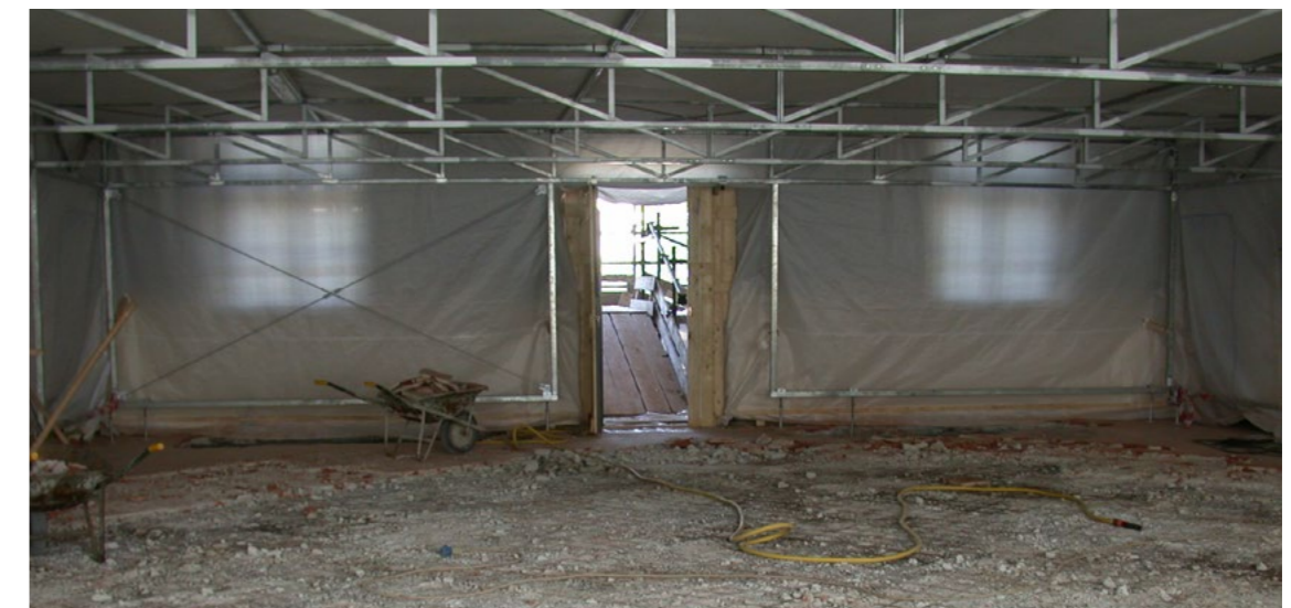
Rimozione della pavimentazione
