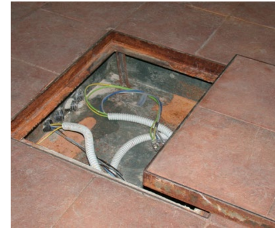
Predisposizione dei punti di alimentazione per elettricità e trasmissione dati. Realizzazione dei chiusini
