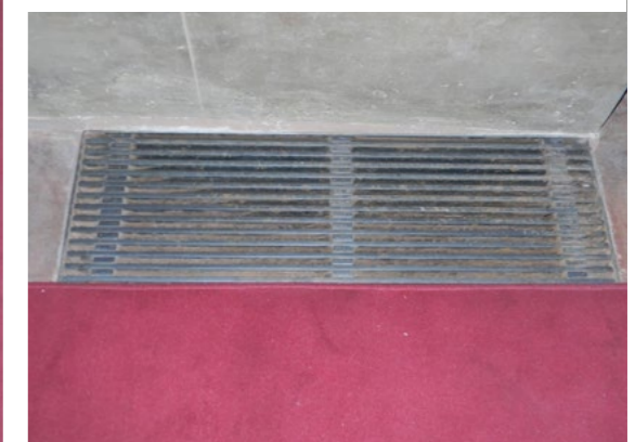
Griglie di aspirazione e di mandata impianto termico
