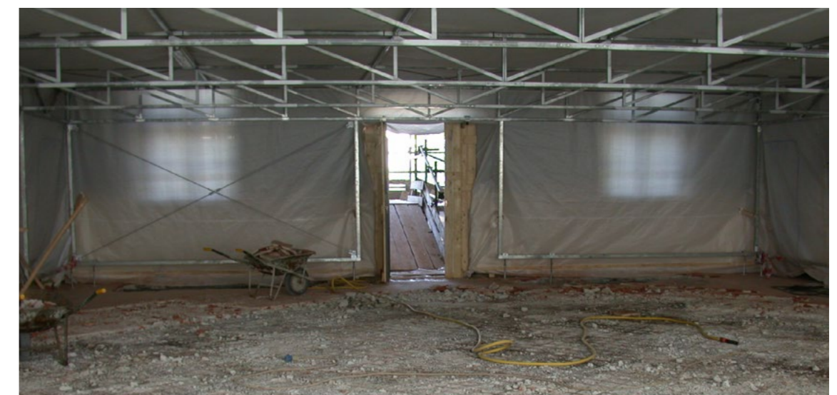
Rimozione della pavimentazione
