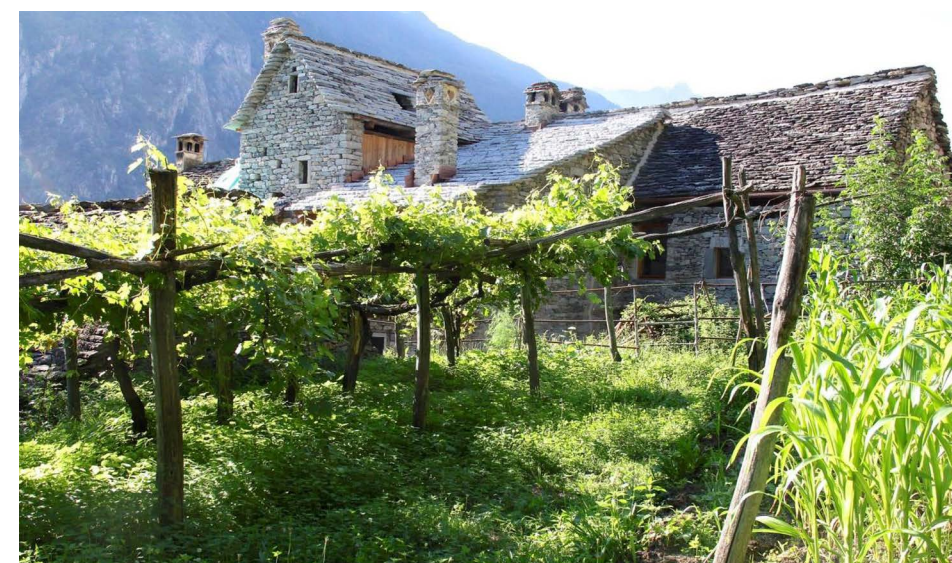
Fig. 2 Scorcio di un villaggio in corso di autorecupero spontaneo nell'alta Ossola (VB).
