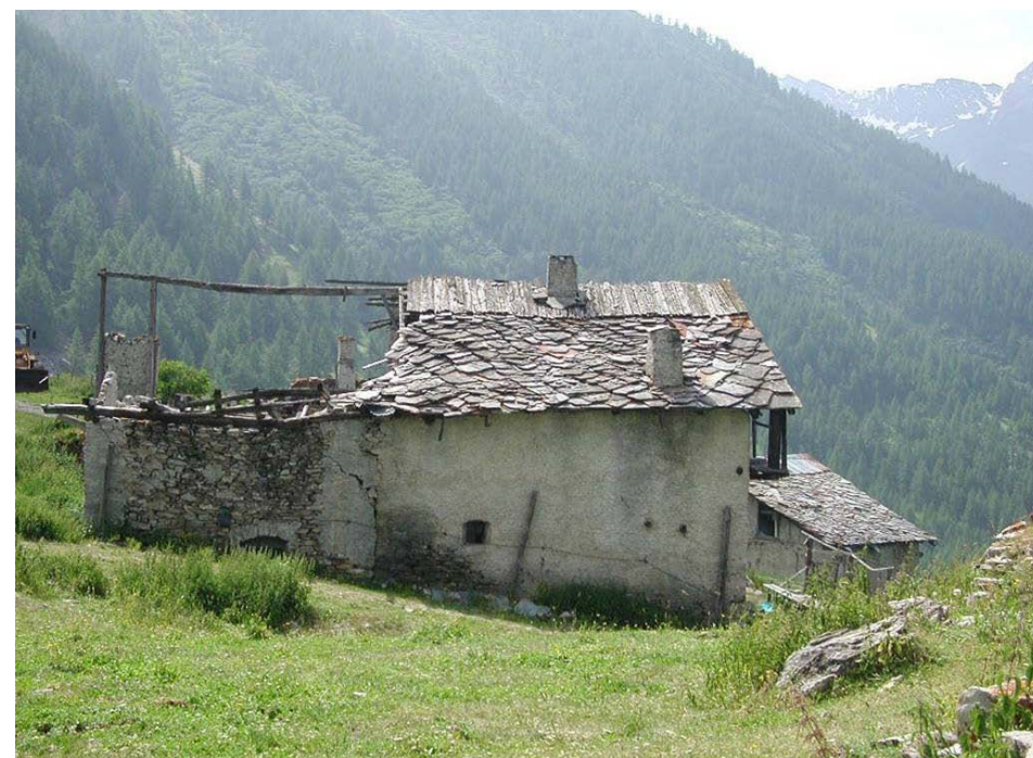
Fig. 1 Edificio d'alpeggio in abbandono, val Tronca, Pragelato (TO).
