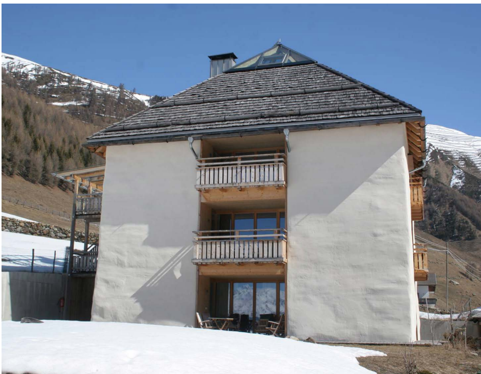
Fig. 5 Haus Fliri, Graun im Vinschgau (BZ), fronte ovest.
