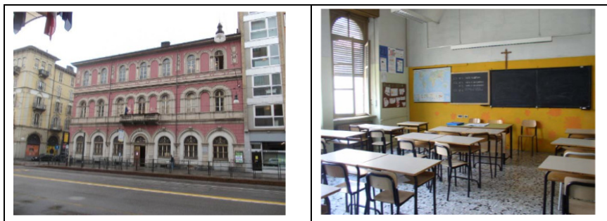
Fig. 1. - Dal Piaz primary school.
