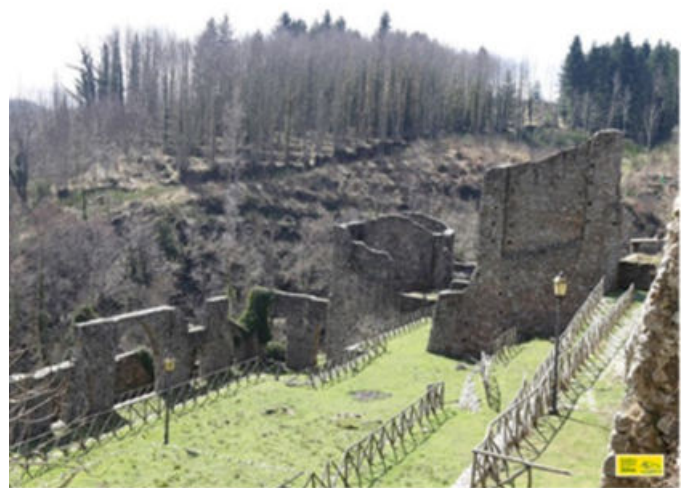
Fig. 2 - Mongiana, Rovine degli impianti di produzione del ferro (fonte: Parco delle Serre, 2015)
