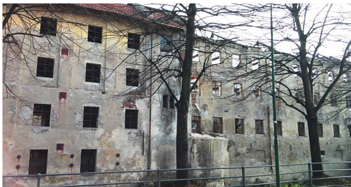
Fig. 19 La parte più antica del Follone e la sua sopraelevazione, caratterizzata dalla presenza di paraste, giustapposta alla porzione ormai a rudere (foto: R. Rudiero)
