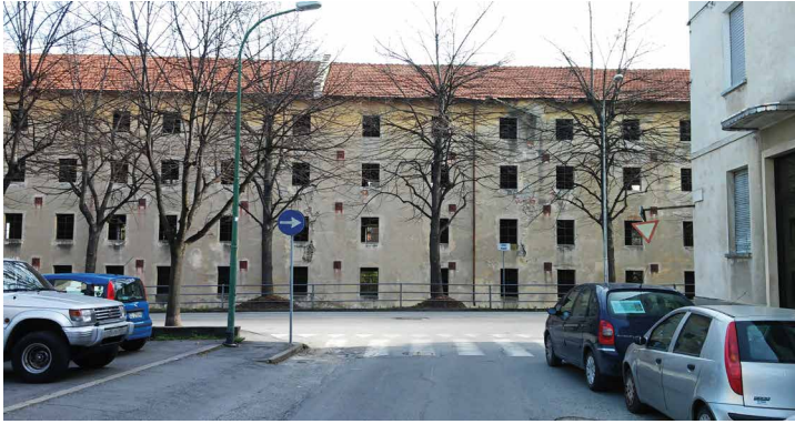
Fig. 10 Il prospetto dell'ex merlettificio Türk lungo il Moirano, caratterizzato dalla scansione regolare delle finestre (foto: R. Rudiero)
