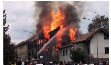
Fig. 4 Pinerolo (TO). Lavori di abbattimento del complesso della Fabbrica Elettrodi della Società Talco Grafite Val Chisone (foto: M. Calliero)
