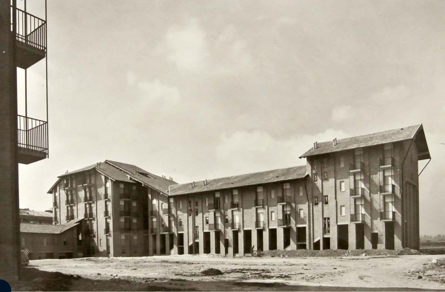
4.13 Quartiere Le Vallette: gli edifici del settore G in costruzione nel 1960. (Archivio ATC Torino, Faldone n. 1 Busta 13)
