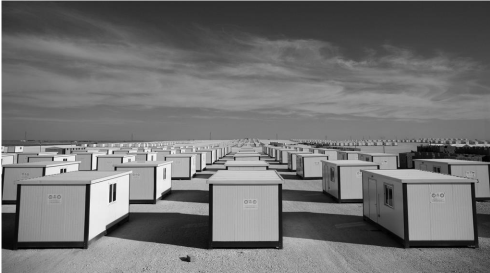
Fig. 8 – Shelter secondo la pianificazione UNHCR, Zaatari (Giordania)
